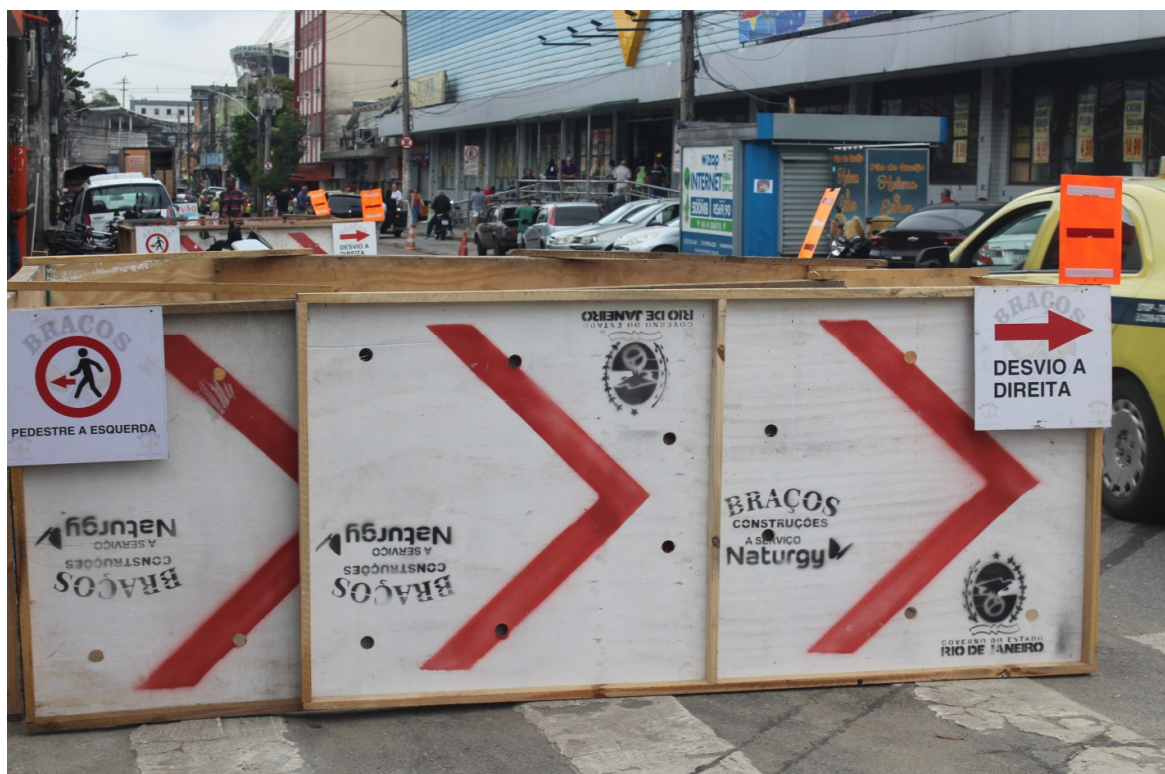
Foto 11: Isolamento e sinalização
