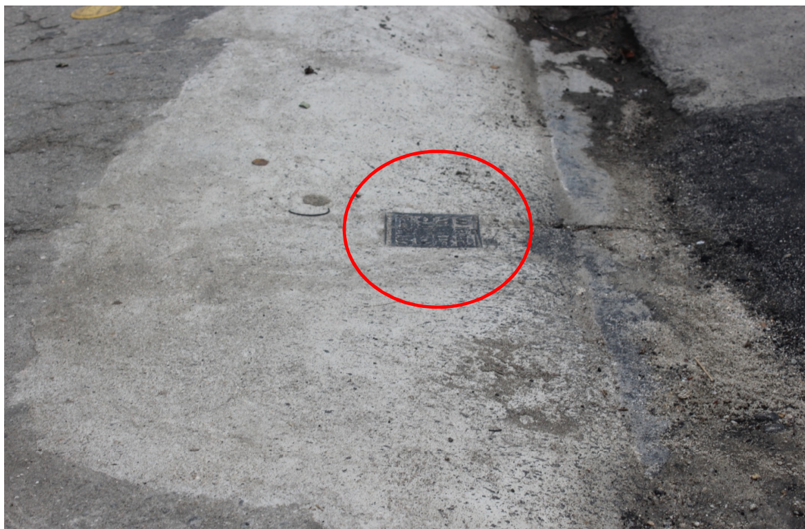
Foto 7: Válvula de ramal e recomposição do passeio
