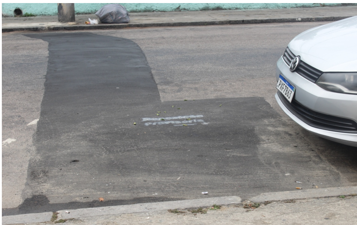
Foto 4: Recomposição provisória em travessia de rede
