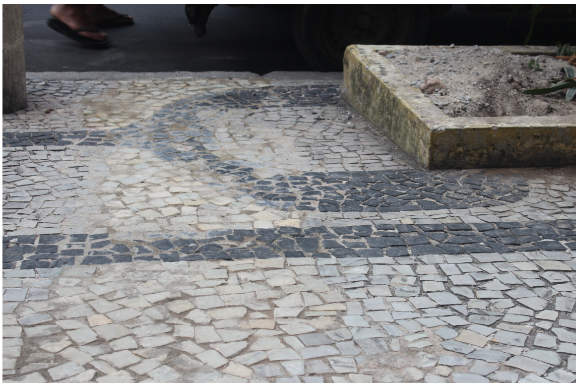
Foto 13: Recomposição do passeio (Construção de ramal)
