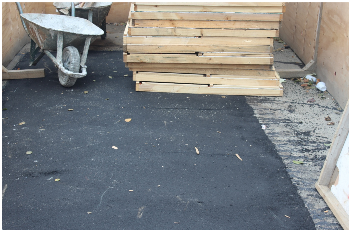
Foto 3: Ponto de início da obra (lado ímpar)
