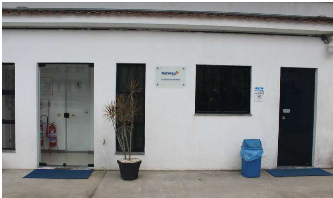
Foto 7: Sala de monitoramento da estação.
