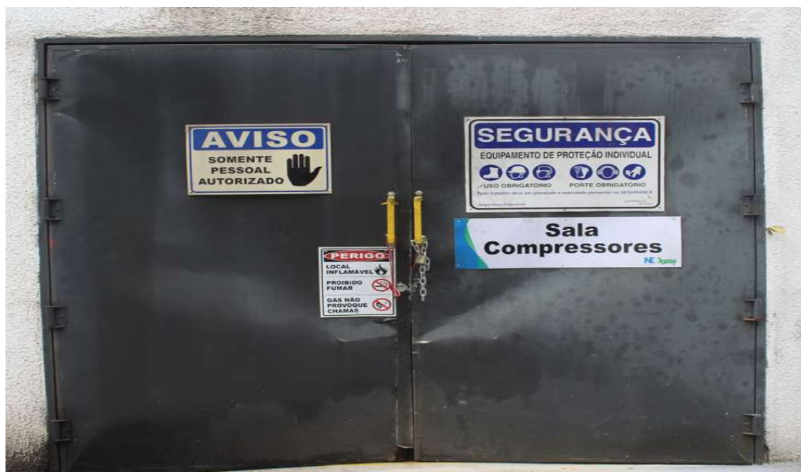
Foto 13: Acesso à sala de compressores.
