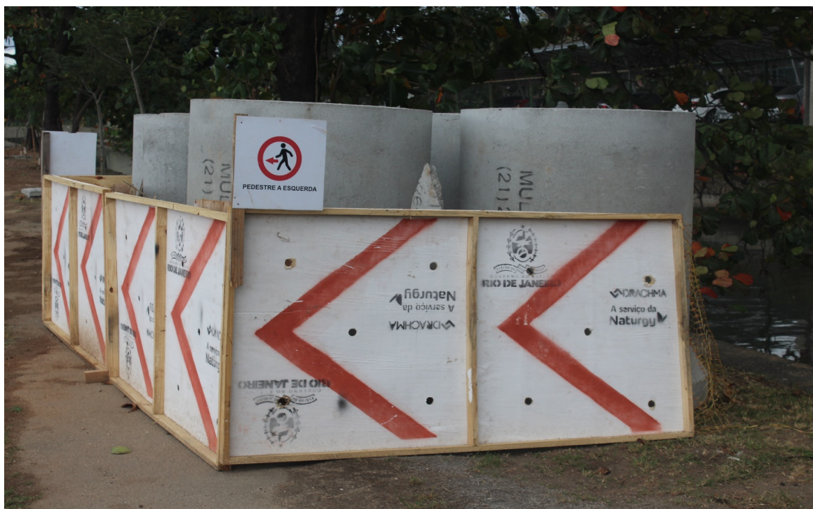
Foto 8: Isolamento e armazenamento de manilhas para reposição
