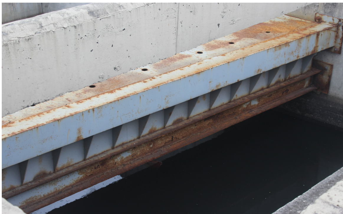
Foto 2: Tubulação de GN exposta em ponto de deságue da Prefeitura
