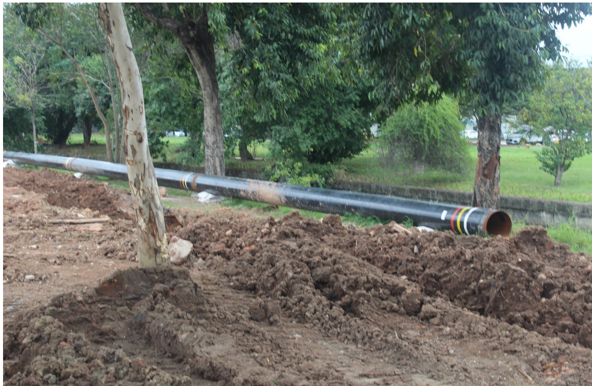
Foto 13: Tubulação sendo preparada para inserção
