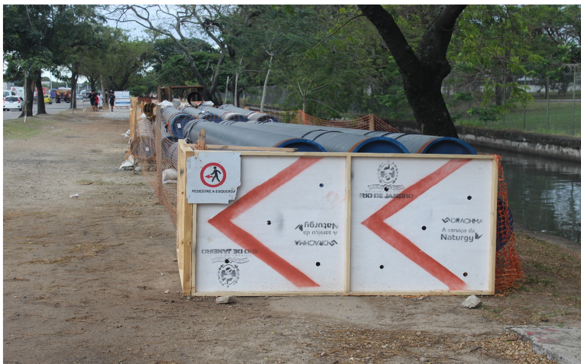
Foto 4: Armazenamento de tubos
