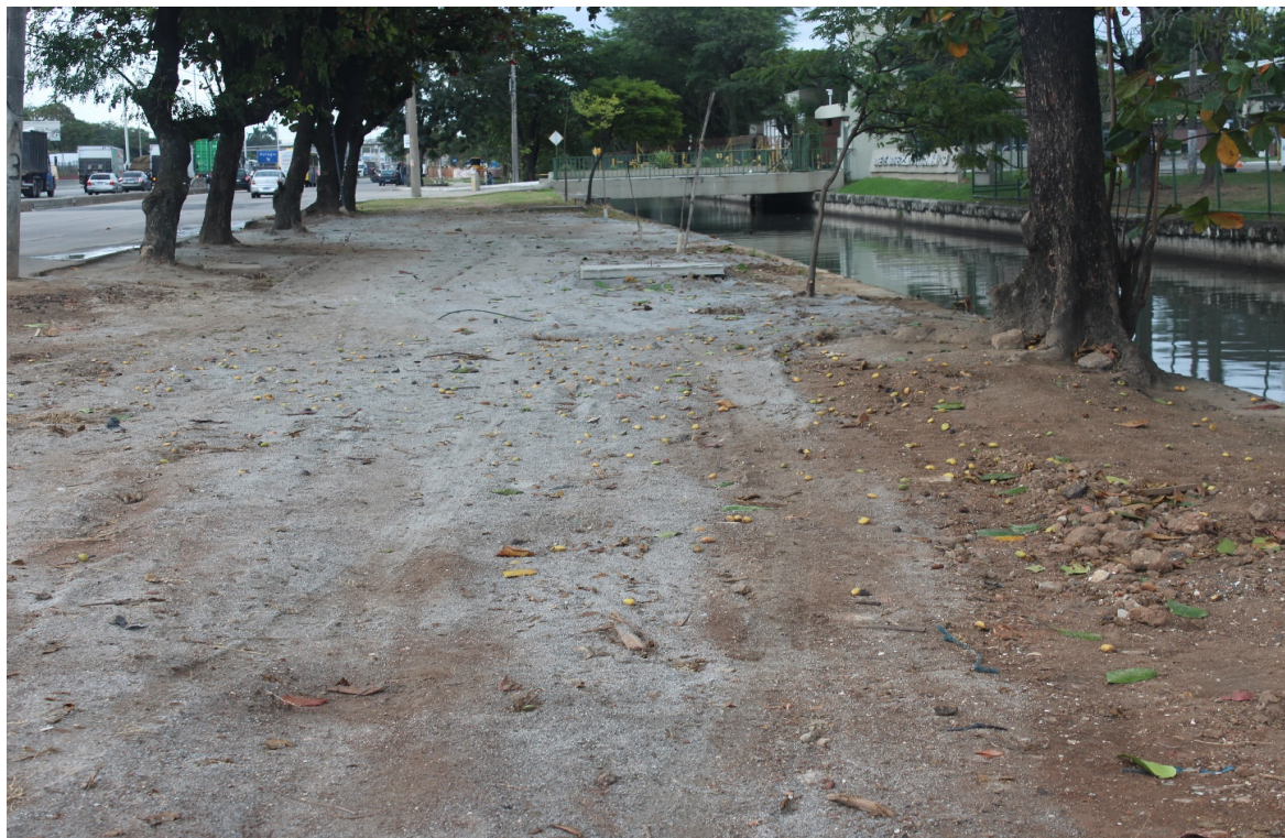
Foto 7: Trecho de obra concluída
