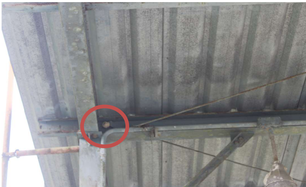
Foto 7: Presença de marimbondos e mau estado de conservação do telhado e luminárias
