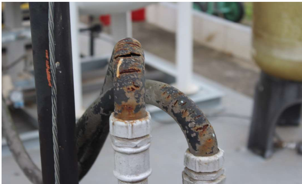
Foto 3: Conduíte elétrico do odorante
