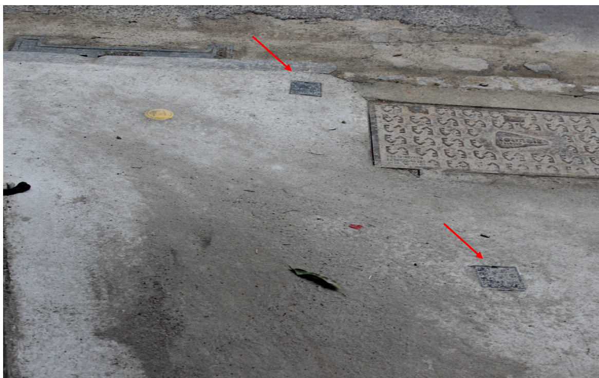
Foto 6: Válvula de ramal
