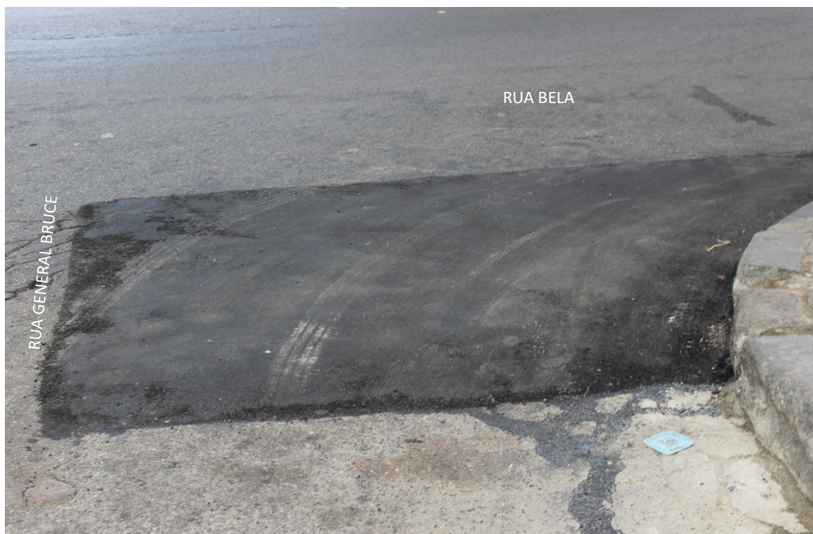
Foto 1: Ponto de início da obra
