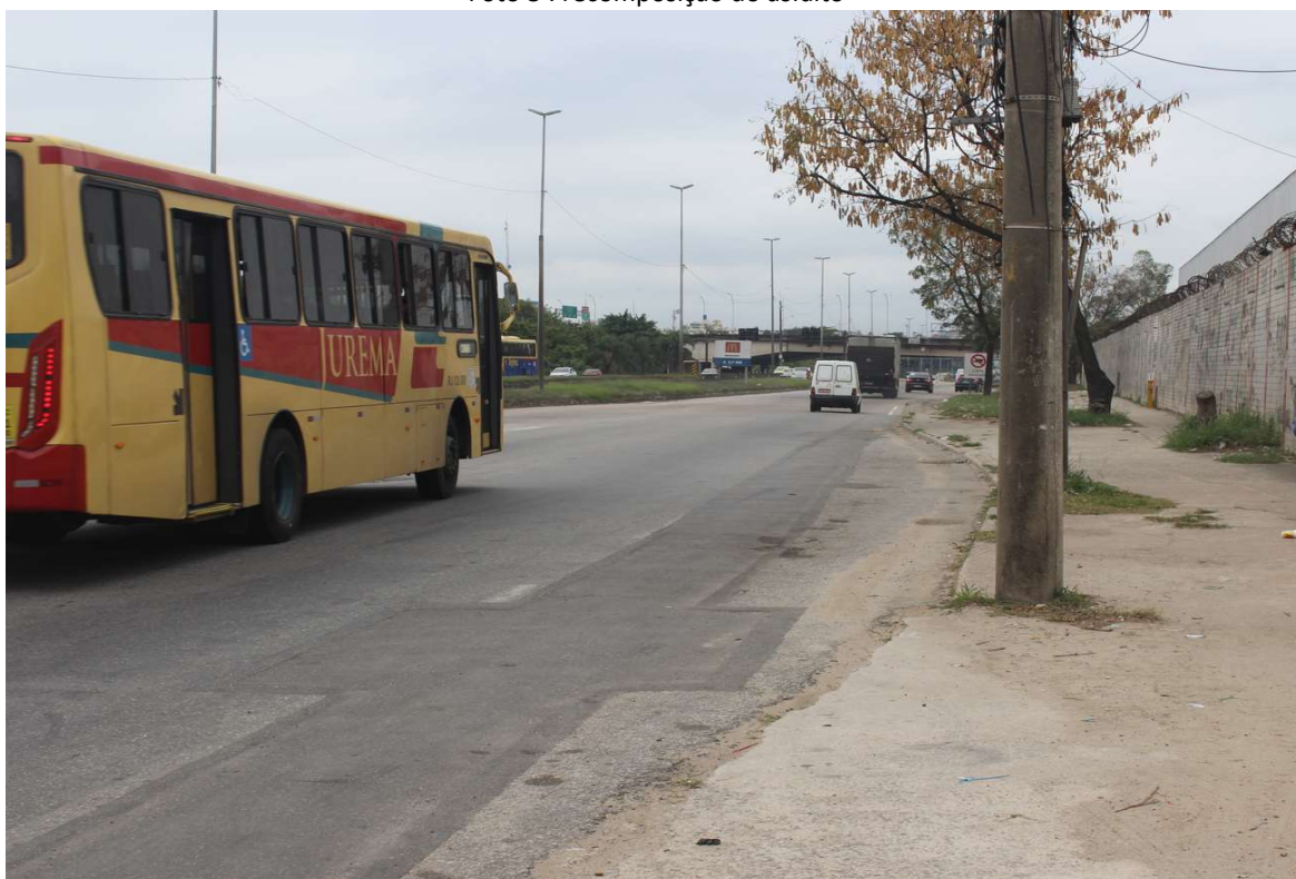
Foto 4 : recomposição do asfalto
