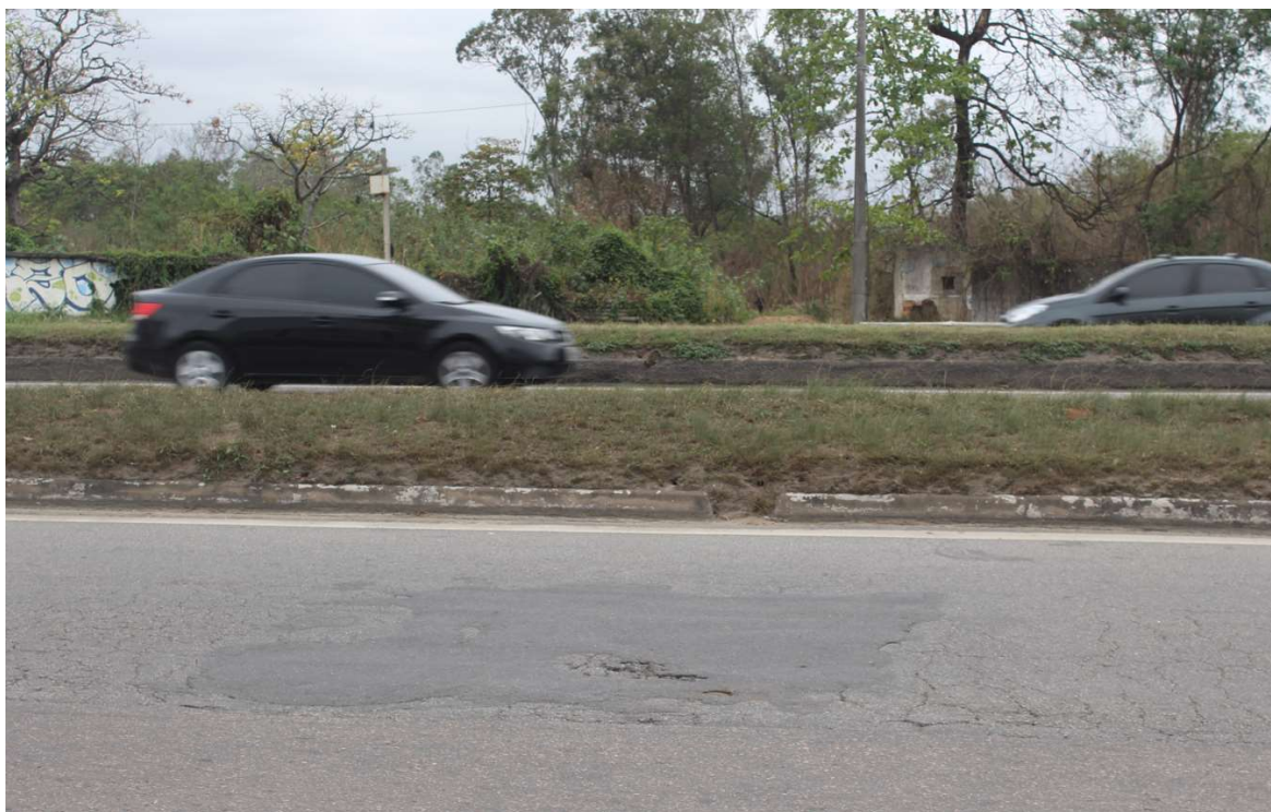
Foto 7 : recomposição com perda de material
