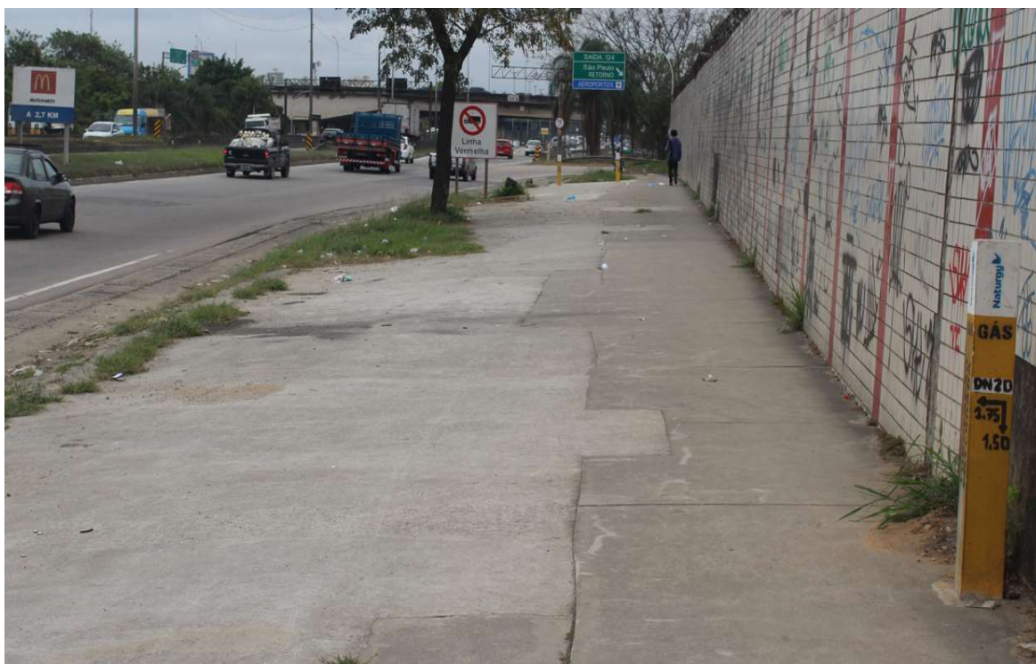
Foto 5 : recomposição da calçada e marco vertical indicando presença de rede
