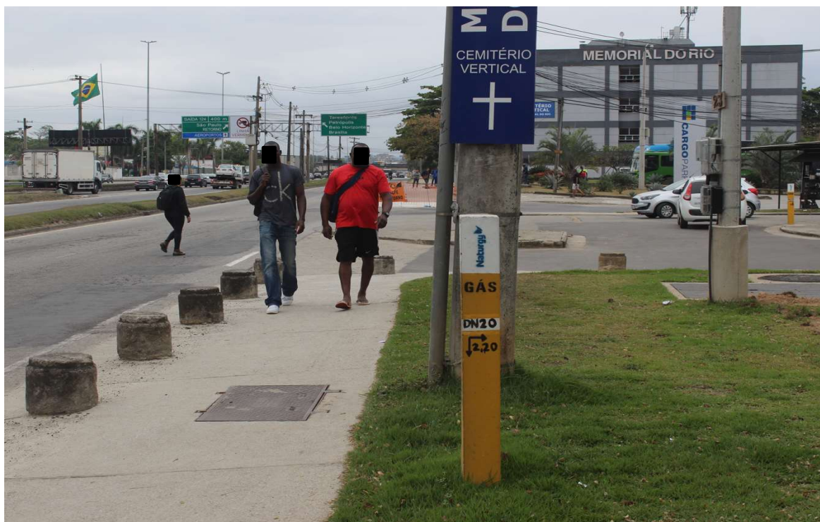
Foto 1 : marco vertical indicando presença de rede
