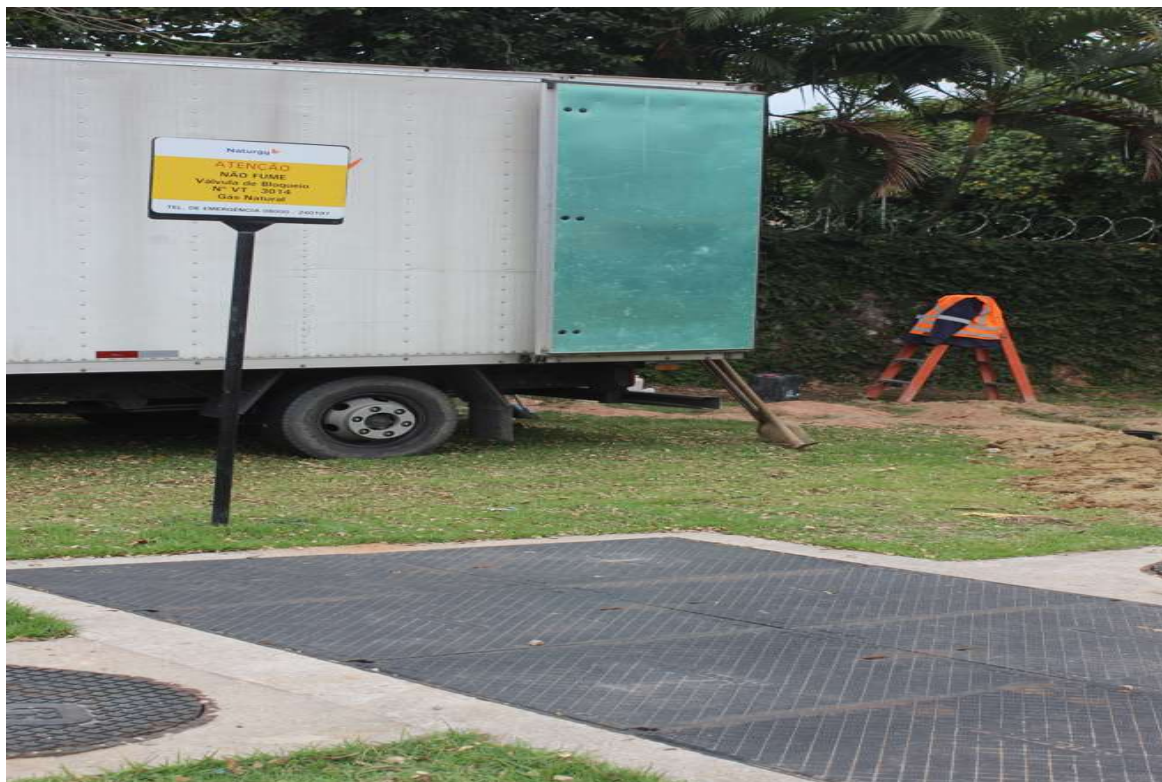
Foto 2 : ponto de telecomando
