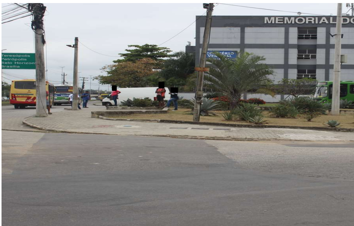
Foto 3 : recomposição do asfalto
