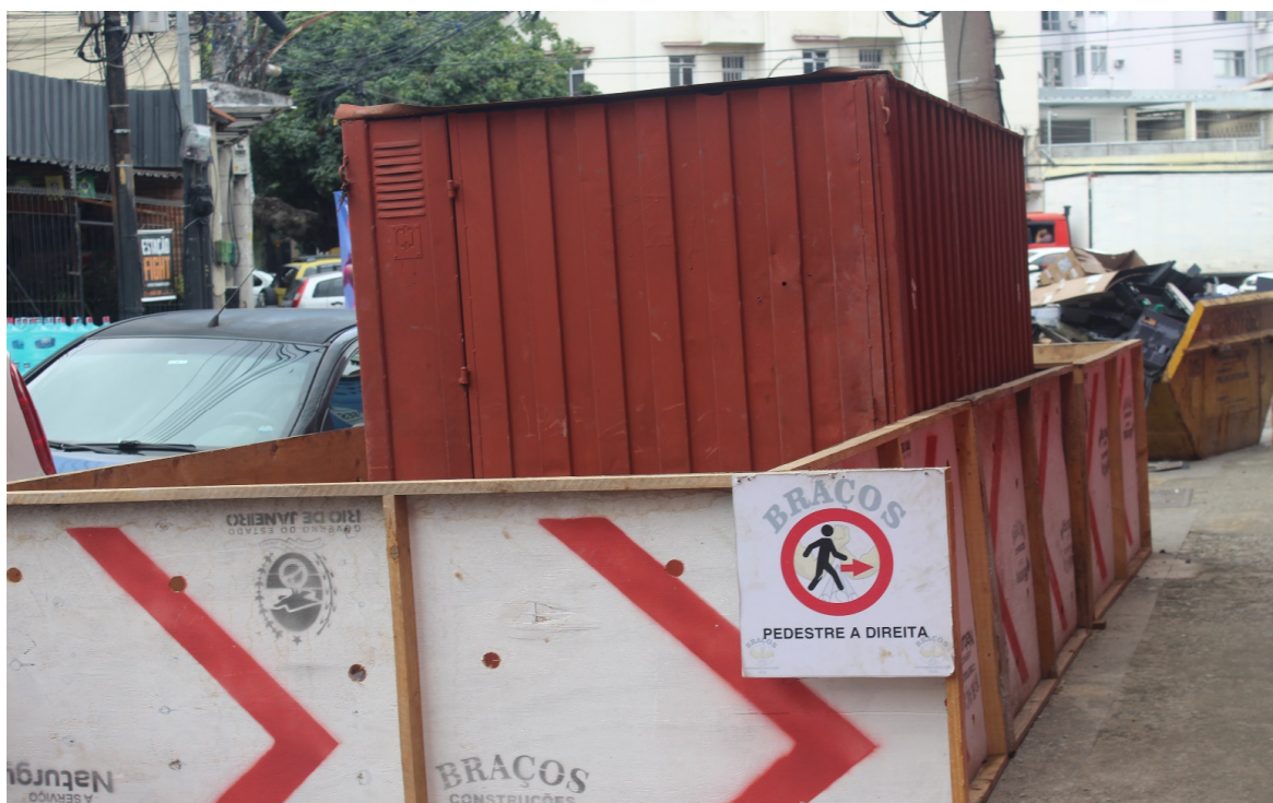
Foto 10: Armazenamento de material
