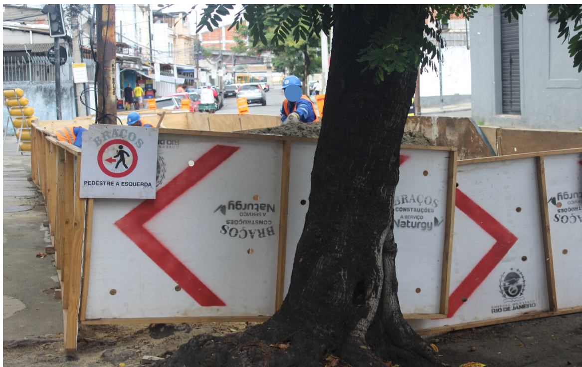
Foto 6: Isolamento e área de descarte (entulho)
