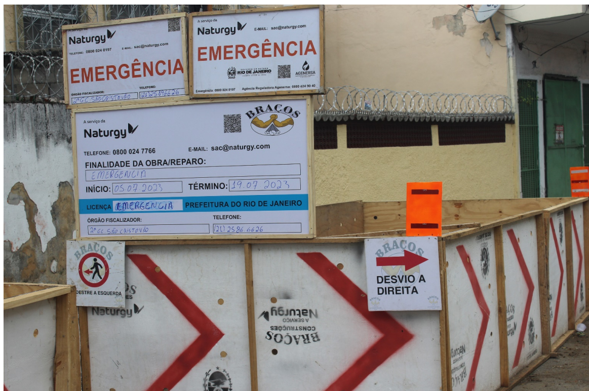
Foto 1: Identificação da obra e sinalização
