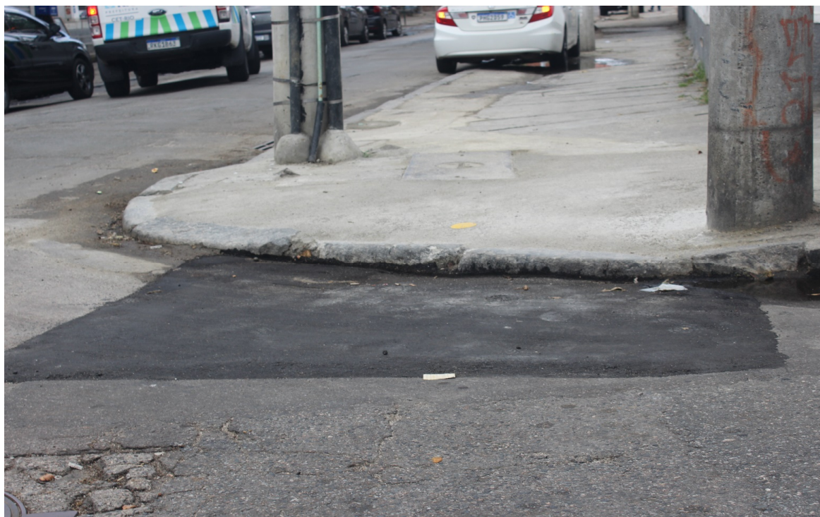
Foto 2: Ponto de início da obra (lado ímpar)
