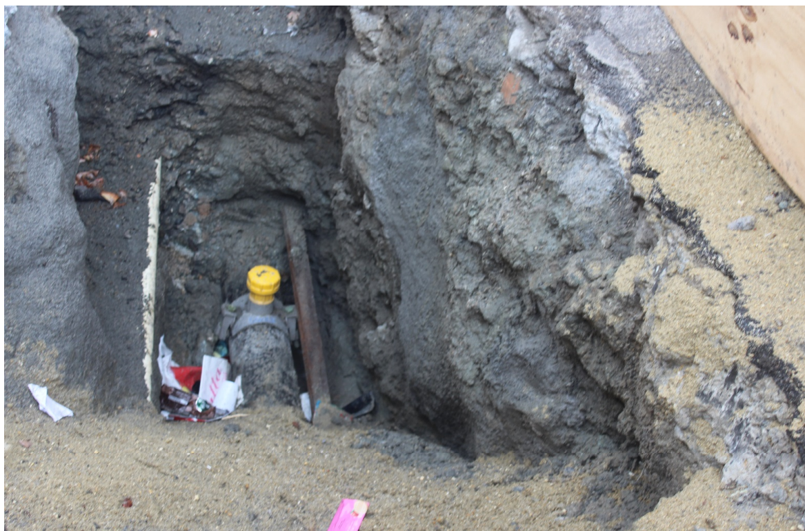
Foto 7: Ponto de sondagem
