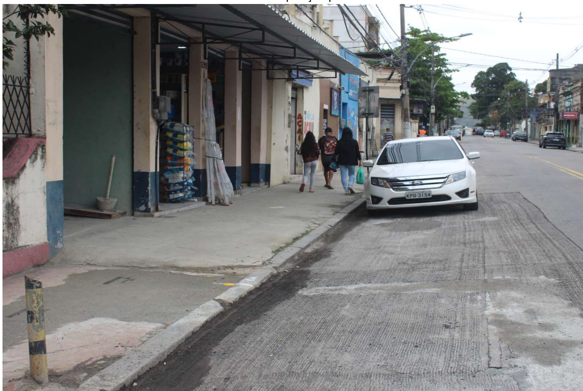
Foto 6 : fresagem onde será refeita a recomposição
