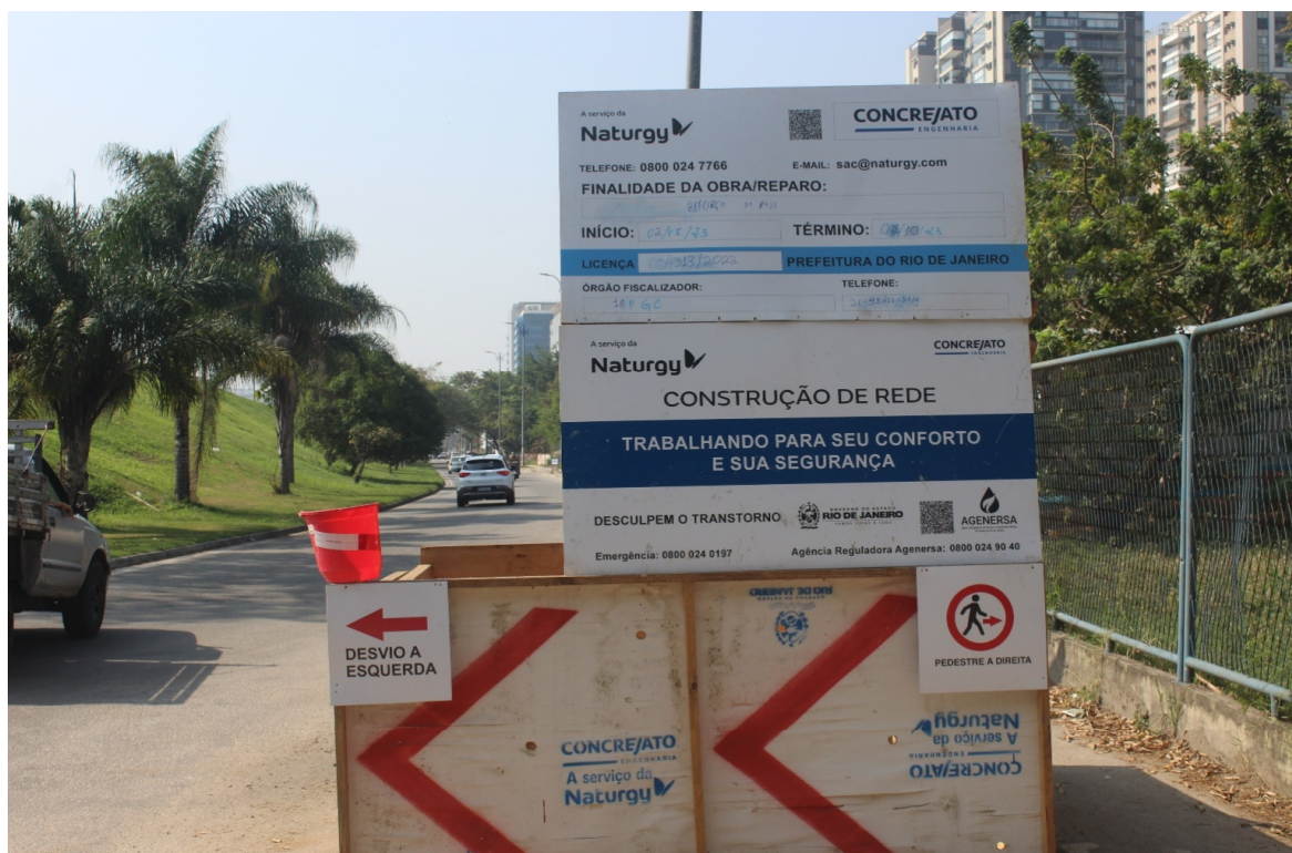
Foto 1: Identificação da obra e sinalização
