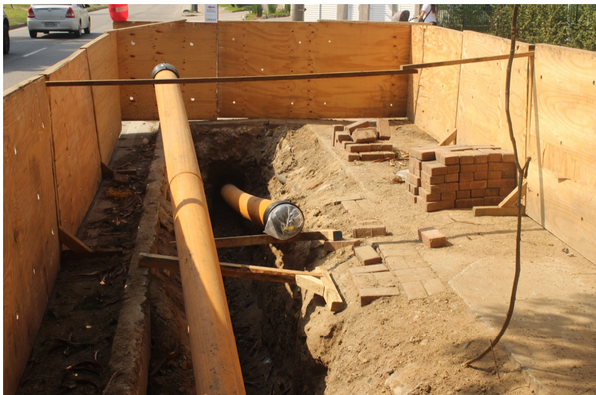
Foto 5: Rede PE 200 mm a ser conectada
