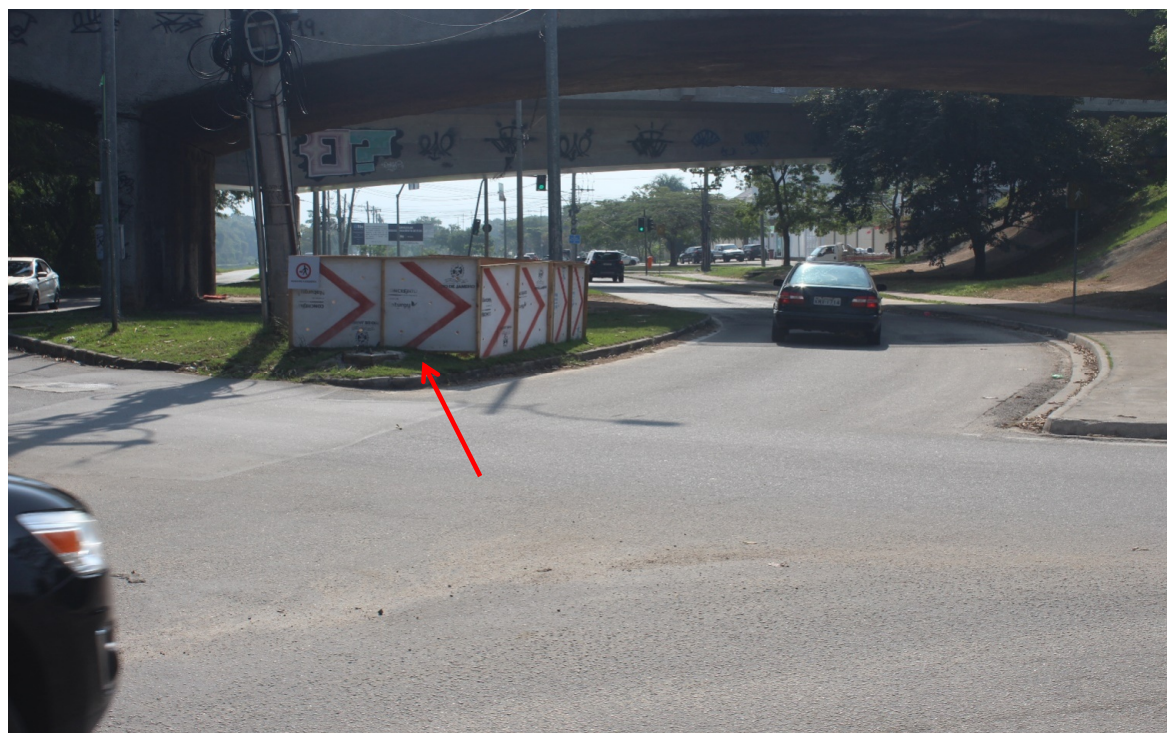
Foto 2: Ponto de interligação de rede
