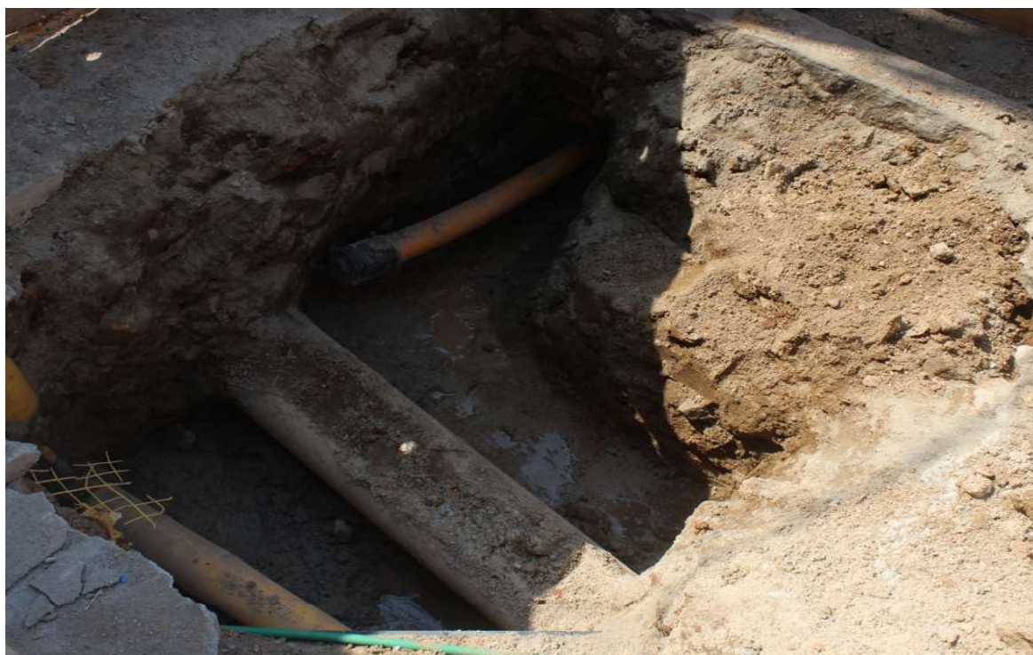
Foto 5 : Rede nova, com cape, que será interligada a rede existente.
