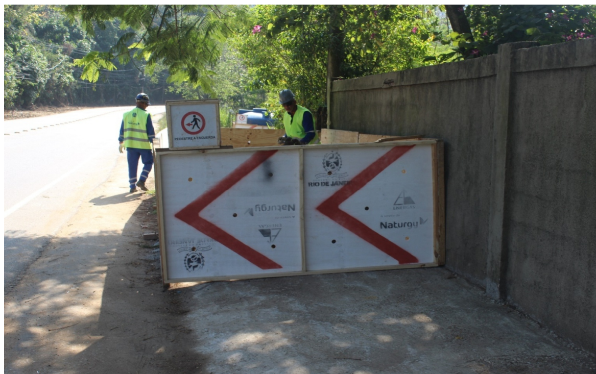
Foto 2: Ponto de início da rede construída
