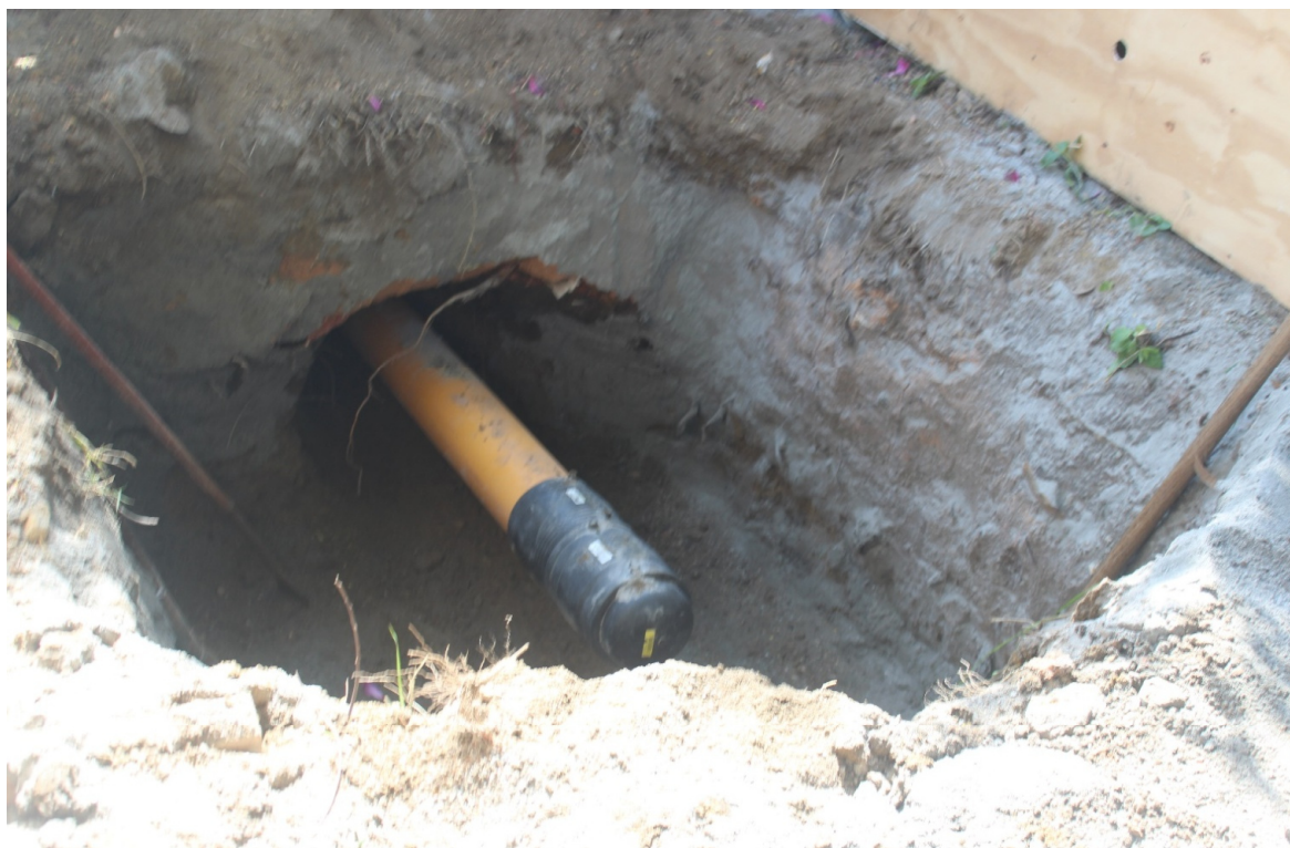
Foto 3: Rede PE 160 mm a ser conectada
