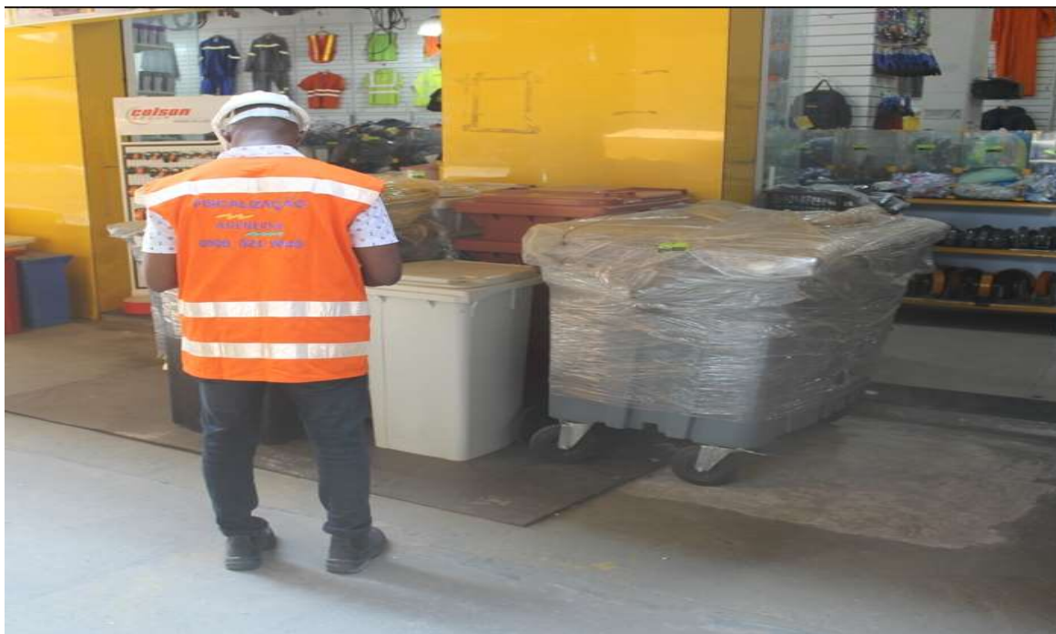
Foto 3 : Recomposição de calçada na AV. Dom Hélder Câmara, esquina com Rua Pires de Carvalho
