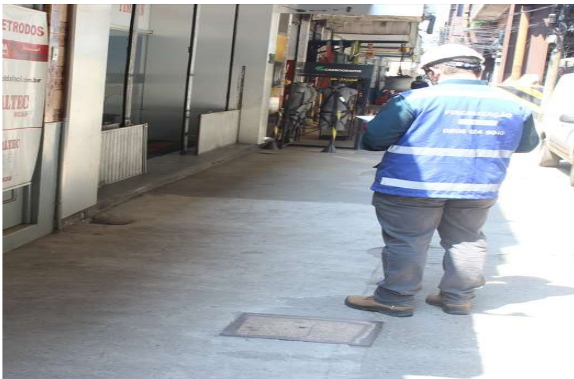
Foto 2 : Vistoria in loco da recomposição da calçada pela nossa equipe técnica.
