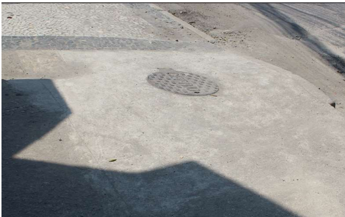
Foto 1 : Recomposição da calçada na rua Figueira de Melo, n.º 261.
