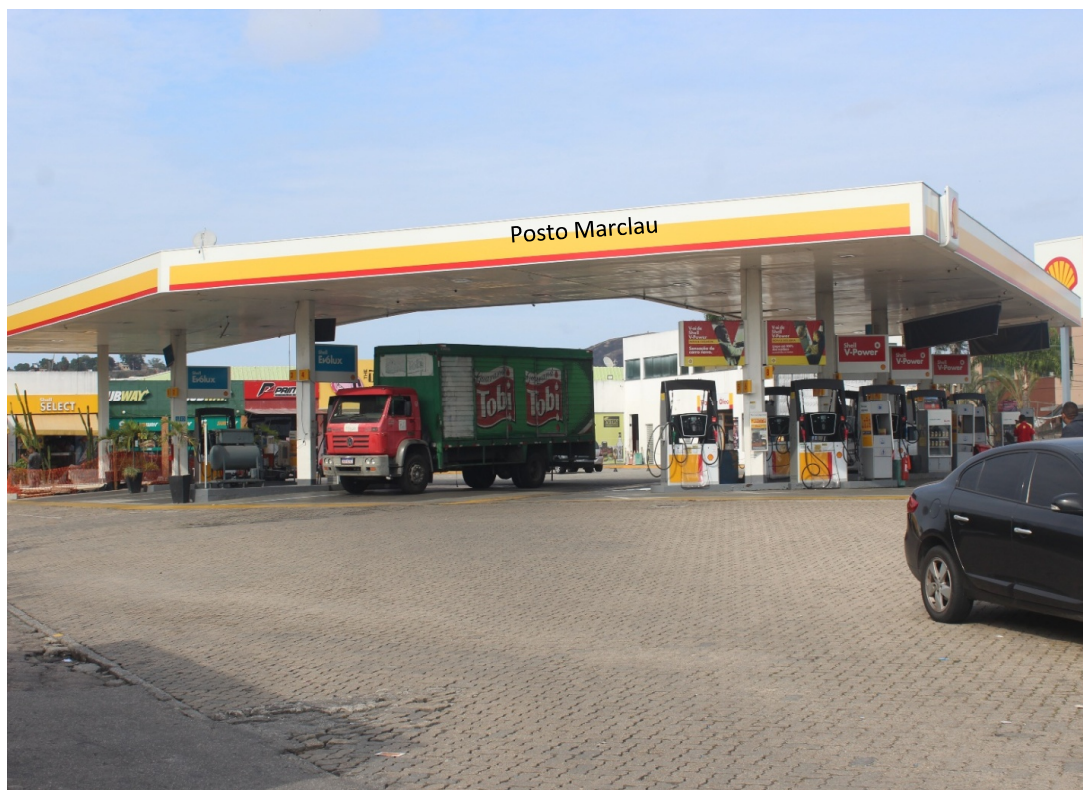
Foto 12: Posto de serviço abastecido com GN
