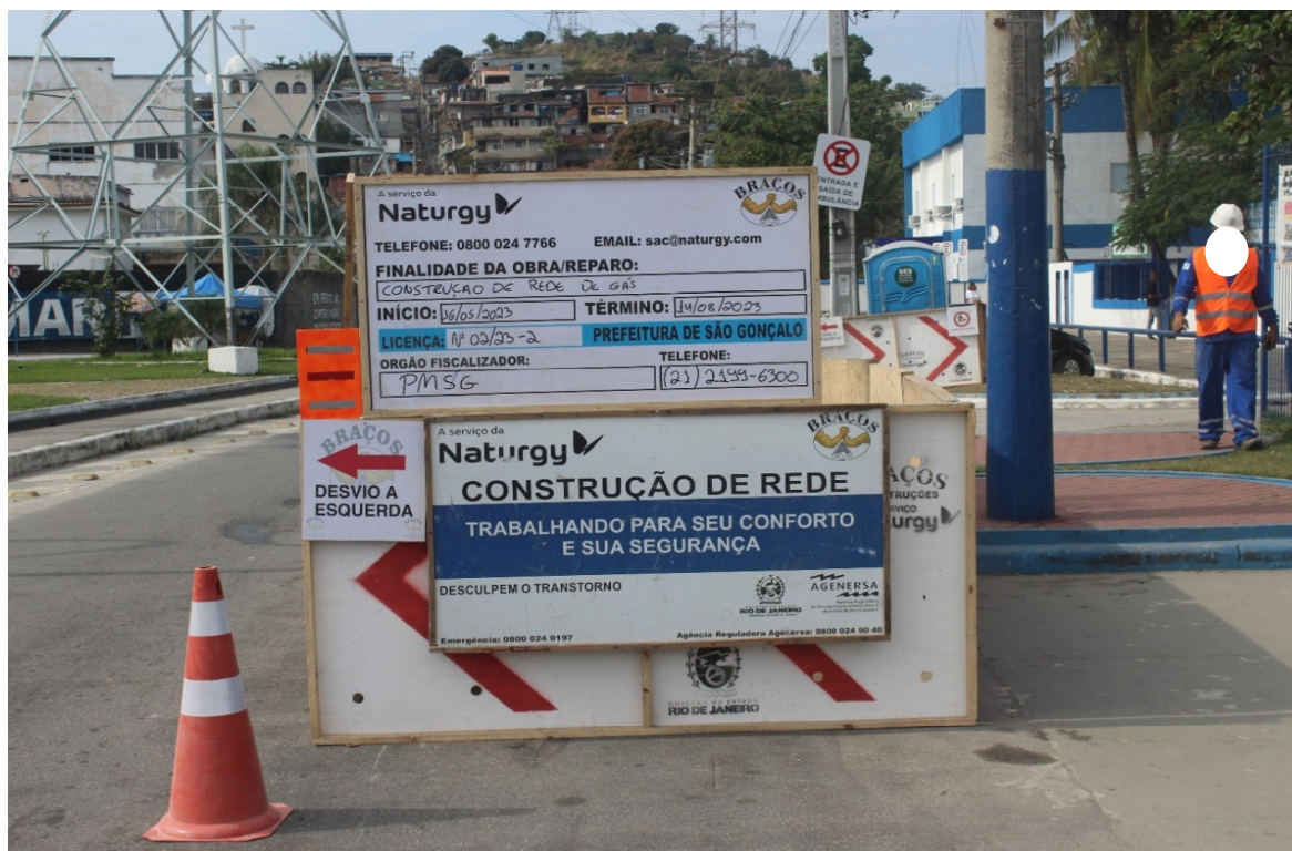
Foto 1: Identificação da obra e sinalização
