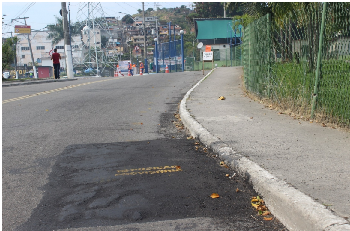
Foto 5: Recomposição provisória da via
