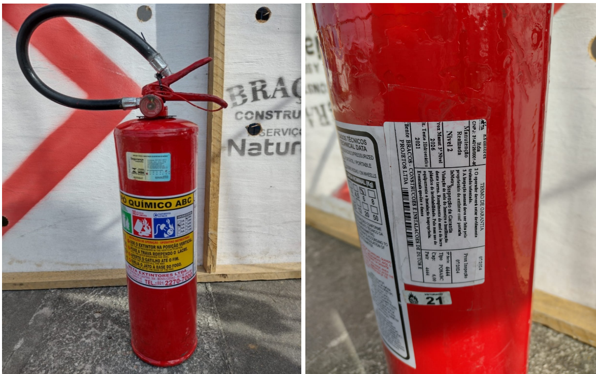
Foto 12: Extintor de Pó Químico substituído
