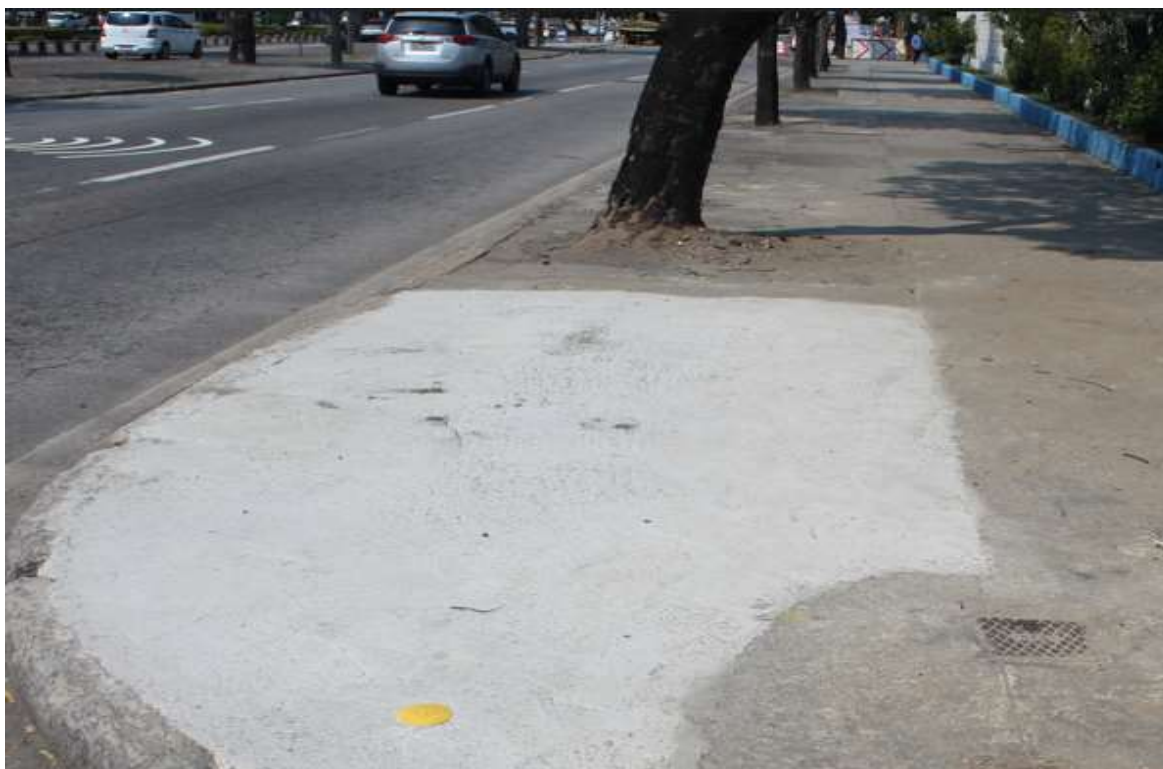
Foto 2 : Marco plano e reconstituição da calçada.
