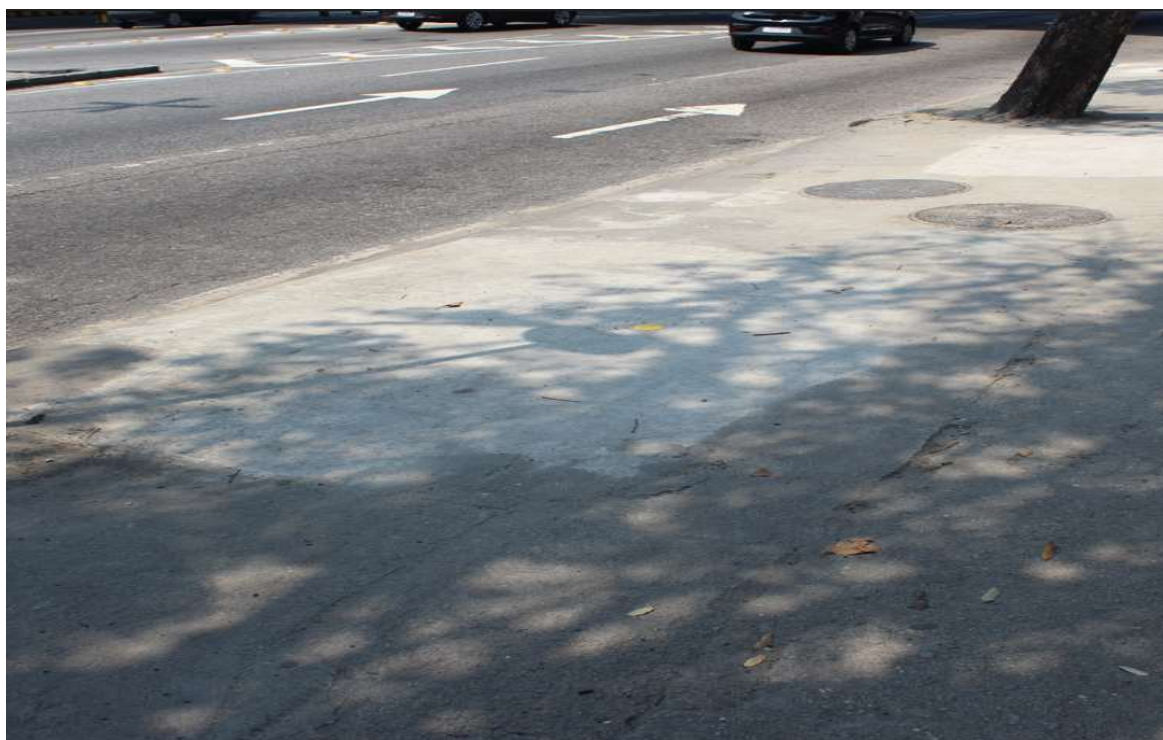
Foto 5 : Marco plano e recomposição provisória da calçada.
