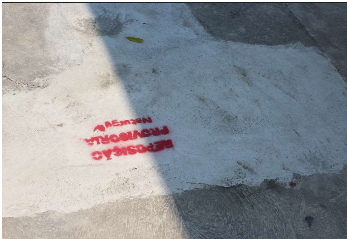
Foto 5 : Marco plano e recomposição provisória da calçada.
