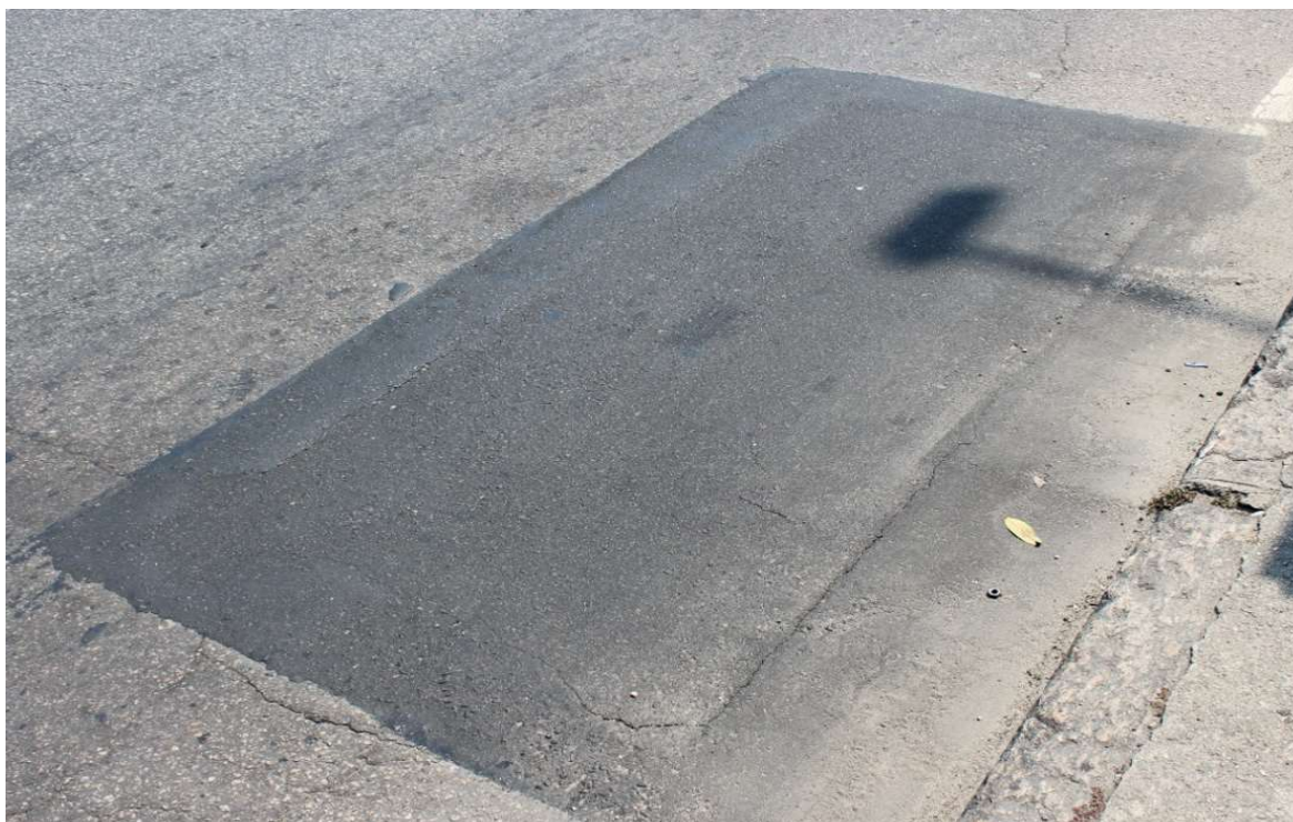
Foto 7 : Recomposição do trecho onde teve um afundamento n.º 2800 (antes).
