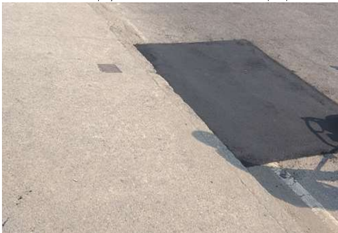
Foto 7 : Recomposição do trecho onde teve um afundamento n.º 2800 (antes).
