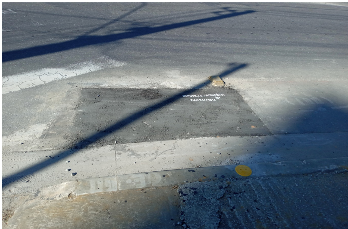
Foto 7: Recomposição provisória e marco plano
