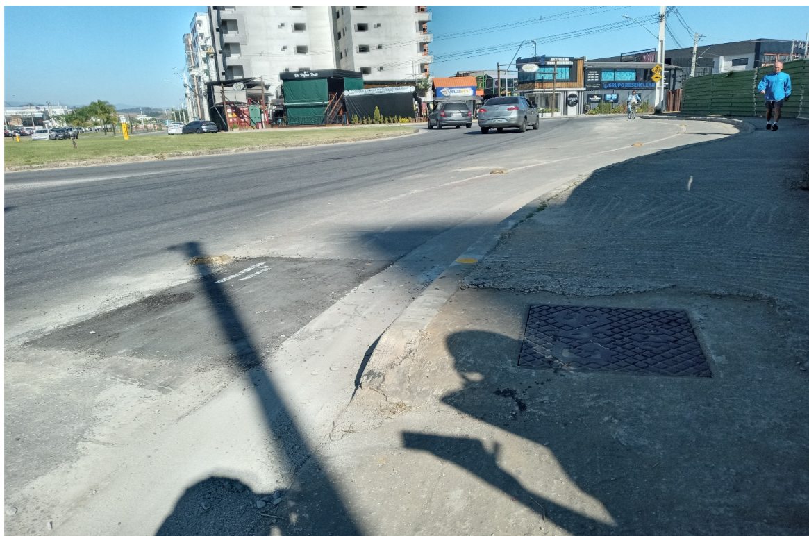
Foto 1: Ponto de interligação à rede existente
