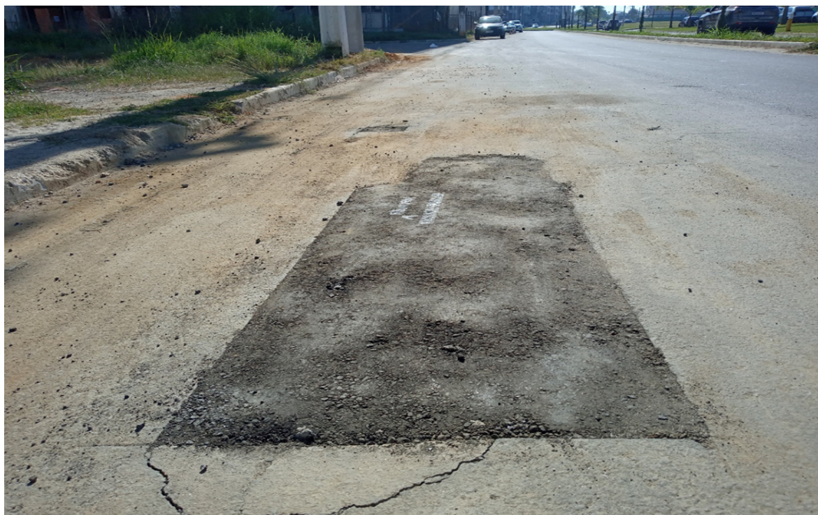
Foto 8: Recomposição provisória da via
