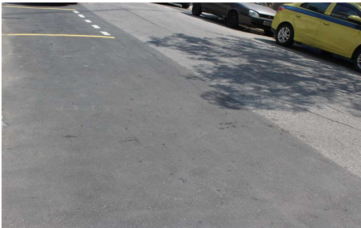
Foto 3 : Recomposição da pista no trecho da rua Almirante Baltazar, n.º 44 a 56.
