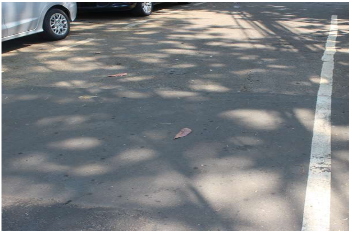
Foto 2 : Recomposição permanente da travessia na rua Almirante Baltazar n.º 8.
