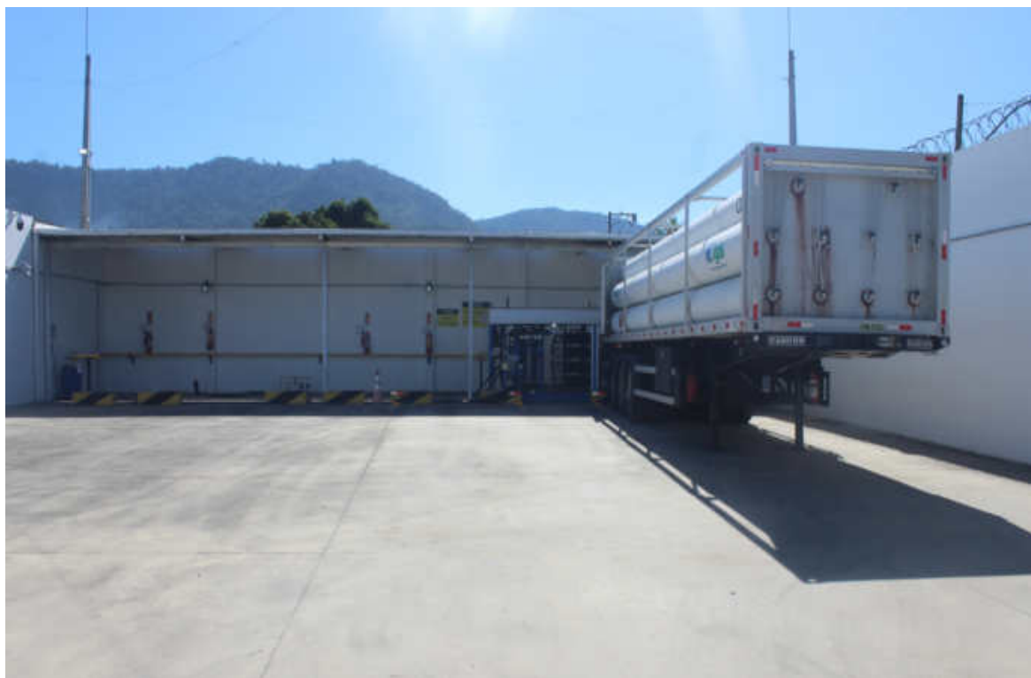
Foto 3: Pátio da entrada de caminhões
