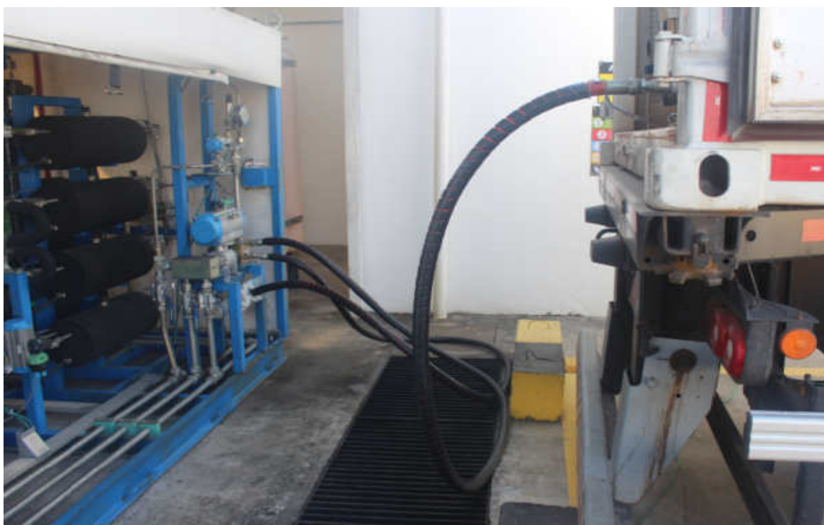
Foto 4: Acoplamento da mangueira ao cavalete
