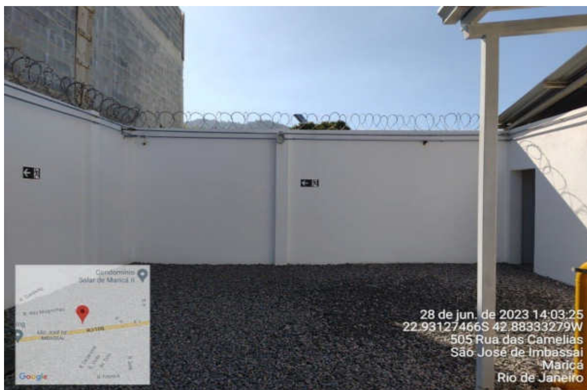
Foto 17: Sinalização de rota de fuga
