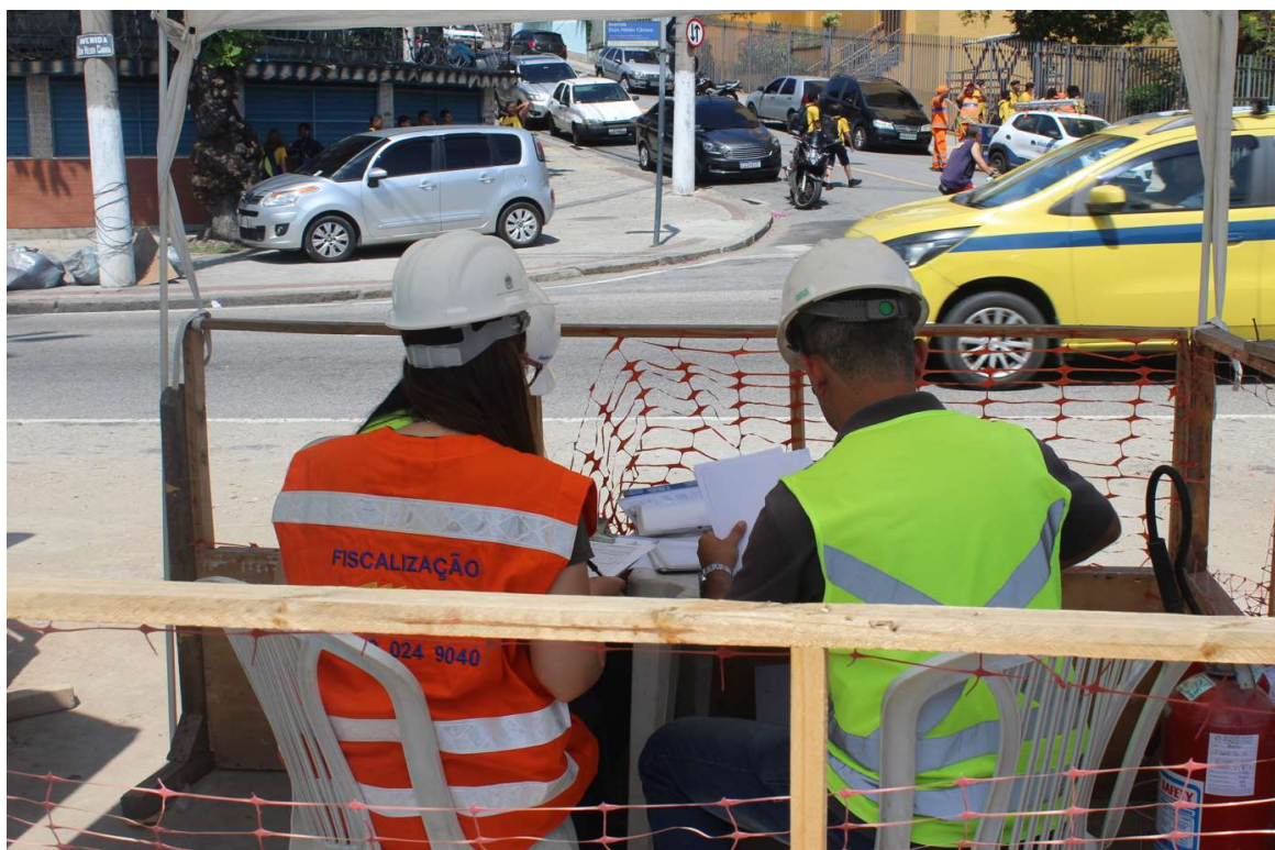
Foto 6 : vistoria in loco
