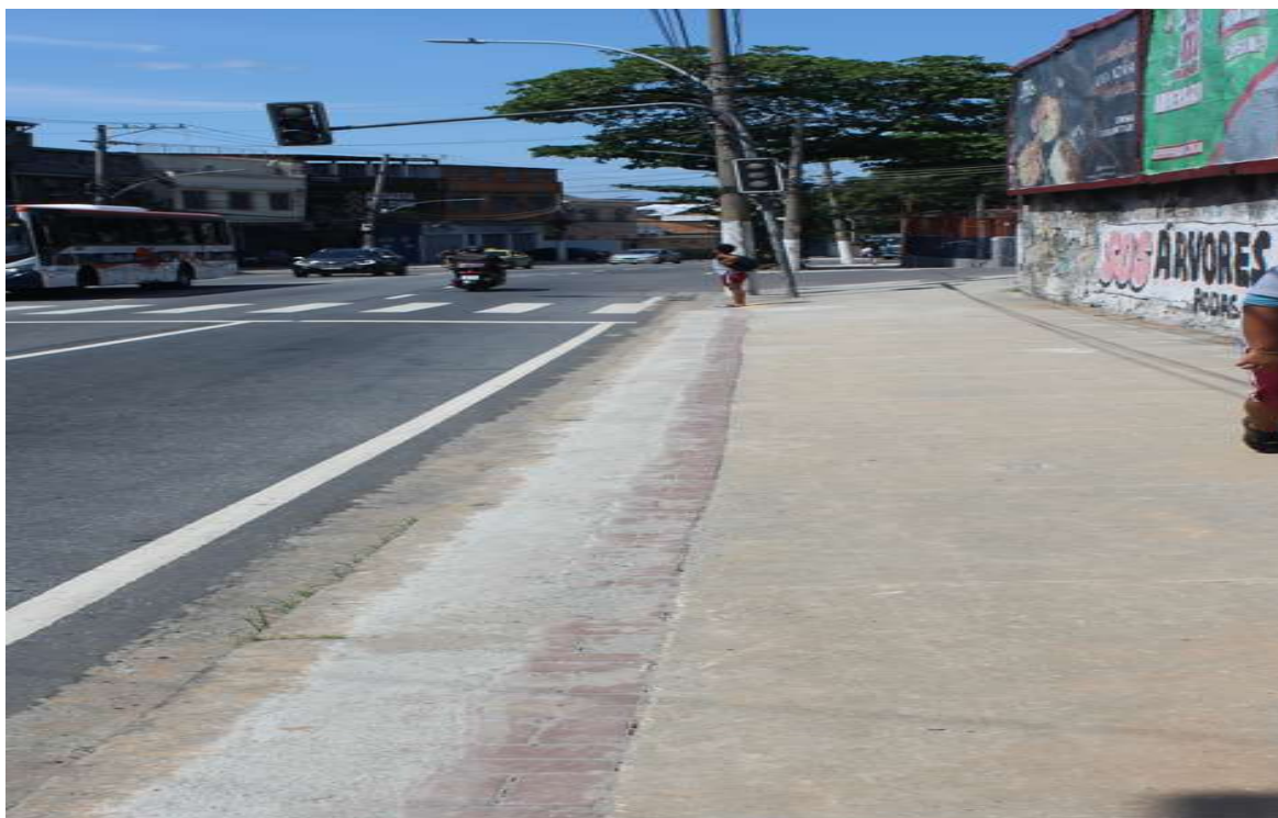
Foto 3 : recomposição de calçada na Av. Dom Hélder Câmara, esquina com Rua Pires de Carvalho
