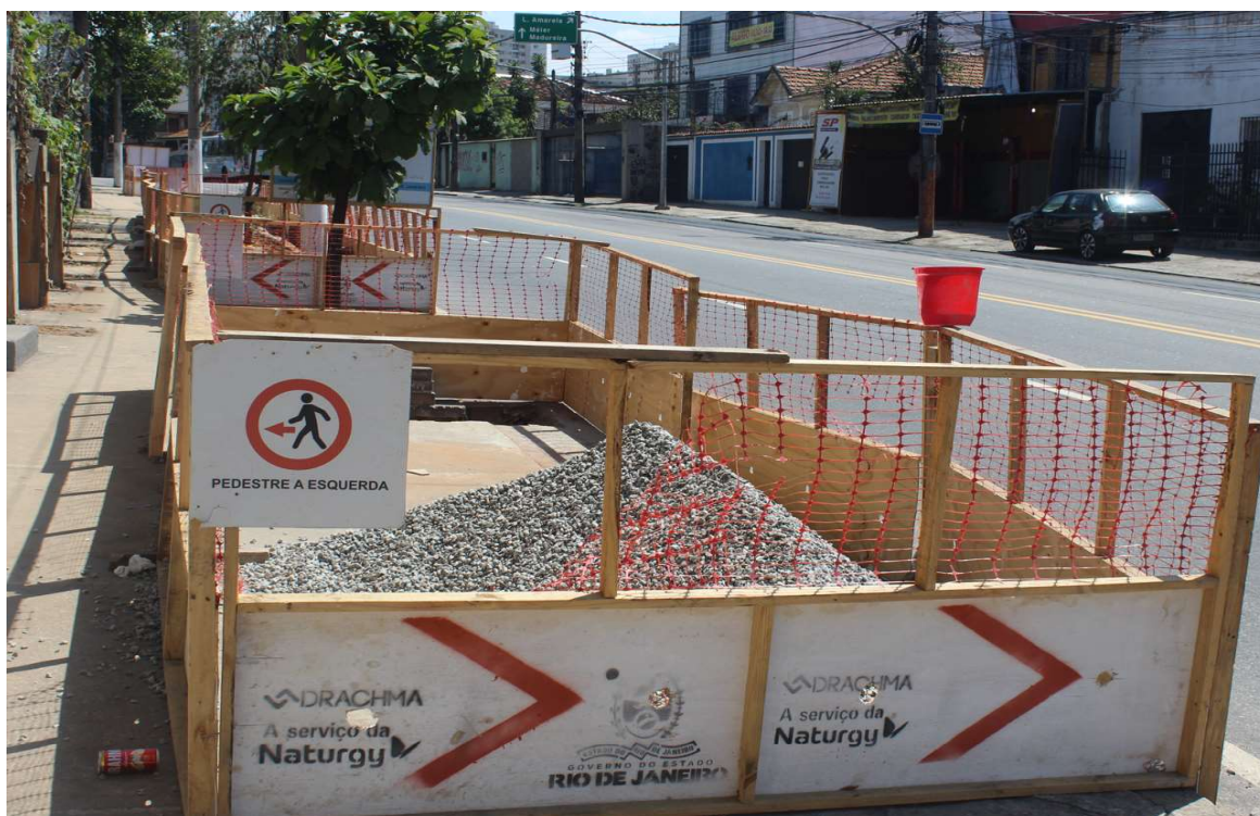
Foto 5 : armazenamento de material, isolamento por tapumes e sinalização
