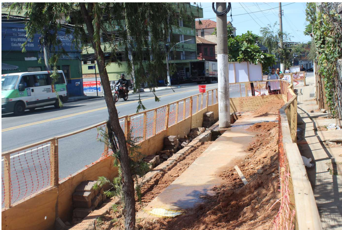
Foto 4 : obras em andamento
