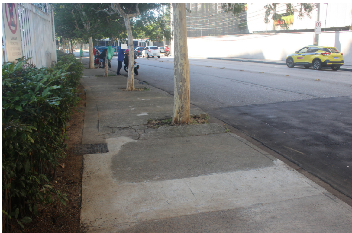
Foto 1: Ponto de interligação da rede
