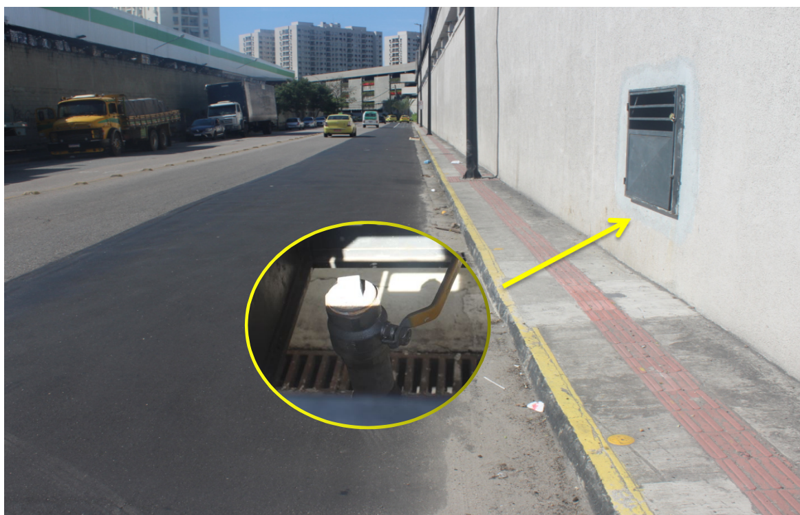
Foto 4: Instalação do ramal
