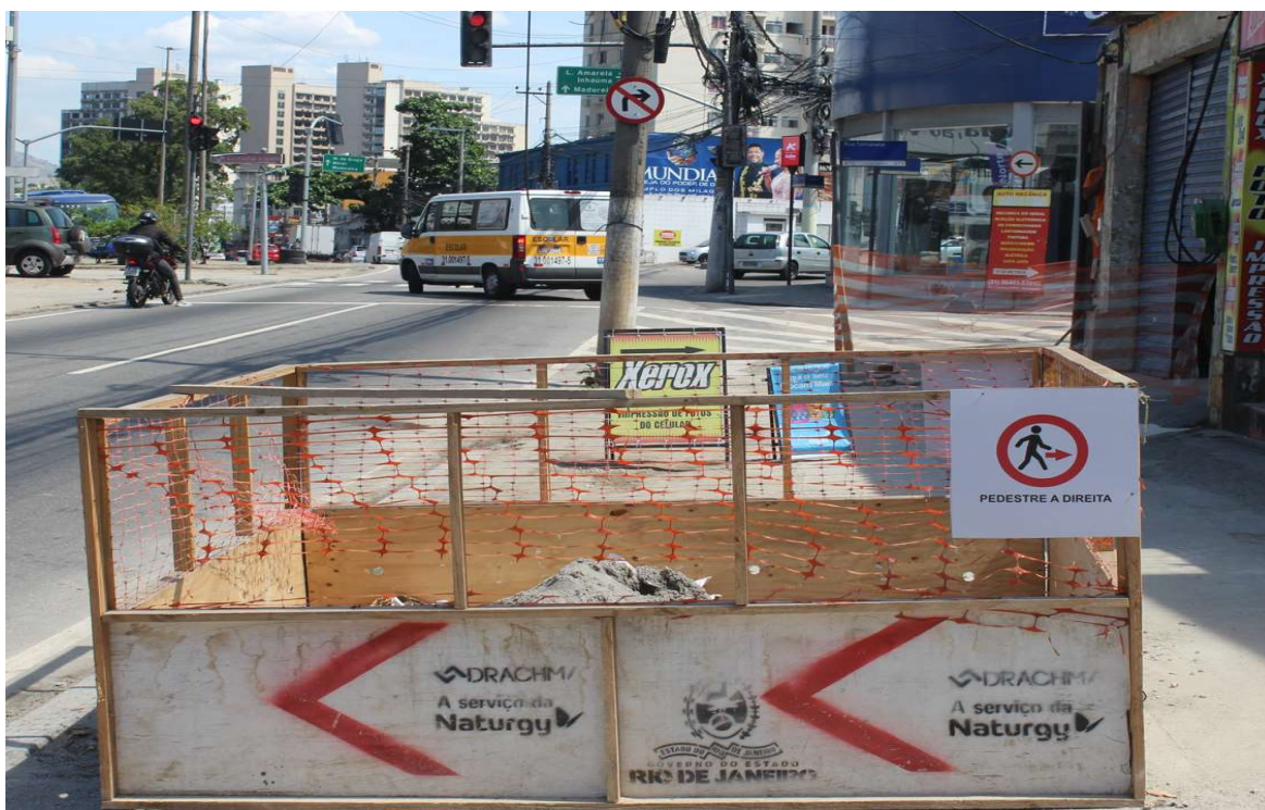
Foto 1 : isolamento por tapumes na esquina da Rua Tamarana
