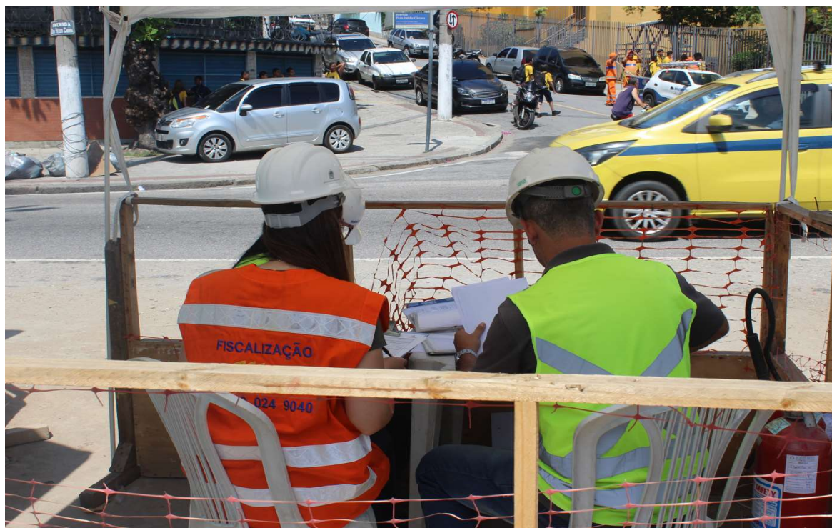
Foto 5 : vistoria in loco
