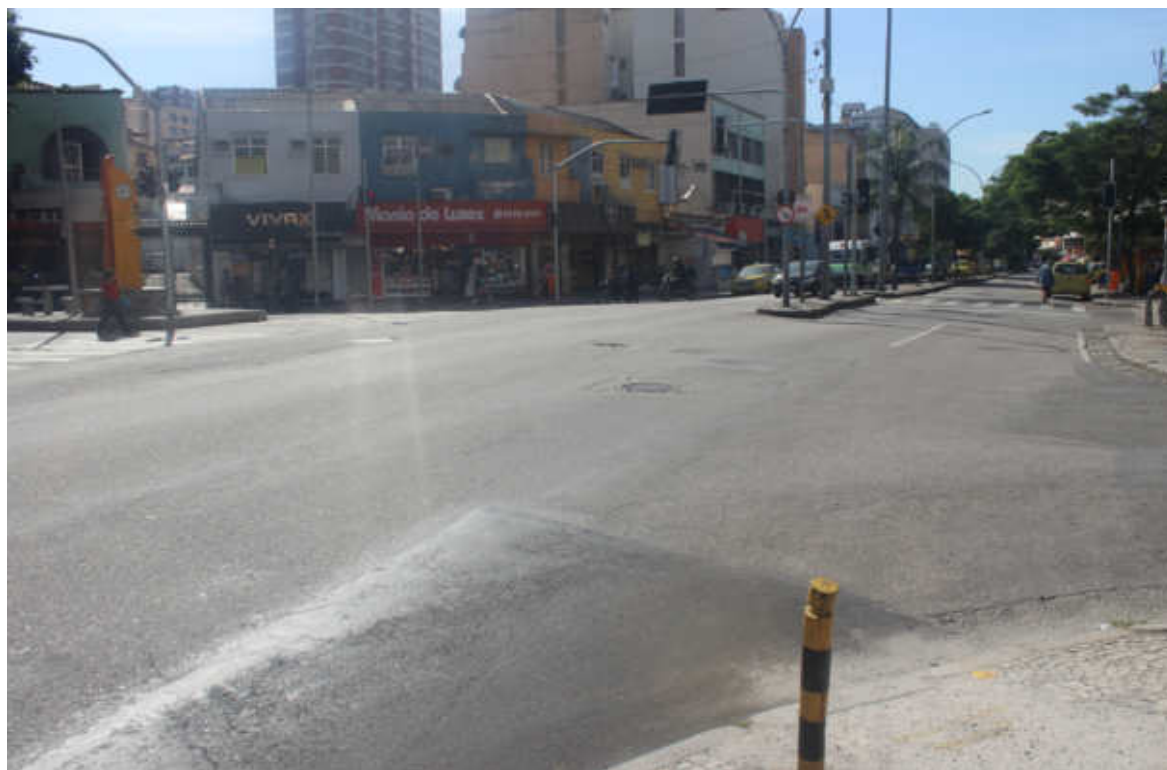
Foto 7: Recomposição no trecho finalizado lado ímpar
