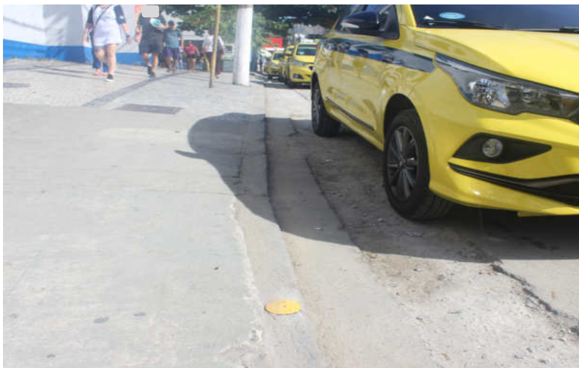
Foto 10: Recomposição provisória e marco plano do lado ímpar
