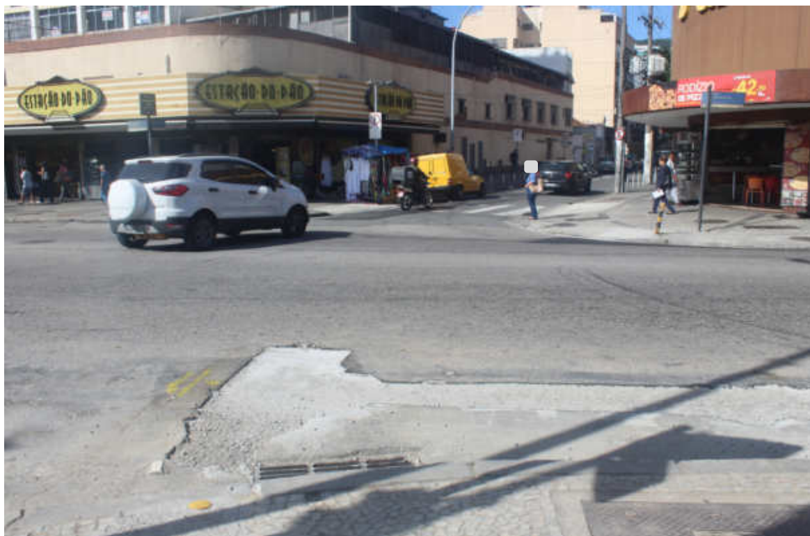
Foto 5: Recomposição provisória e marco plano do lado par a ser finalizado
