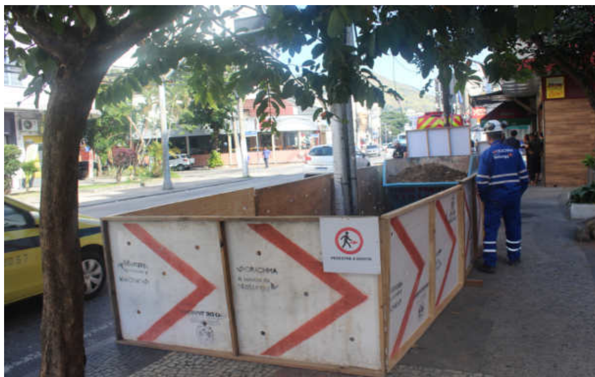
Foto 12: Sinalização e isolamento
