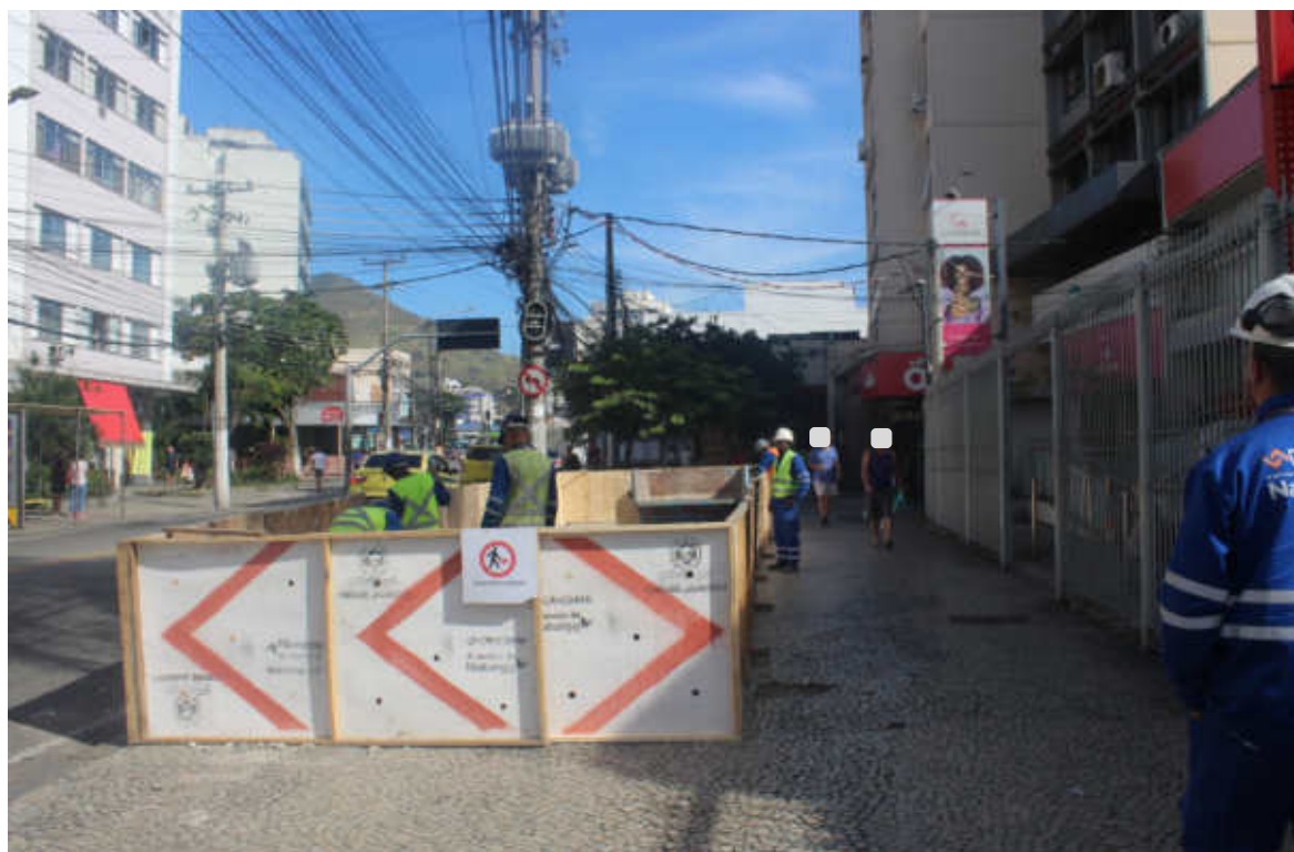
Foto 11: Sinalização e isolamento
