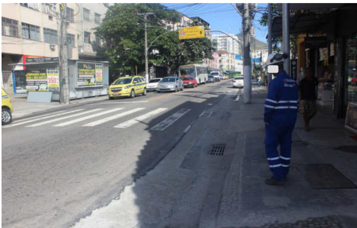
Foto 6: Recomposição provisória do lado par a ser finalizado
