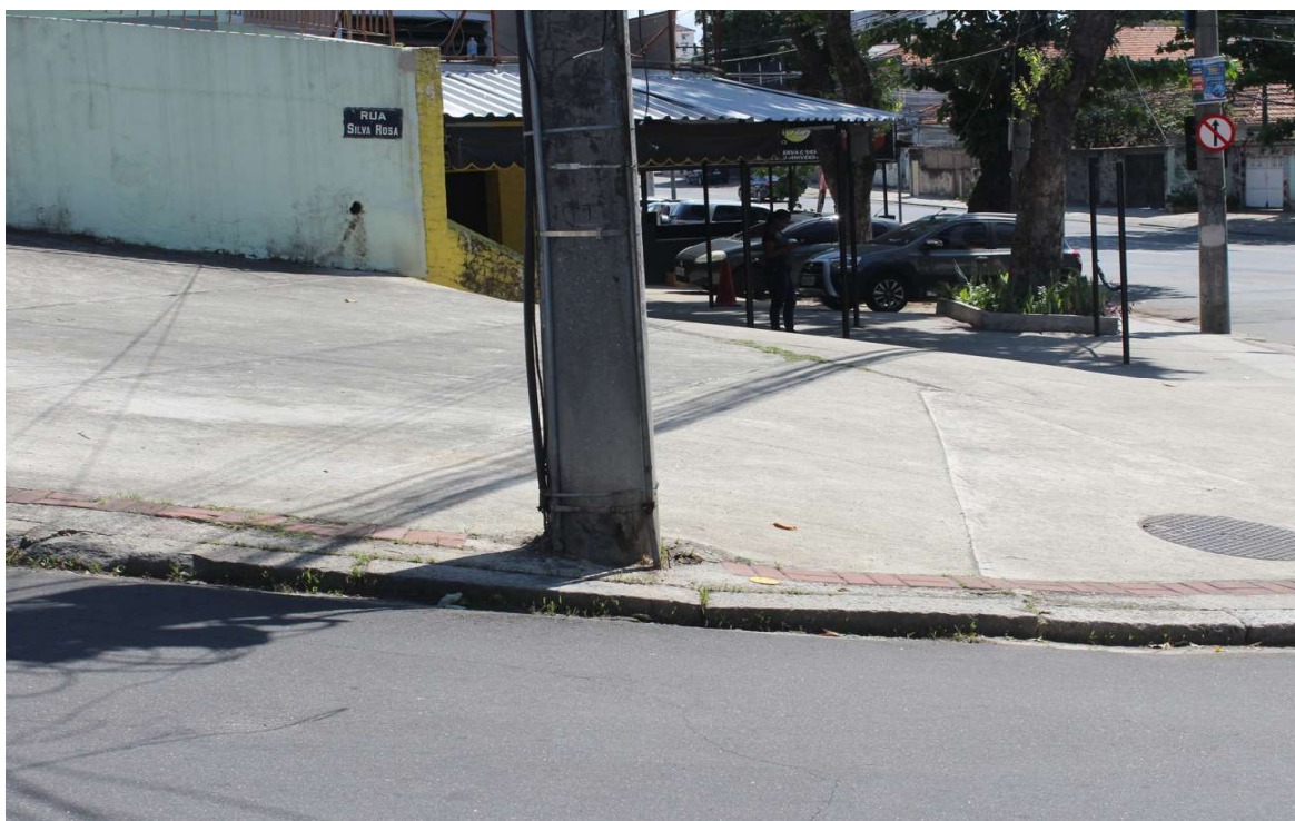
Foto 1 : ponto de interligação inicial da obra
