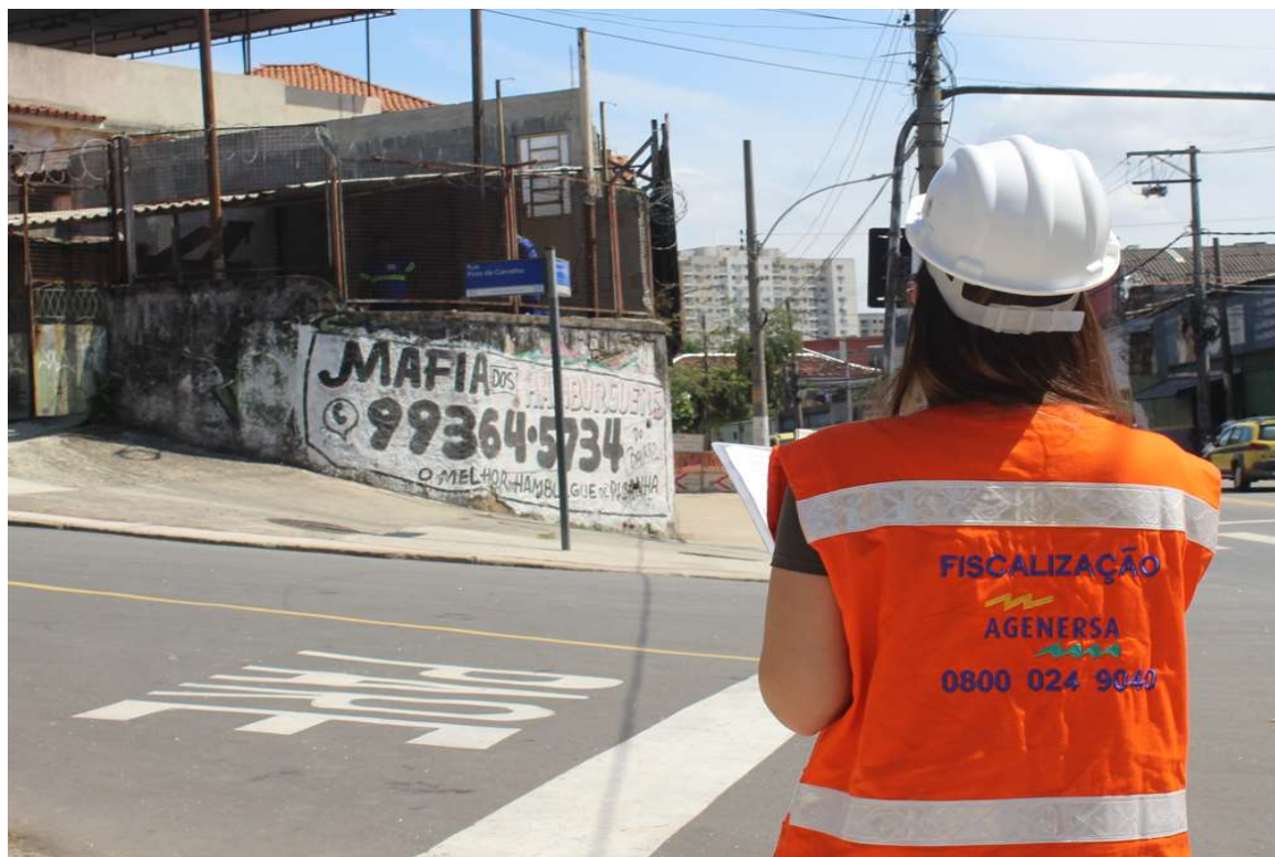
Foto 4 : ponto de interligação final da obra
