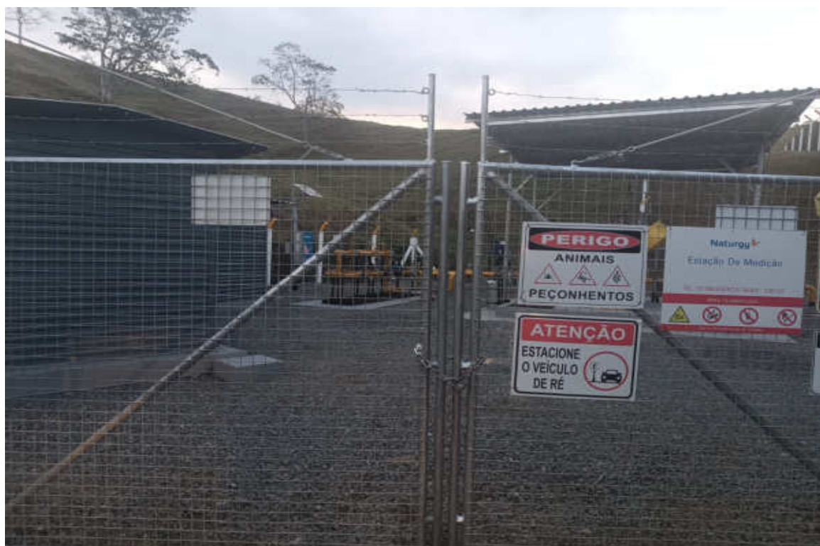
Foto 18: Foi corrigido o espaçamento entre as partes do portão
