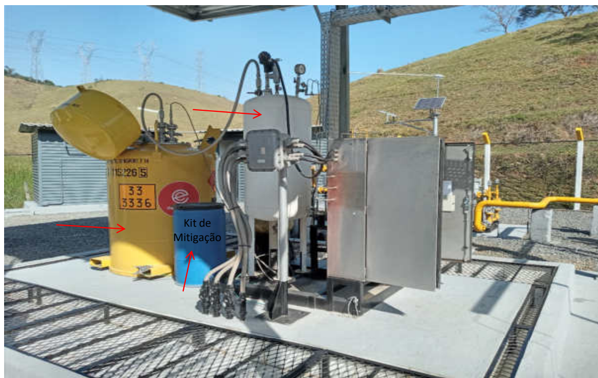
Foto 7: Recipientes para armazenamento do odorante e kit de mitigação
