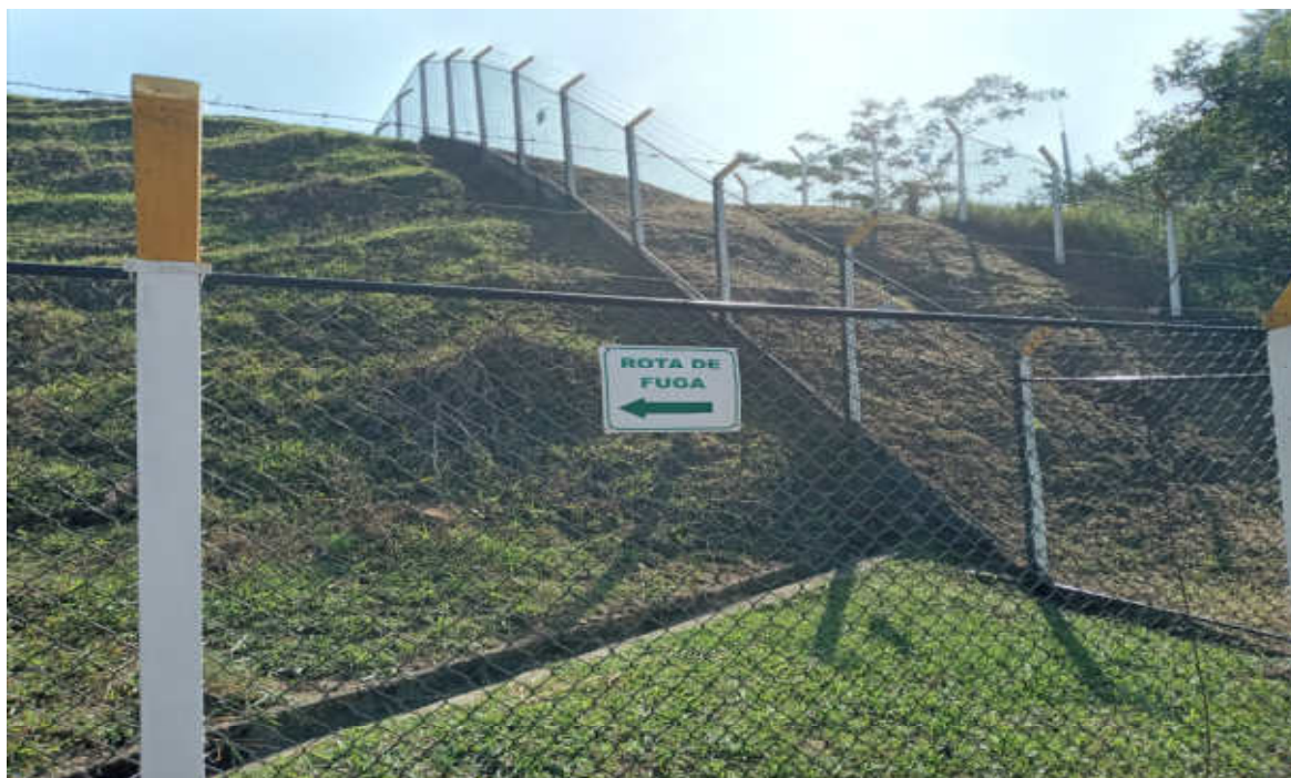
Foto 19: Cerca e placa de rota de fuga
