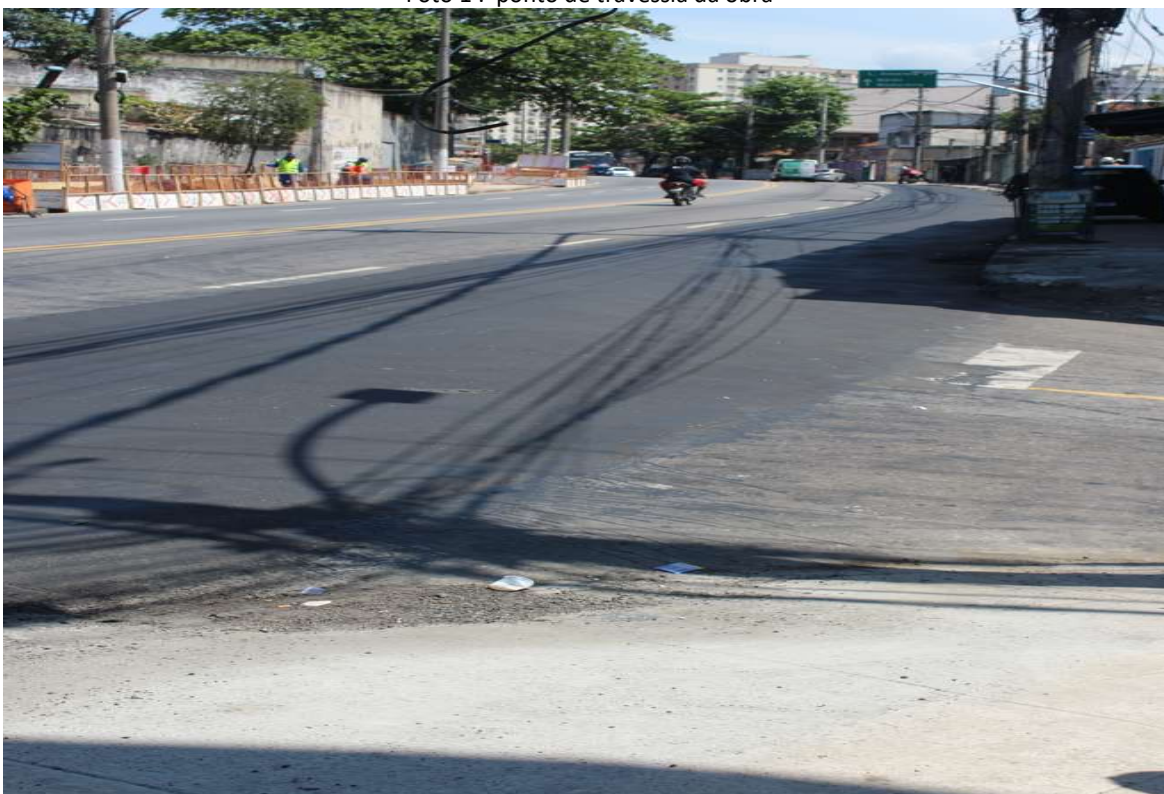
Foto 2 : interligação à rede existente
