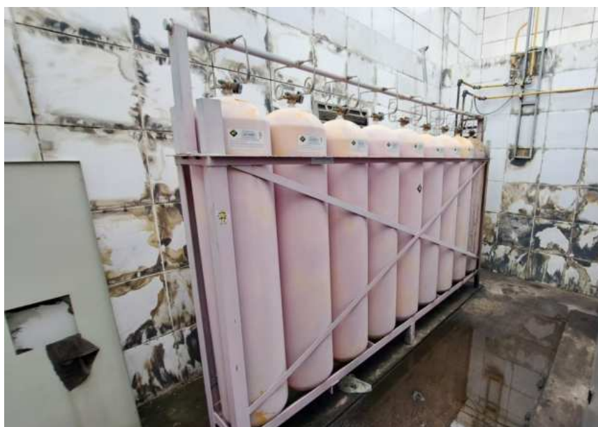
Posto Luar Foto 5: Cilindros pulmão de GNV
