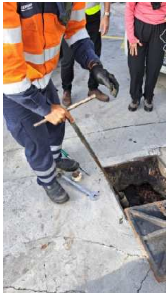
Posto El Ninho Foto 5: Interrupção de fornecimento GNV: Fechamento Válvula da Rede na calçada e lacre da Área de Regulagem e Medição de GNV
