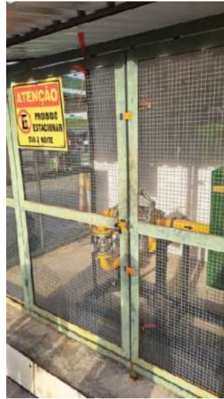
Posto El Ninho Foto 5: Interrupção de fornecimento GNV: Fechamento Válvula da Rede na calçada e lacre da Área de Regulagem e Medição de GNV
