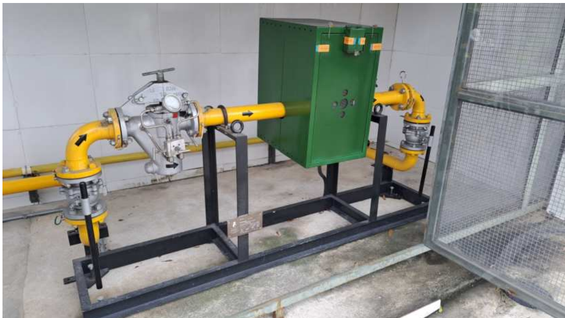
Posto El Ninho Foto 2: Central de Medição e Regulagem entrada de GNV
