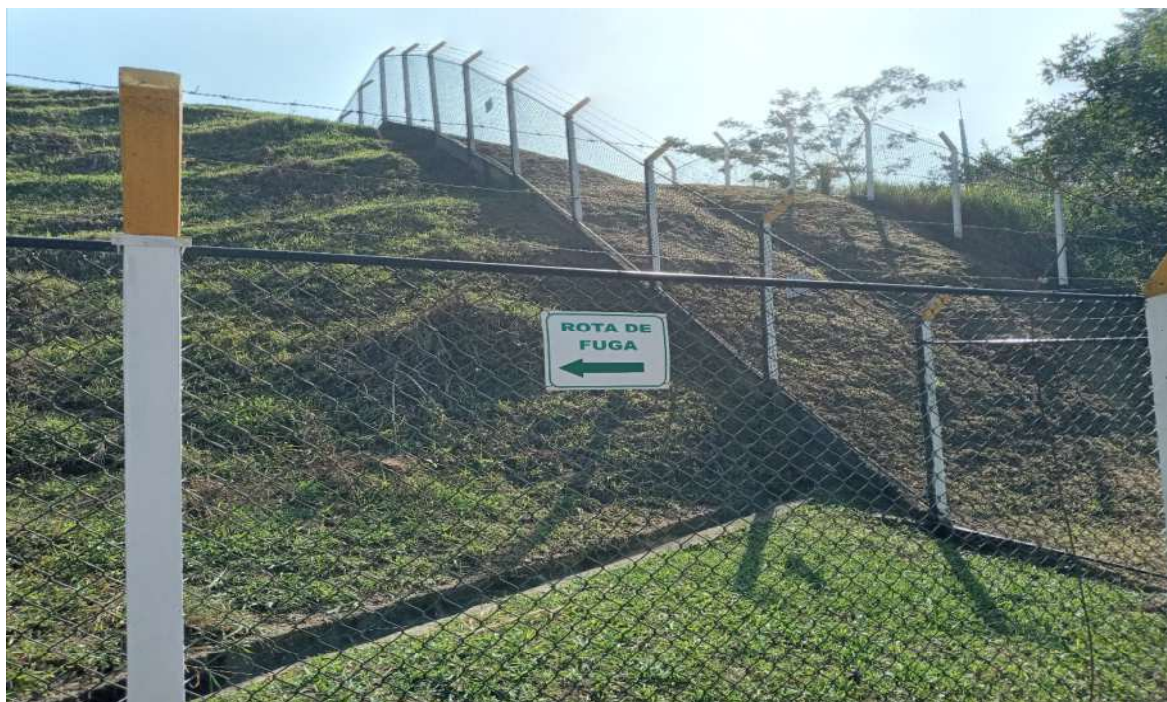
Foto 19: Cerca e placa de rota de fuga
