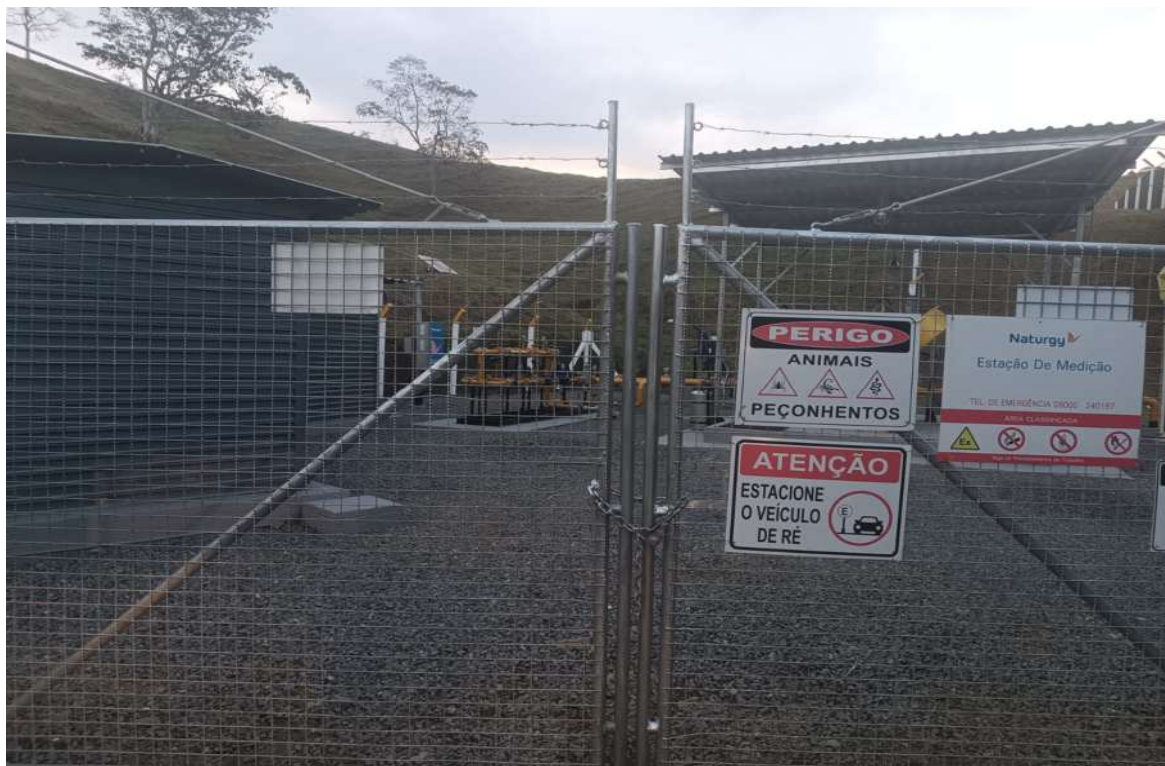
Foto 18: Foi corrigida a abertura existente entre as partes do portão
