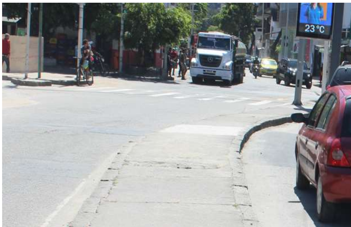
Foto 2 : recomposição da interligação à rede existente
