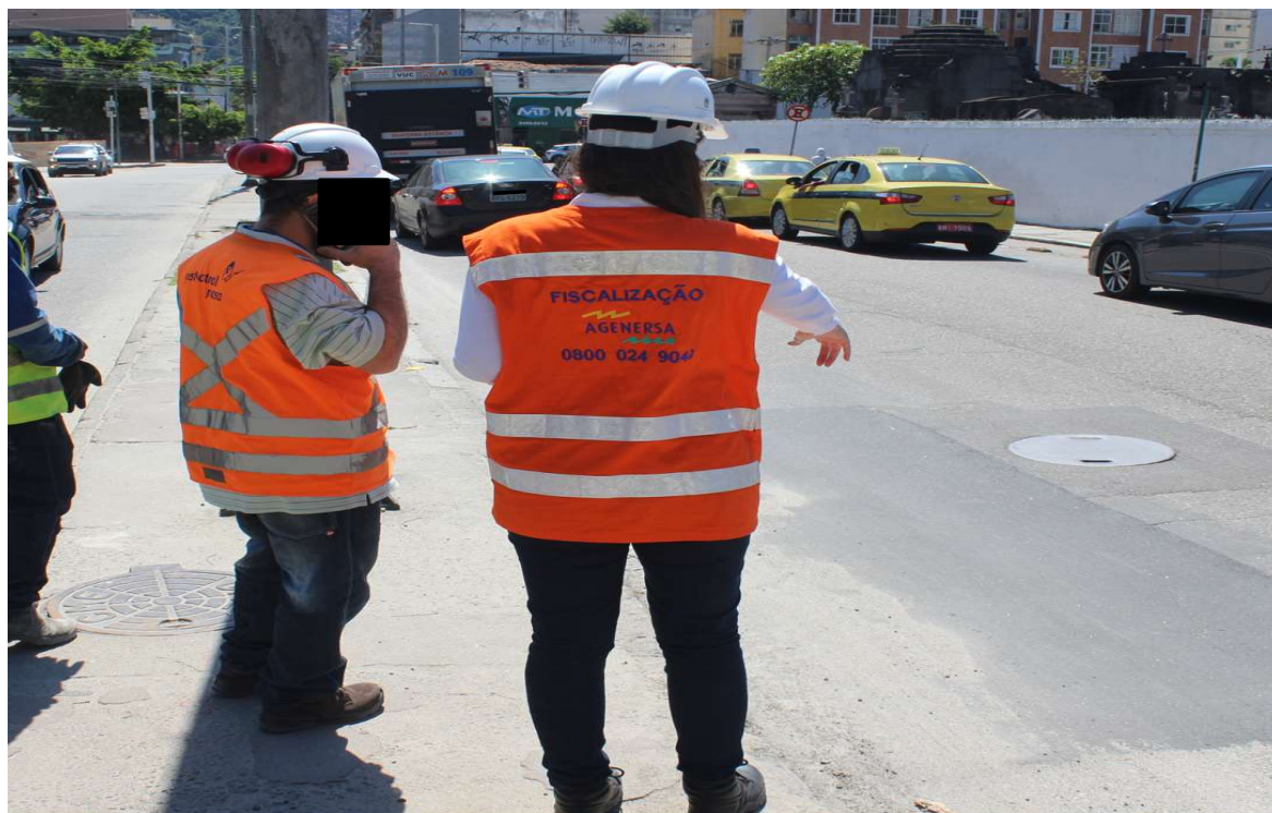
Foto 5 : vistoria in loco
