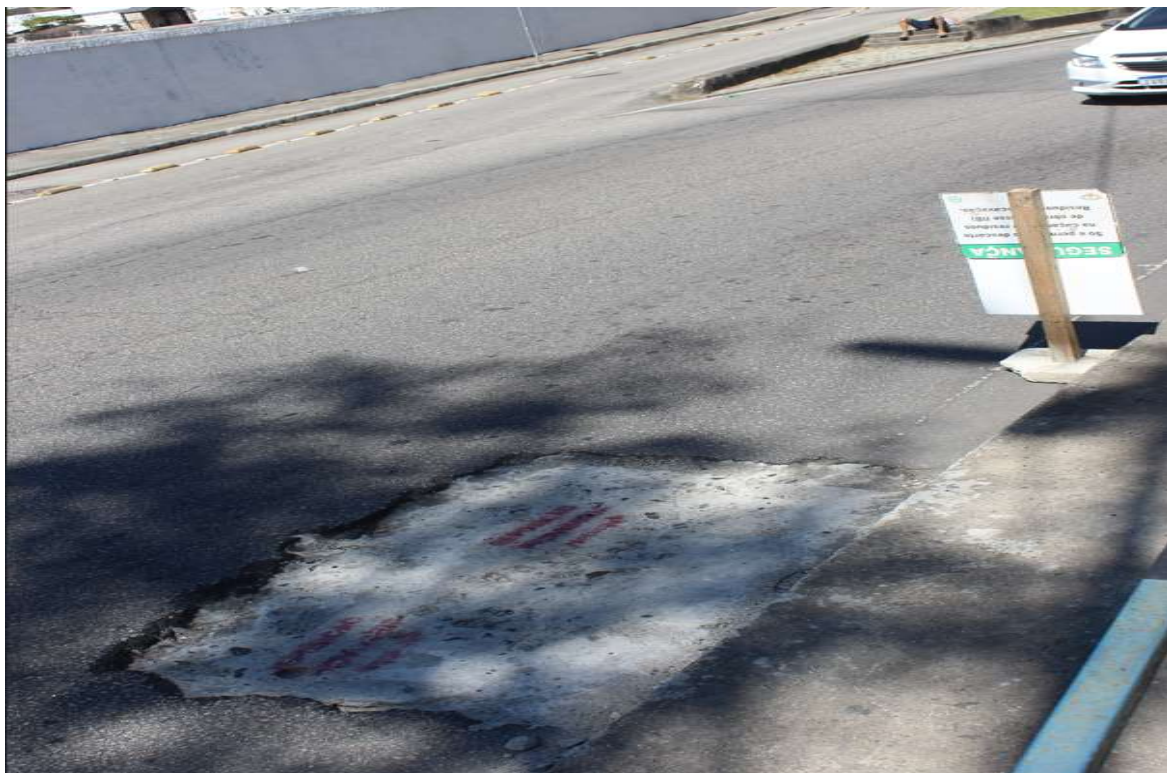
Foto 6 : recomposição provisória e aviso de obra à frente
