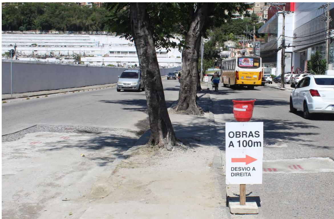
Foto 4 : sinalização de existência de obra à frente e recomposição provisória
