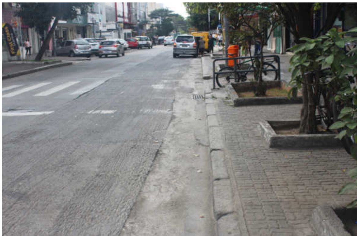
Foto 5: Fresagem e recomposição provisória
