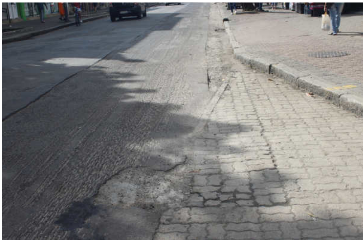
Foto 1: Ponto de início da obra
