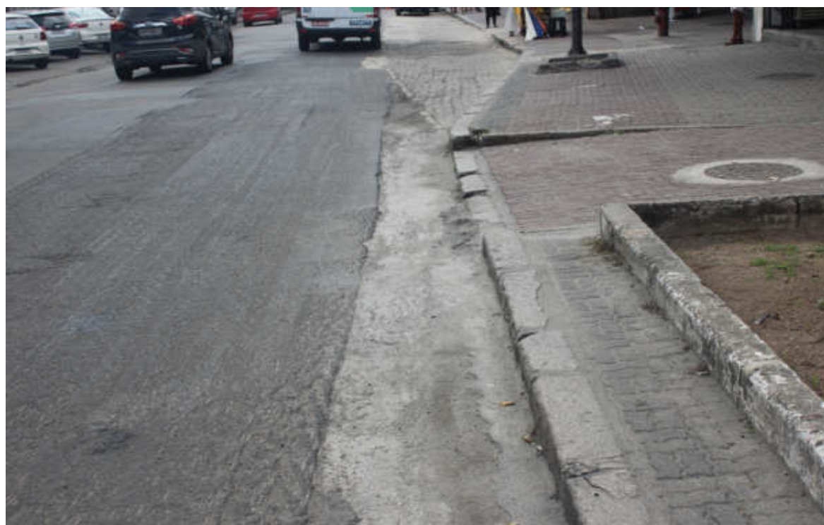
Foto 2: Fresagem e recomposição provisória
