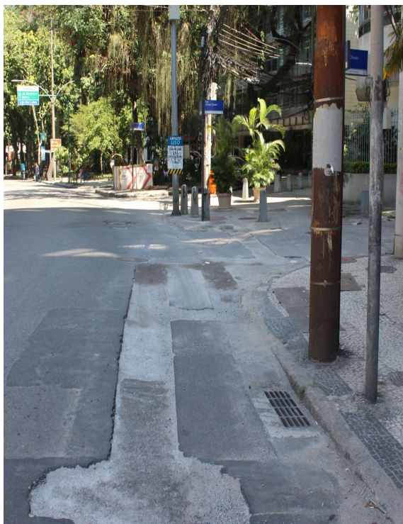
Foto 5 : irregularidade na recomposição do asfalto antes e depois
