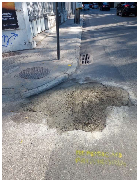
Foto 3 : irregularidade na recomposição do asfalto antes e depois
