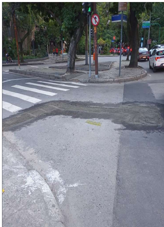
Foto 4 : irregularidade na recomposição do asfalto antes e depois
