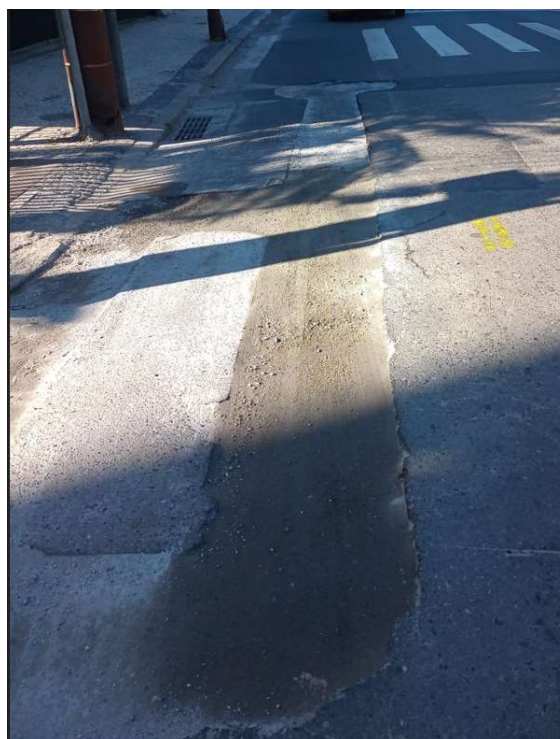
Foto 5 : irregularidade na recomposição do asfalto antes e depois
