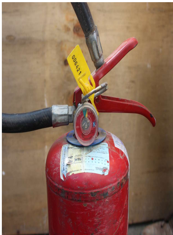
Foto 6 : carga de pressão fora da especificação e novo extintor
