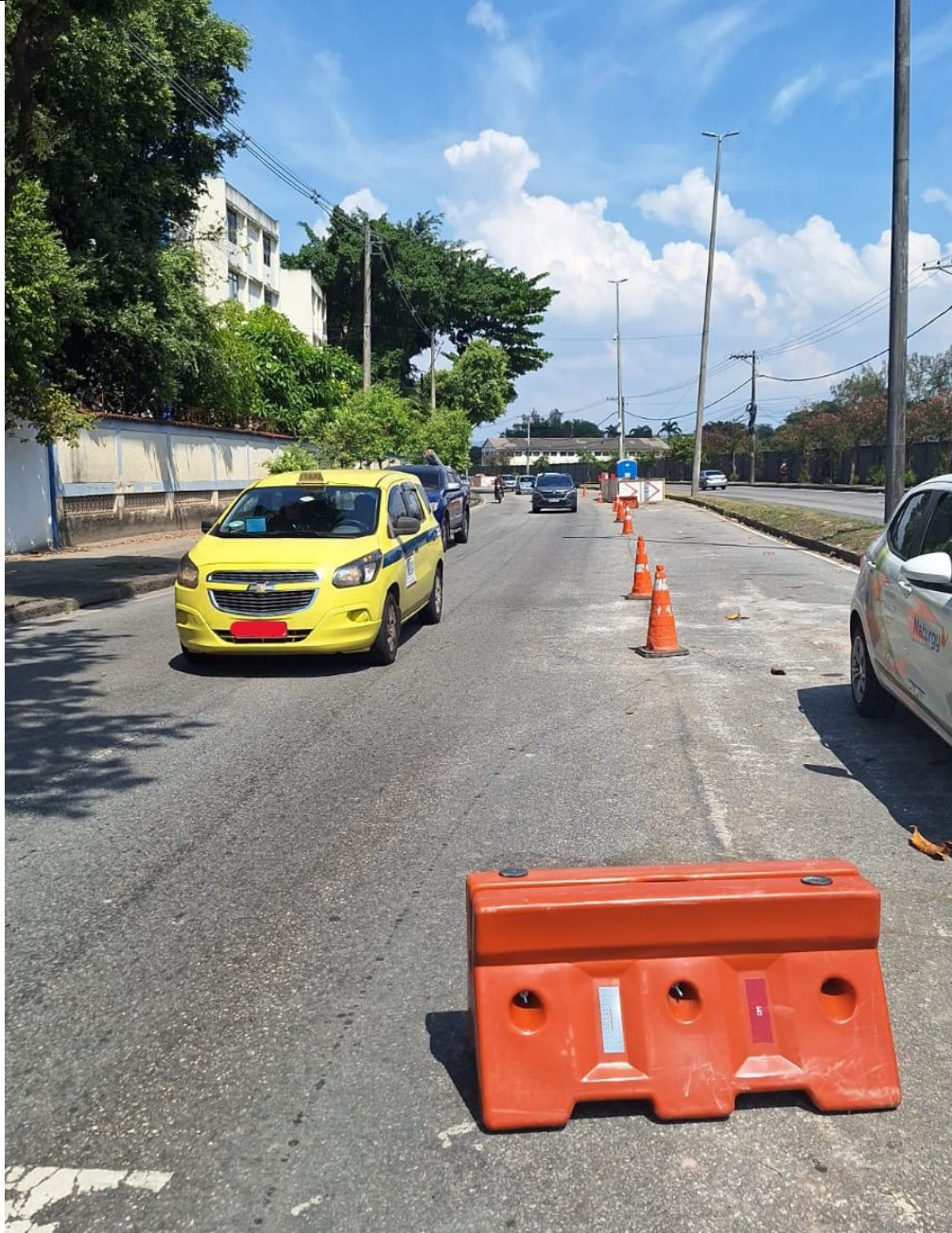
Foto 1: Obra desviada para o centro da via (foto enviada posteriormente pela Concessionária). No momento, não há mais cones, isolamento ou obra sendo realizada no local.
