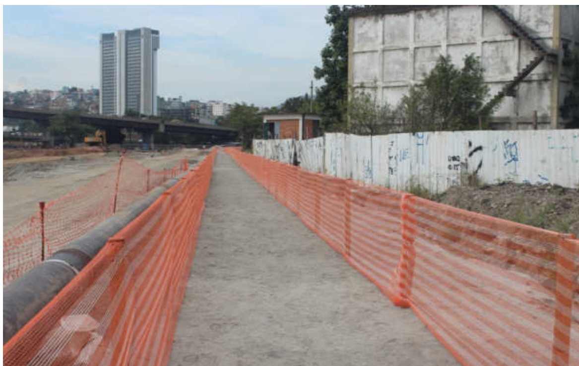
Foto 6: Isolamento em trecho de rede assentada
