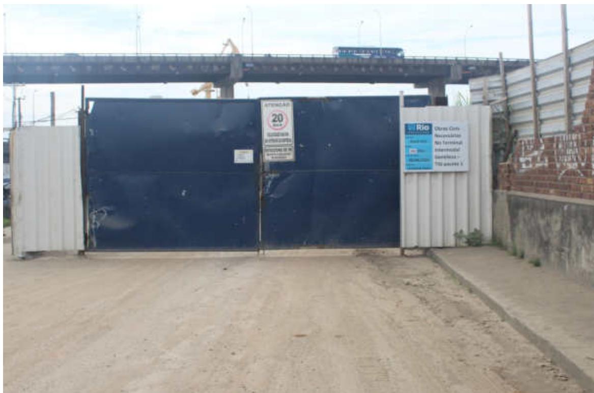
Foto 1: Entrada do canteiro de obras
