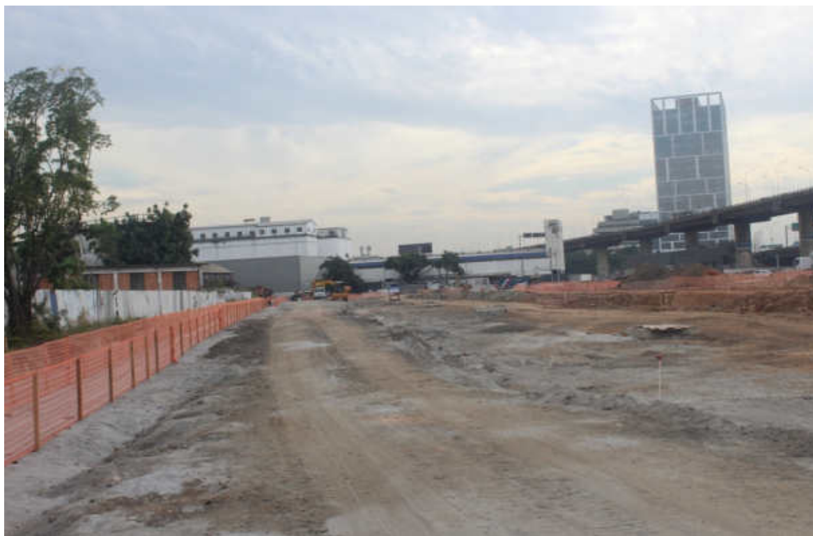
Foto 9: Canteiro de obras
