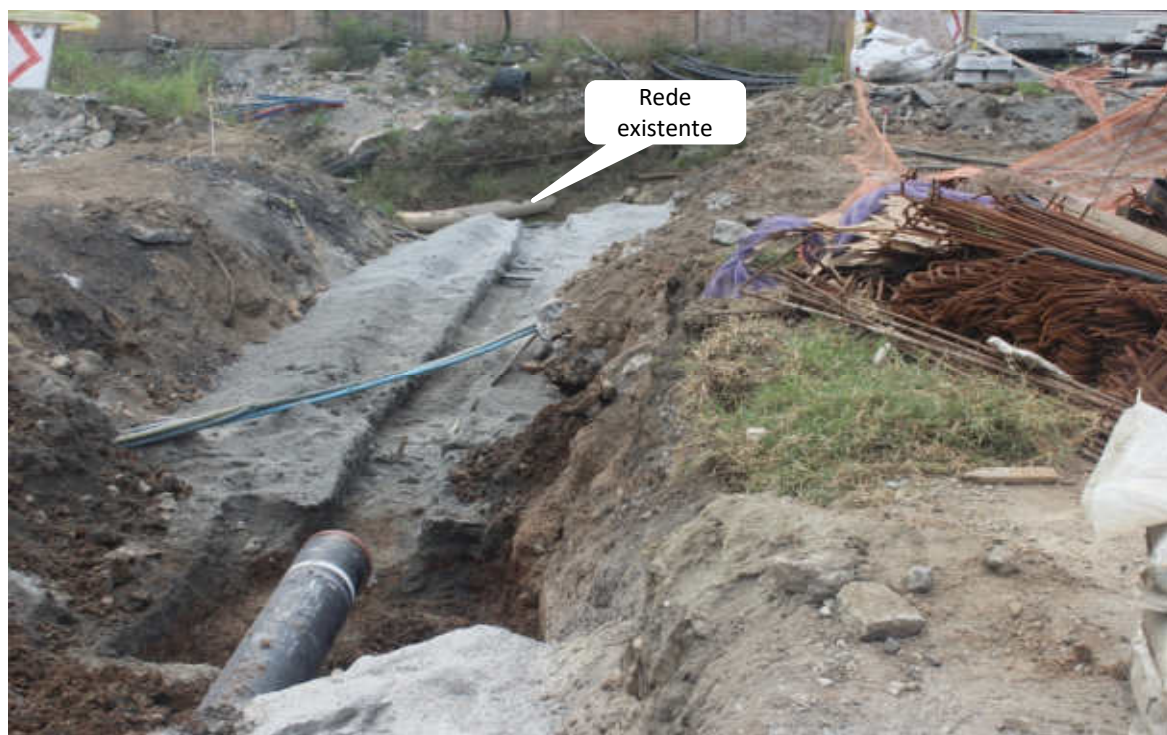
Foto 2: Tubulação de aço 14" a ser interligada
