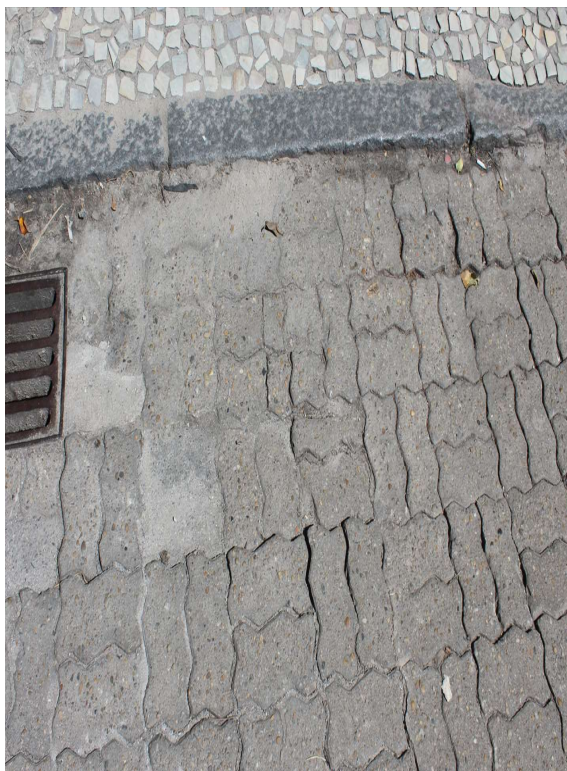
Foto 4 : irregularidade na recomposição da via antes e depois
