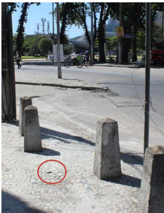
Foto 3 : irregularidade na recomposição da calçada antes e depois
