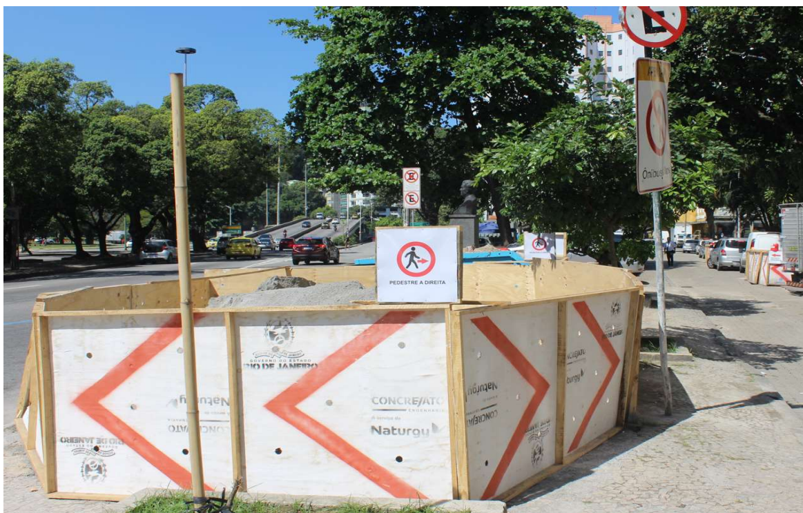
Foto 5 : sinalização de obra
