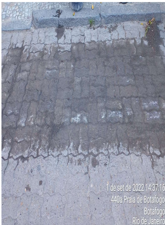
Foto 4 : irregularidade na recomposição da via antes e depois
