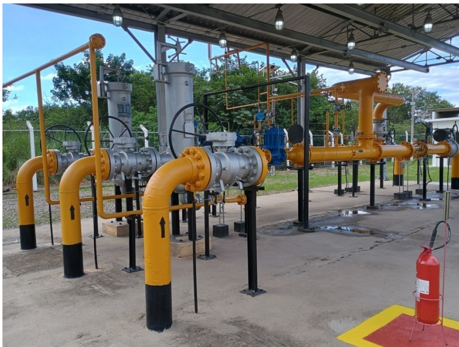
Foto 5: linha de redundância com filtro, regulagem e medição paralela a linha ativa.
