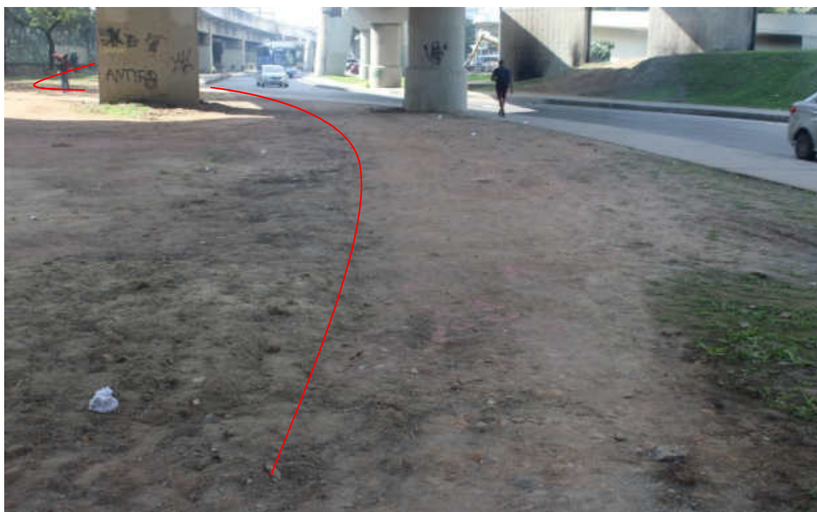
Foto 8: Inserção de rede em área de terra fora do passeio
