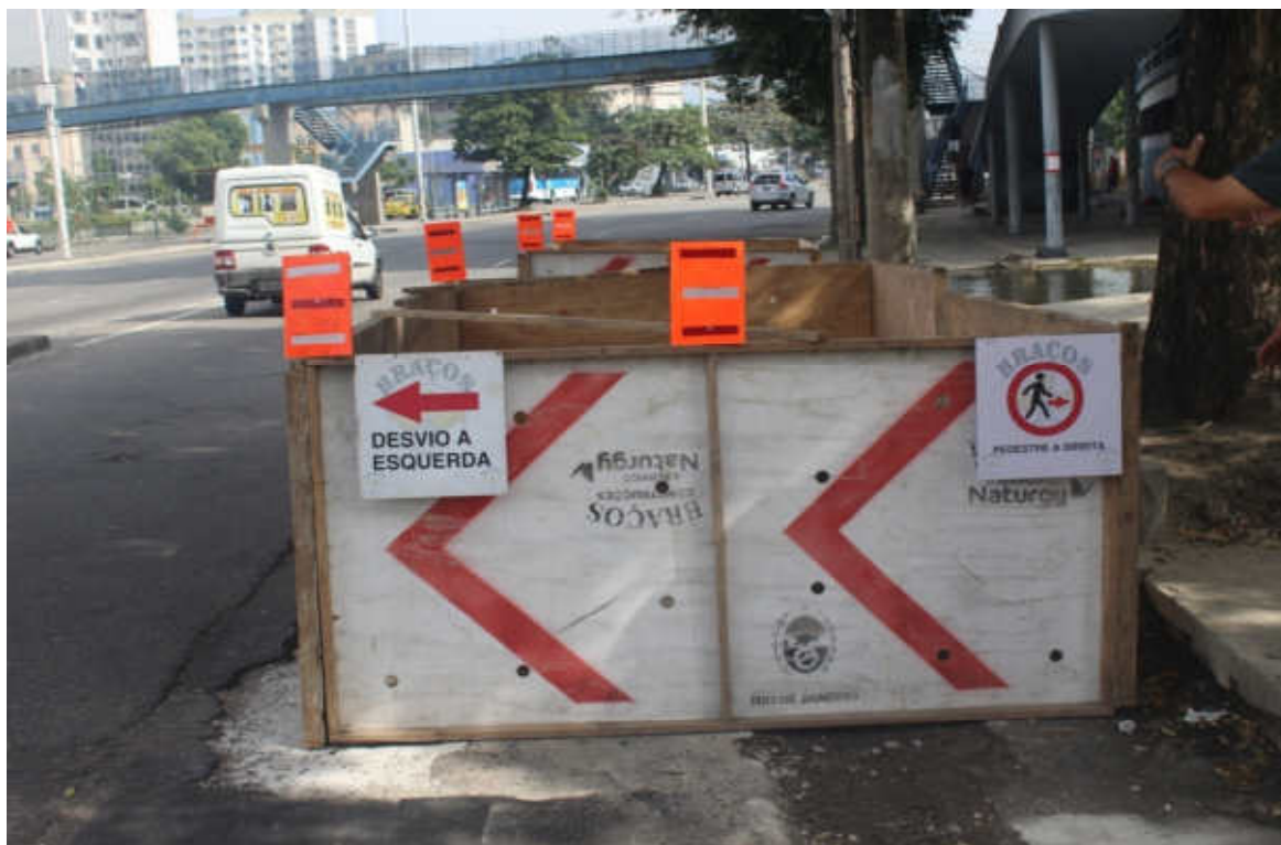
Foto 3: Isolamento, sinalização e recomposição provisória
