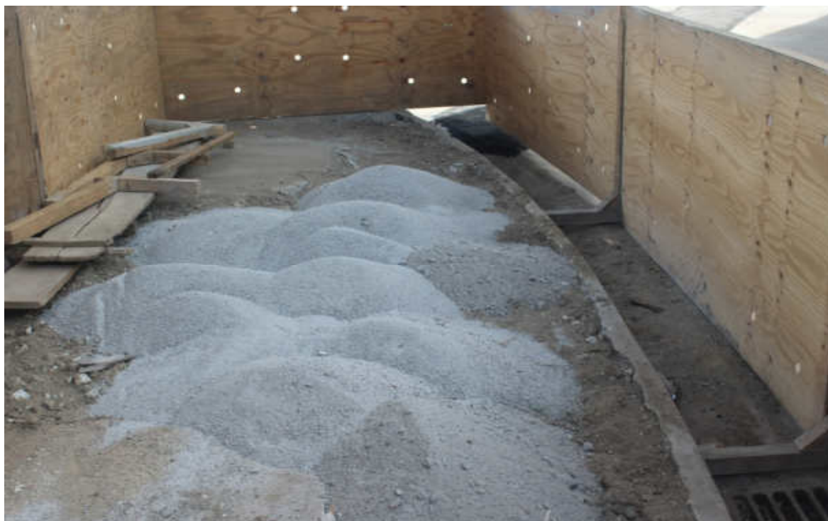
Foto 10: Isolamento e armazenamento de material para recomposição
