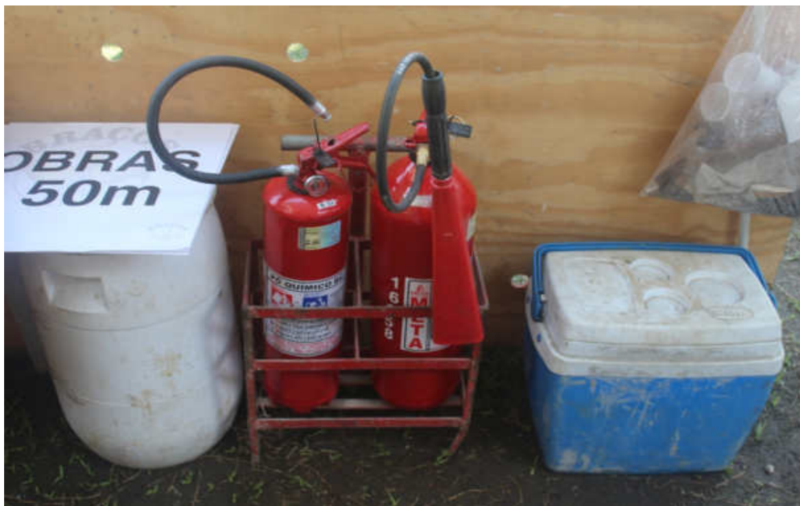
Foto 12: Extintores de PQS e CO2
