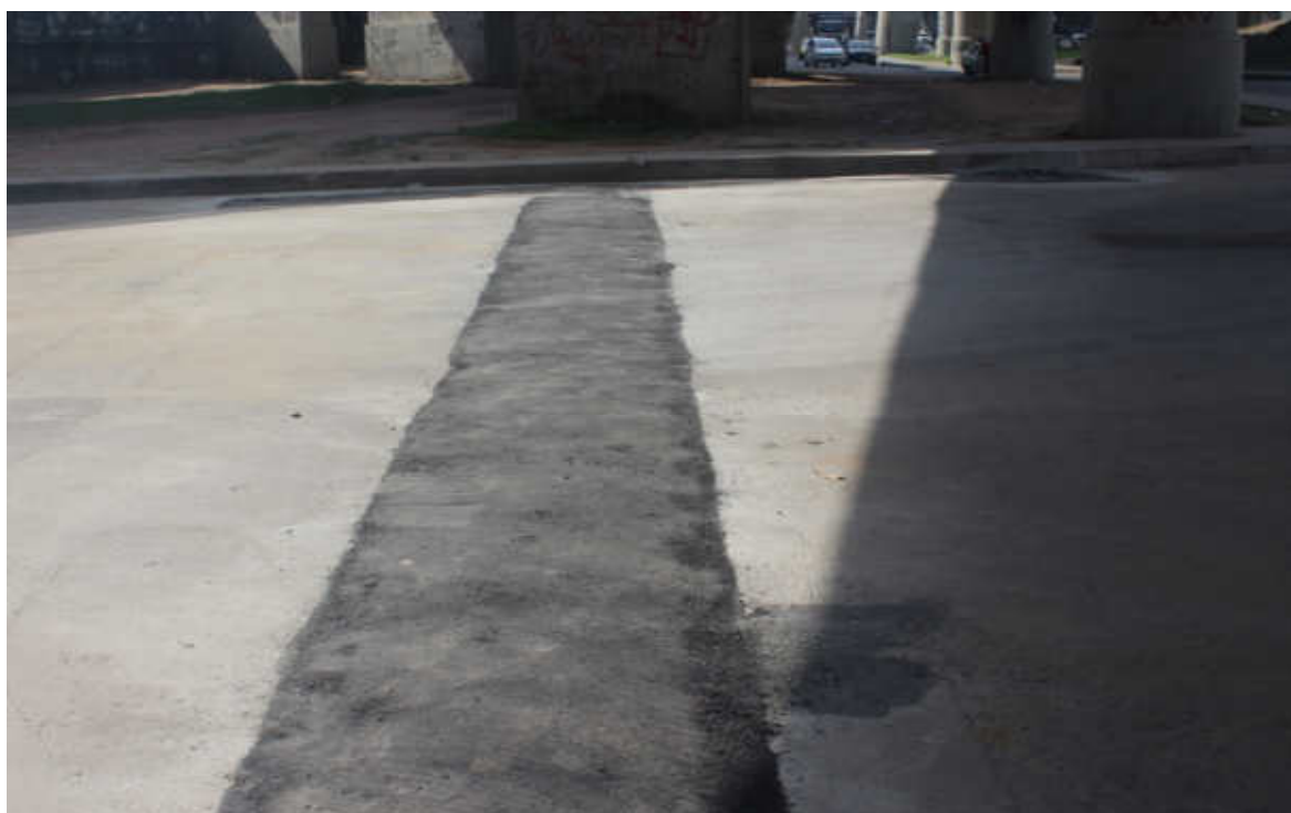
Foto 6: Recomposição da via em travessia de rede
