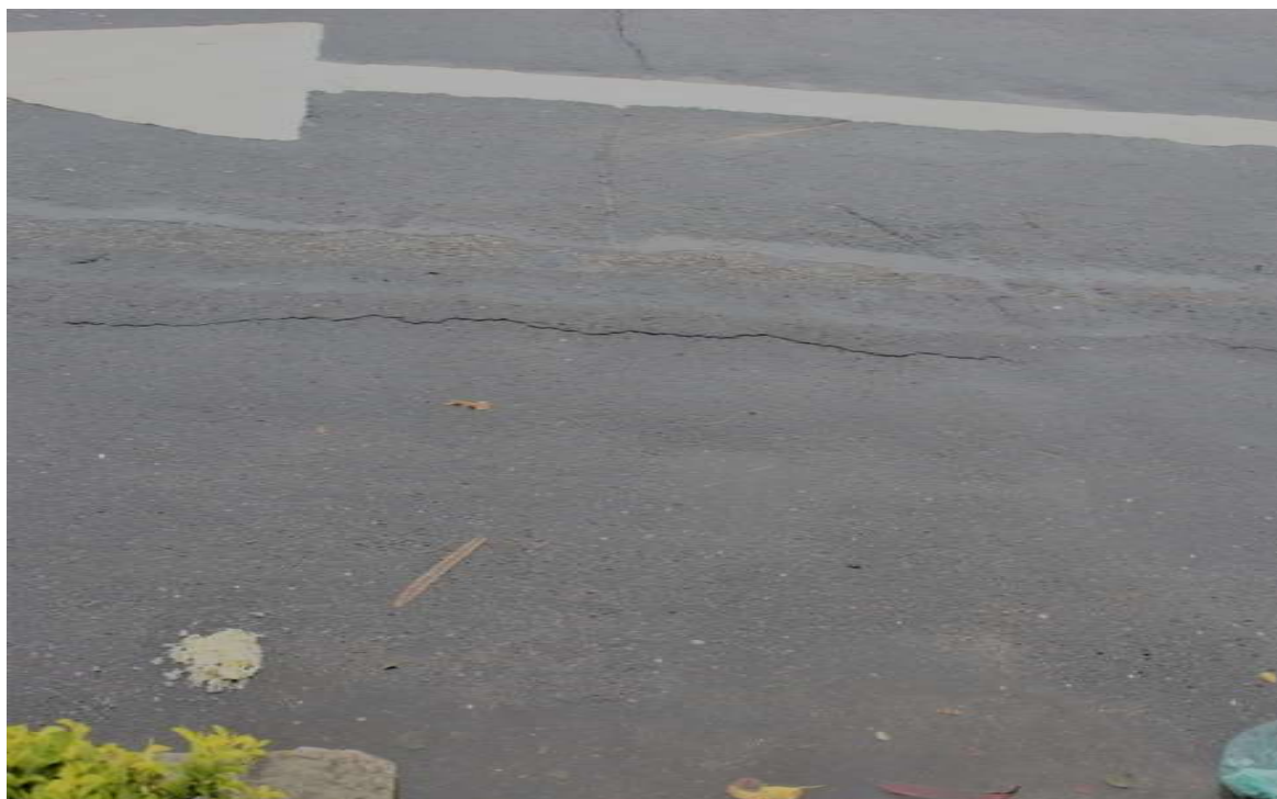
Foto 1 : Irregularidade na recomposição (Fissuras no asfalto) da Avenida Pasteur, n.º 168.
