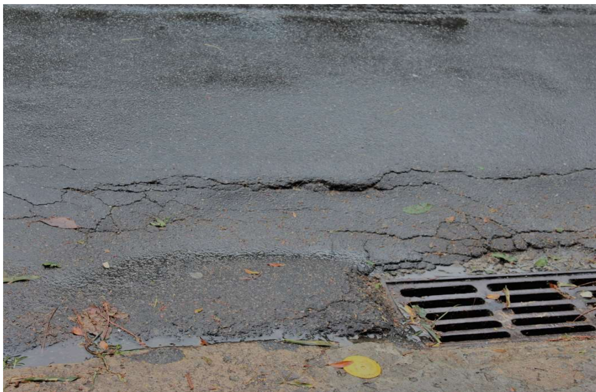
Foto 1 : Irregularidade na recomposição (Fissuras no asfalto) da Avenida Pasteur, n.º 168.
