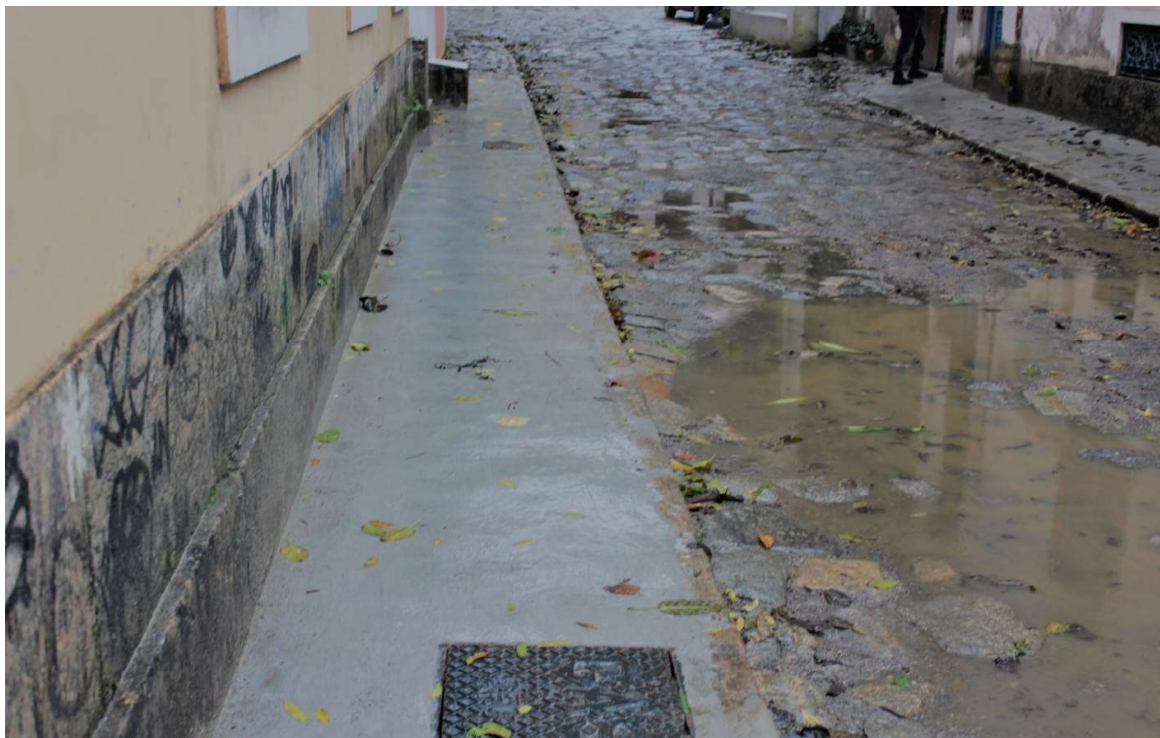
Foto 3 : Restauração da calçada.
