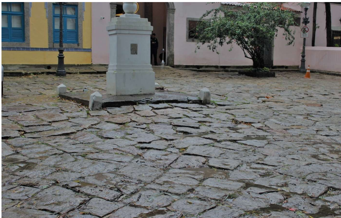
Foto 1 : Largo do Boticário após obra de expansão da rede.
