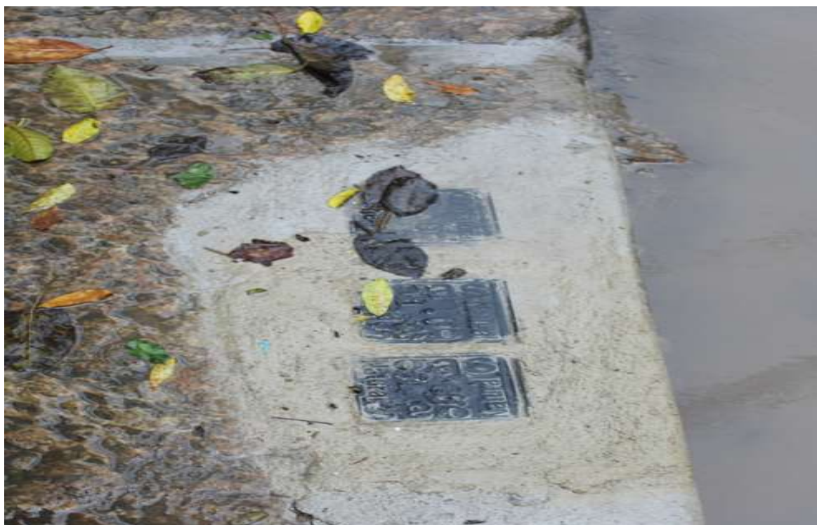
Foto 4 : Caixas de válvulas de segurança.
