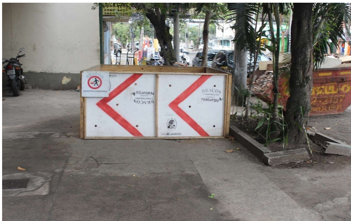
Foto 1 : Área tapumada para realizar a interligação do ramal com a rede para conclusão da obra.
