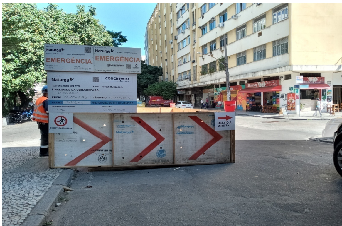
Foto 1: Identificação da obra, sinalização e isolamento
