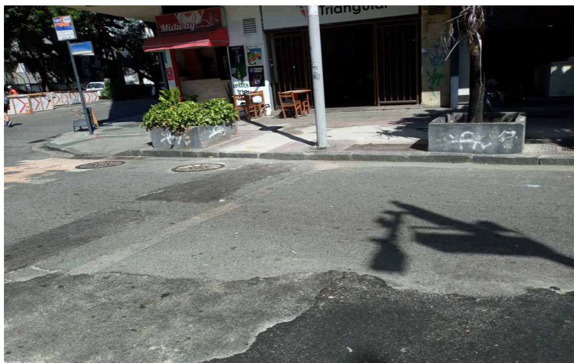
Foto 10: Recomposição provisória da via
