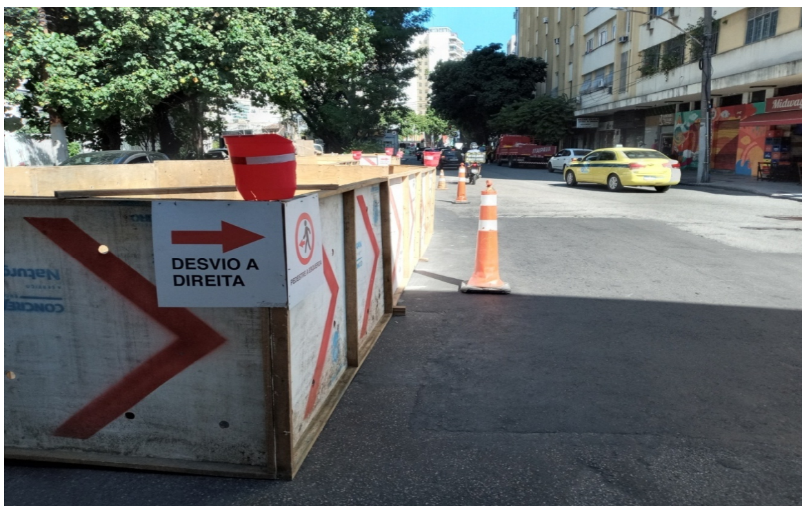
Foto 6: Isolamento e sinalização
