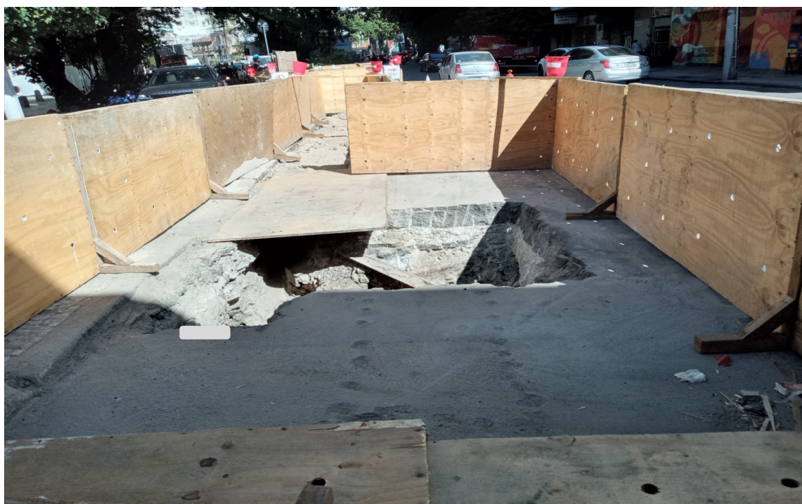
Foto 2: Trecho a ser concluído
