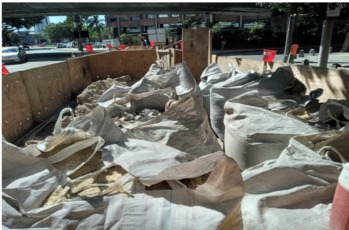
Foto 11: Armazenamento de material
