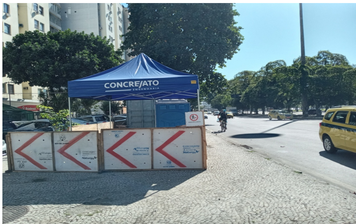
Foto 4: Área de vivência, isolamento e sinalização
