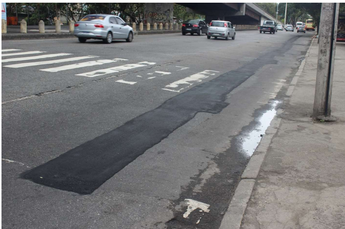
Foto 1 : Recomposição provisória na Avenida Francisco Bicalho.
