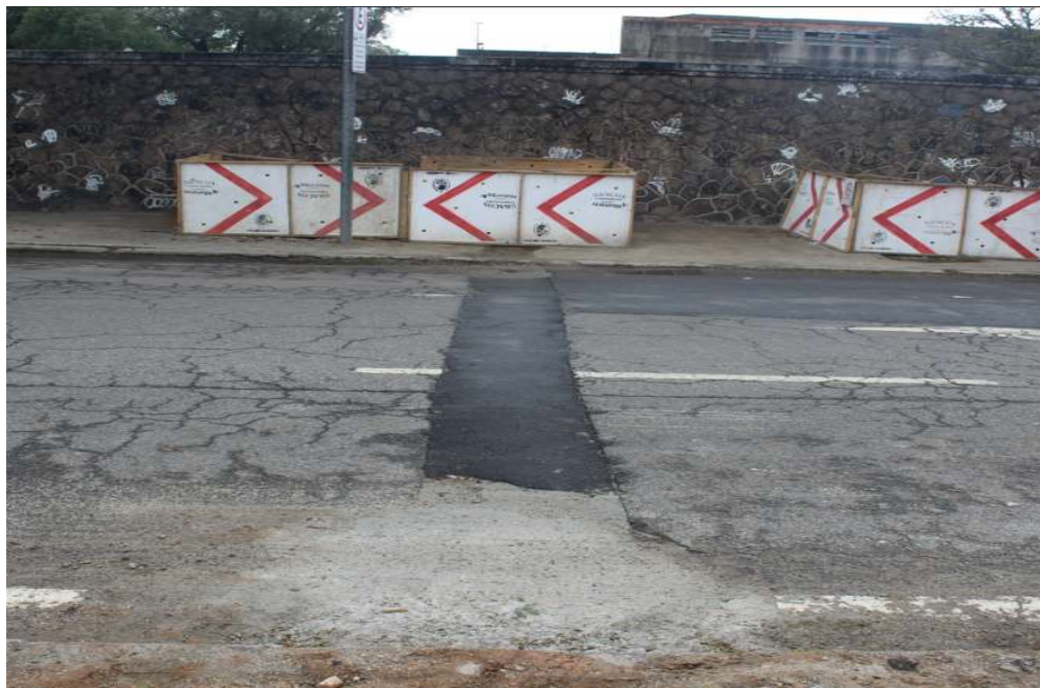
Foto 4 : Recomposição provisória da travessia na Avenida Pedro II.
