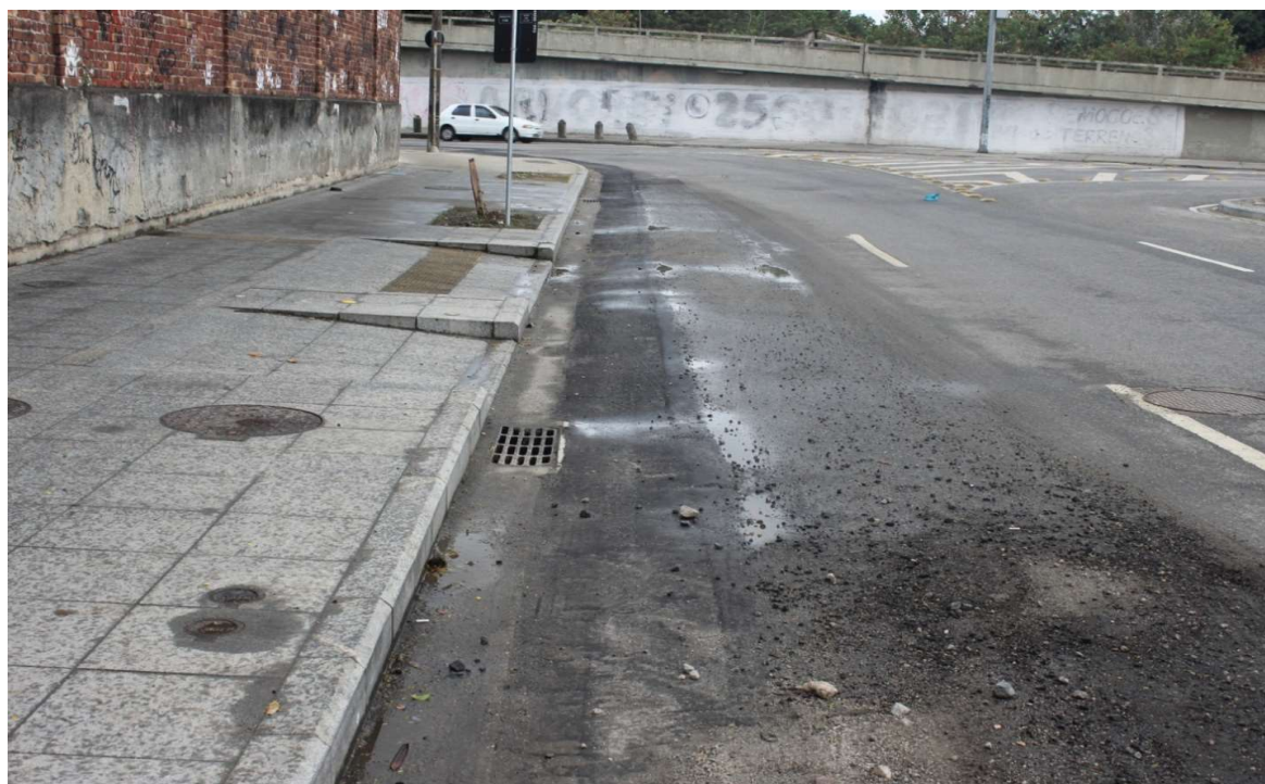
Foto 2 : Recomposição provisória na Avenida Pedro II.
