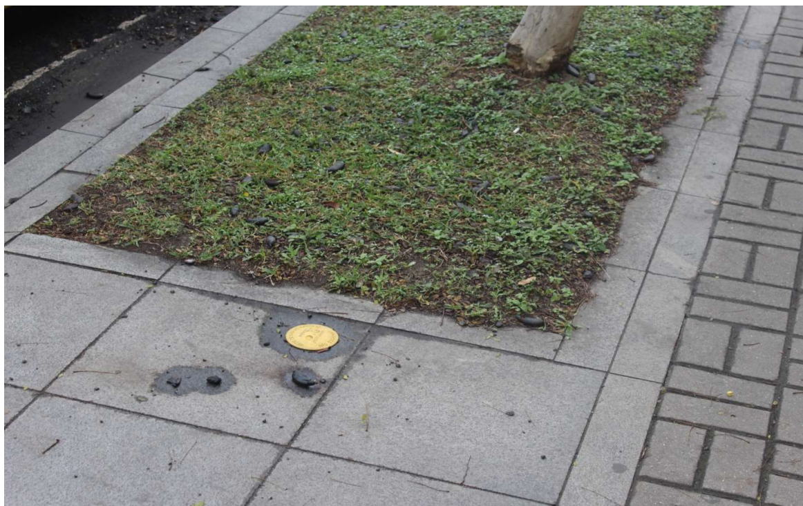
Foto 3 : Marco plano indicando presença de rede na Avenida Pedro II.
