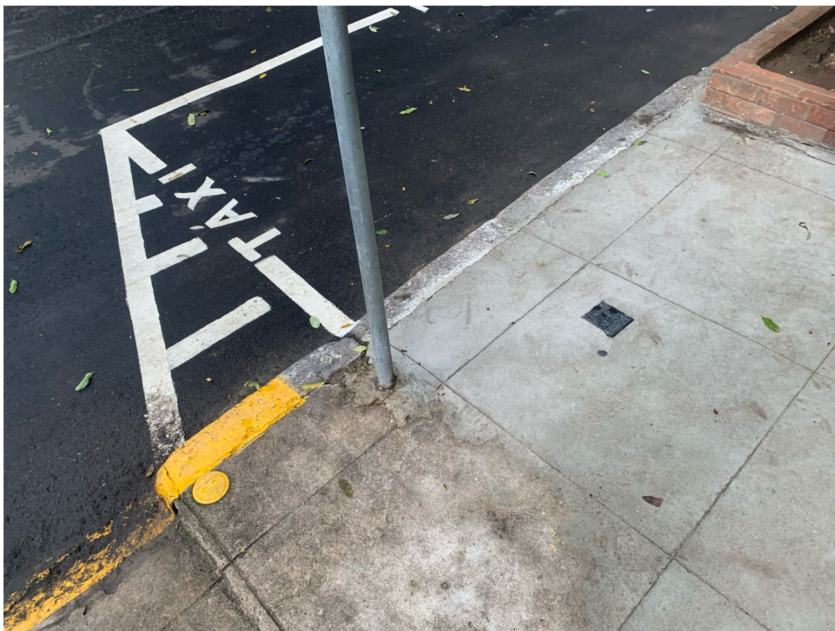
Foto 8: Trecho com recomposição permanente na calçada e na rodovia.
