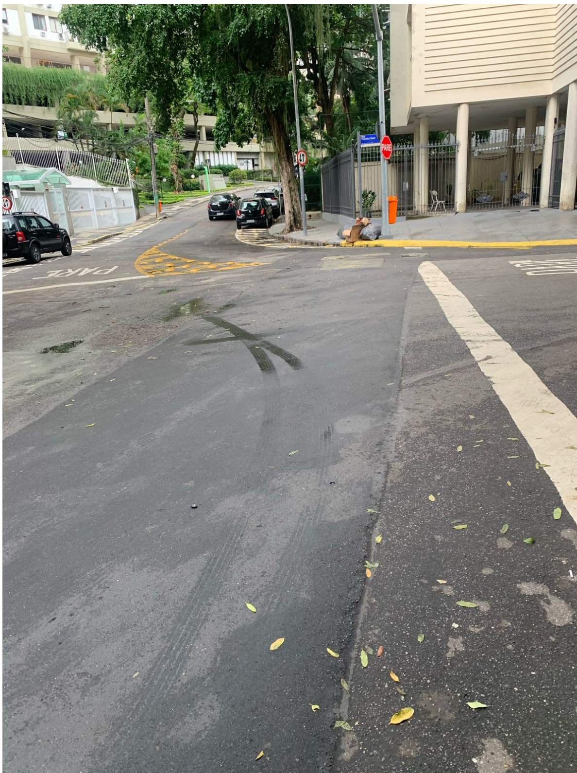
Foto 2: Trecho final da obra, com já a recomposição definitiva.
