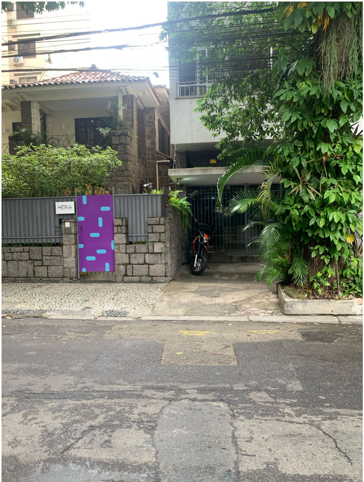
Foto 1: Trecho de início da obra com recomposição provisória.
