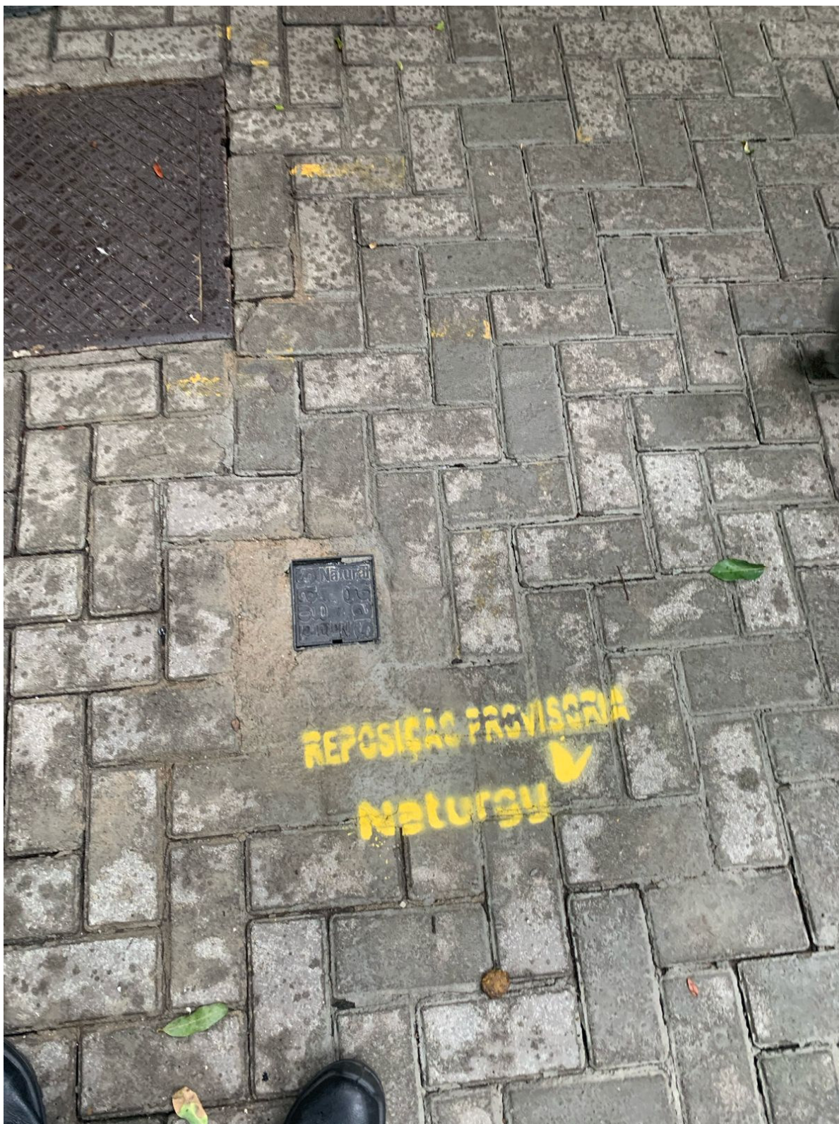
Foto 3: Recomposição provisória no passeio.
