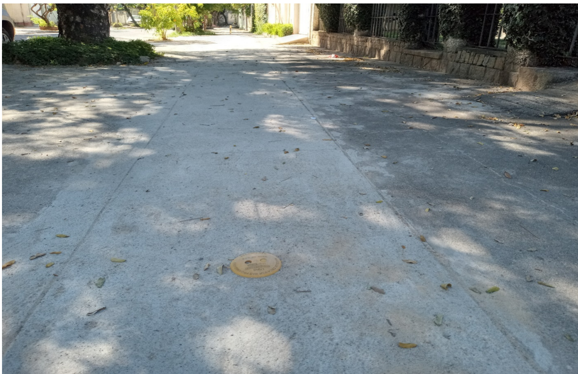
Foto 6: Recomposição da calçada e marco plano
