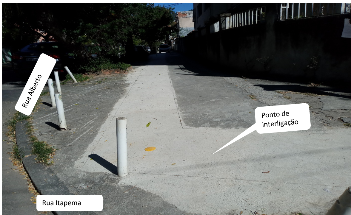
Foto 1: Início da rede
