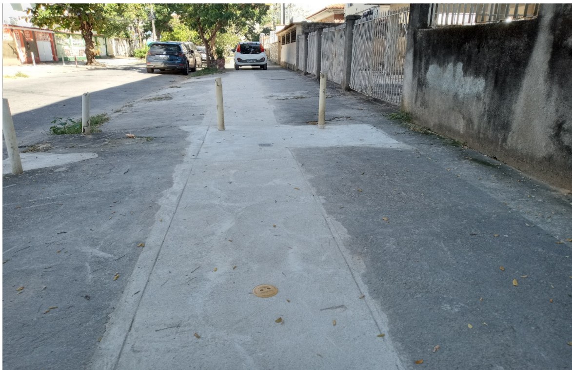
Foto 2: Recomposição da calçada e Marco plano
