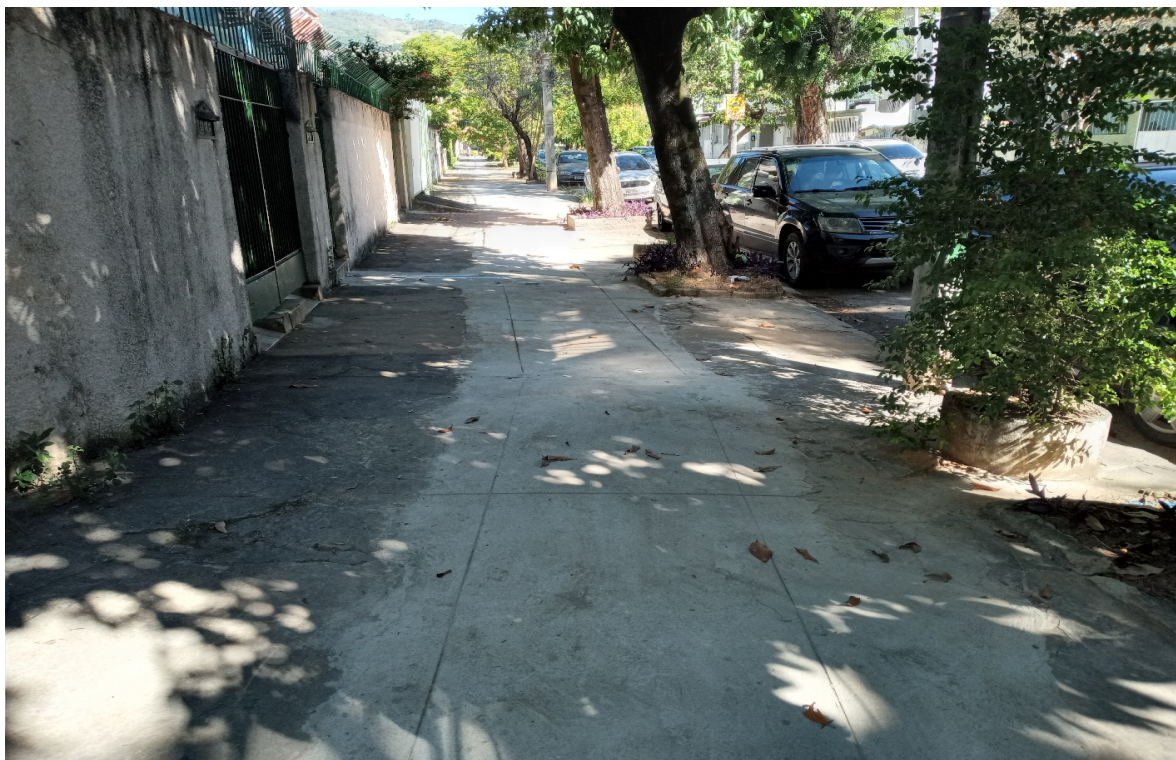
Foto 8: Recomposição da calçada
