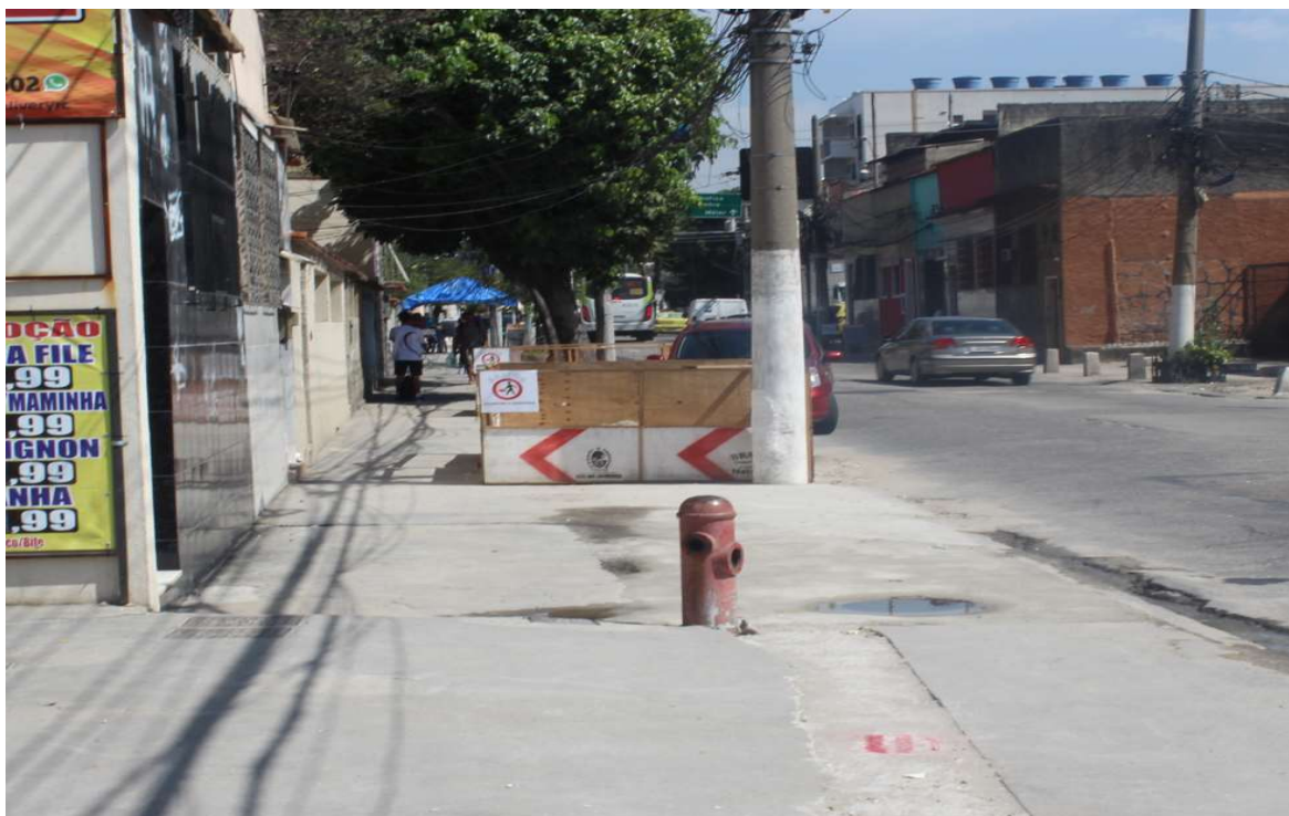
Foto 3 : recomposição provisória e sinalização
