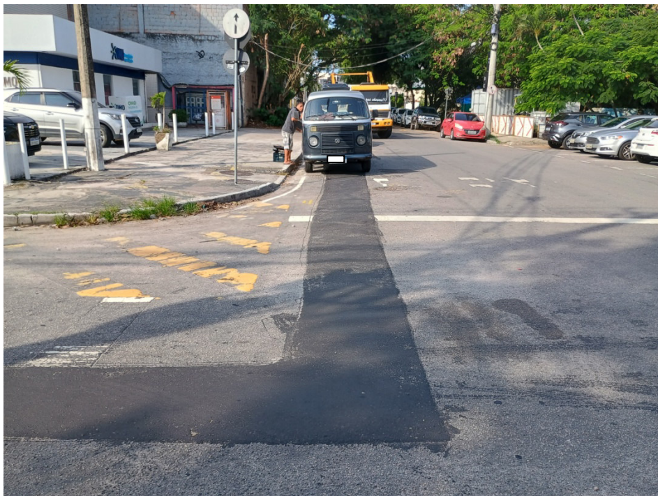
Foto 4: trecho de tubulação assentada na Rua Alberto Cavalcanti.
