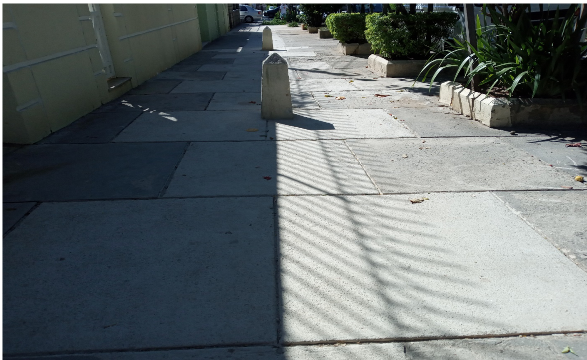
Foto 7: Recomposição da calçada
