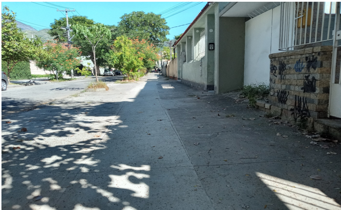
Foto 9: Recomposição da calçada
