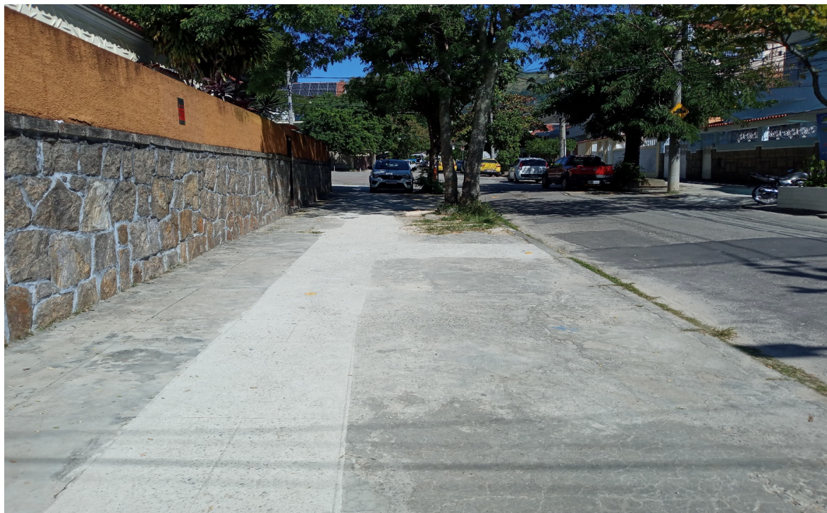
Foto 5: Recomposição da calçada
