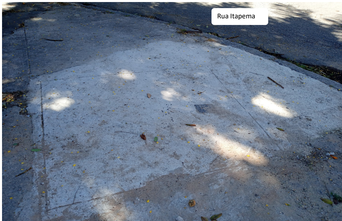
Foto 10: Ponto de interligação
