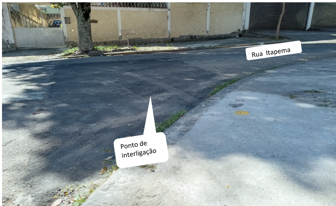
Foto 1: Início da rede
