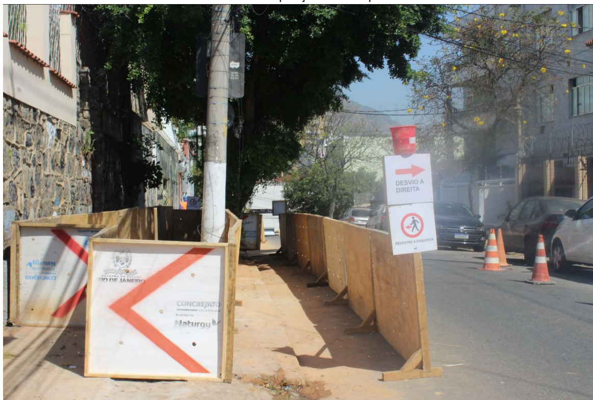
Foto 4: sinalização de obra
