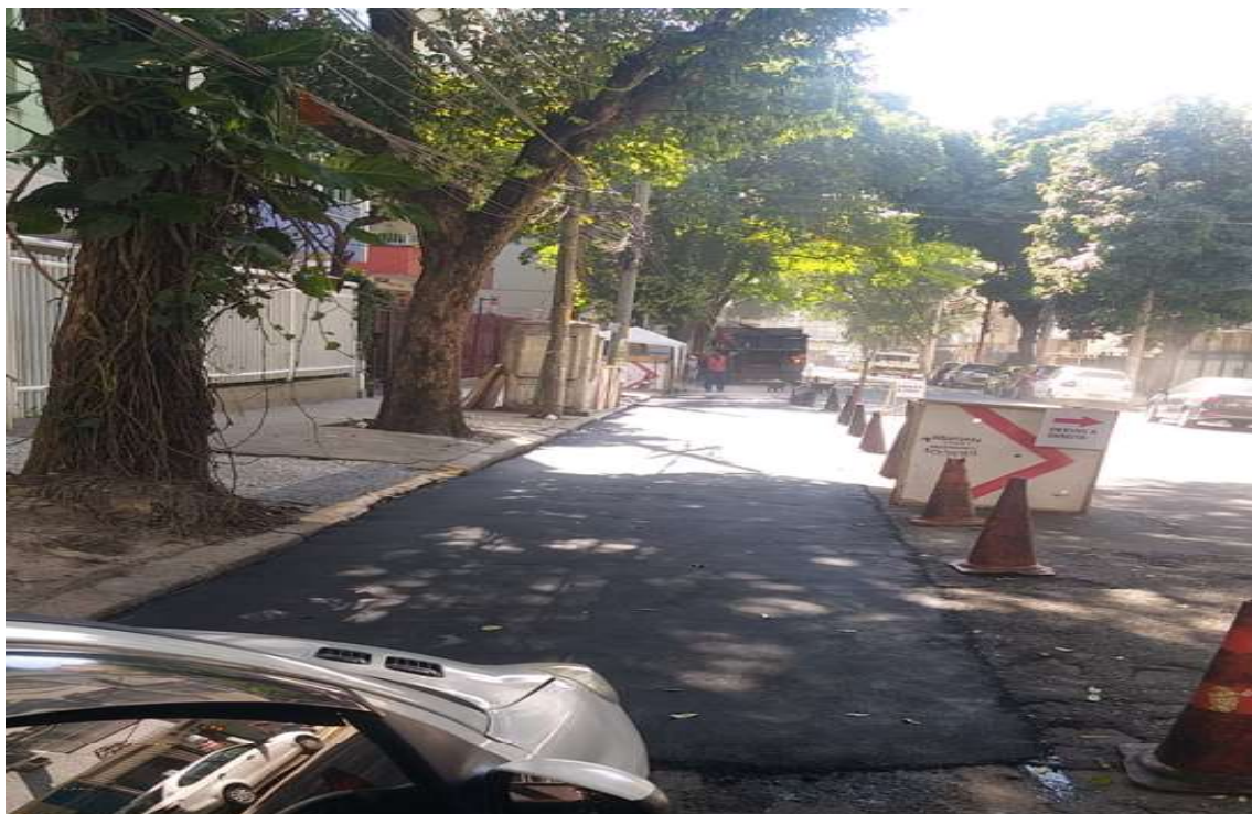
Foto 3 : recomposição de asfalto
