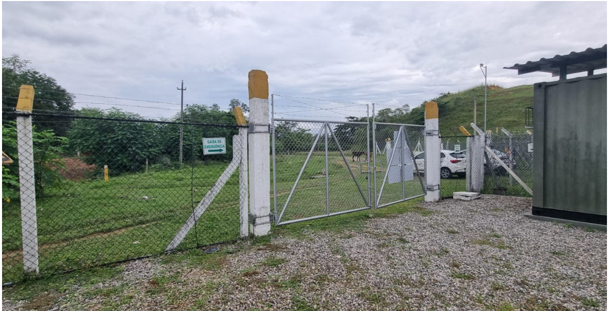
Foto 11: Sinalização de rota de fuga/saída de emergência.
