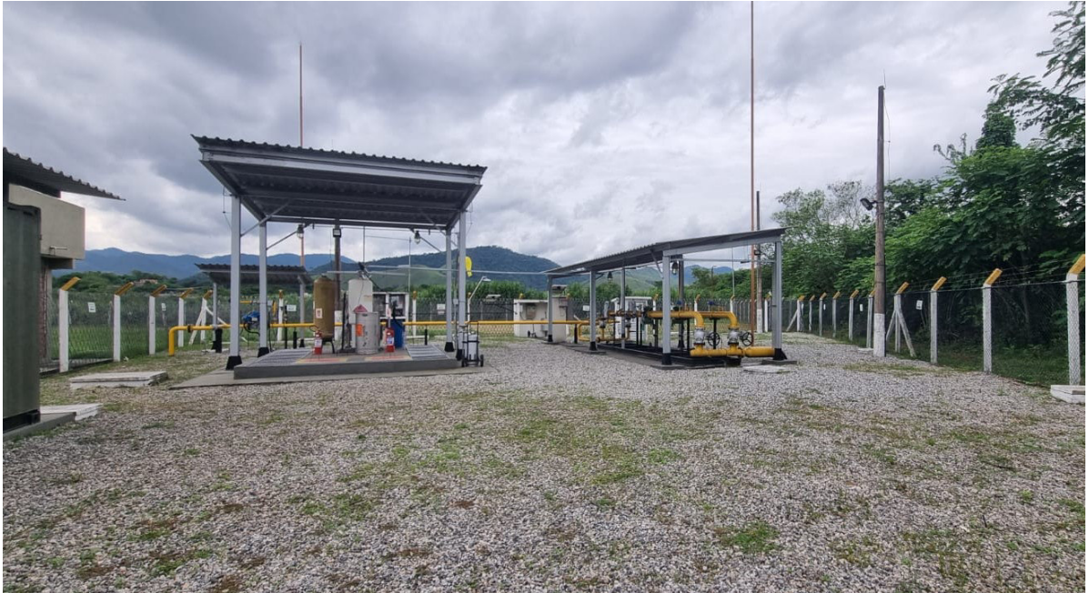
Foto 3: Vista frontal da estação.
