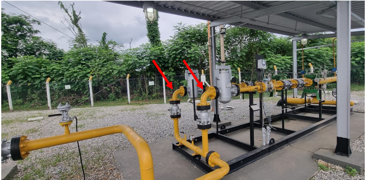
Foto 7: Estação de regulação e medição, com destaque para as duas linhas do sistema.
