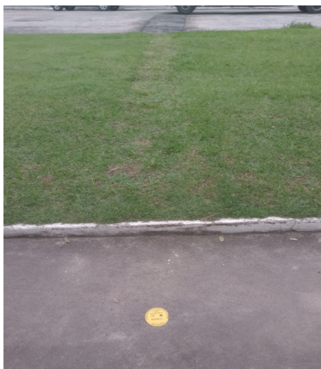
Foto 4: Instalação do marco plano e cruzamento de grama recomposta
