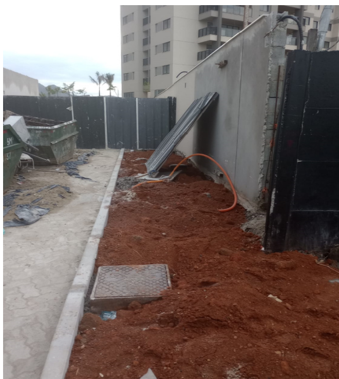
Foto 6: Caixa para ligação das redes interna e externa
