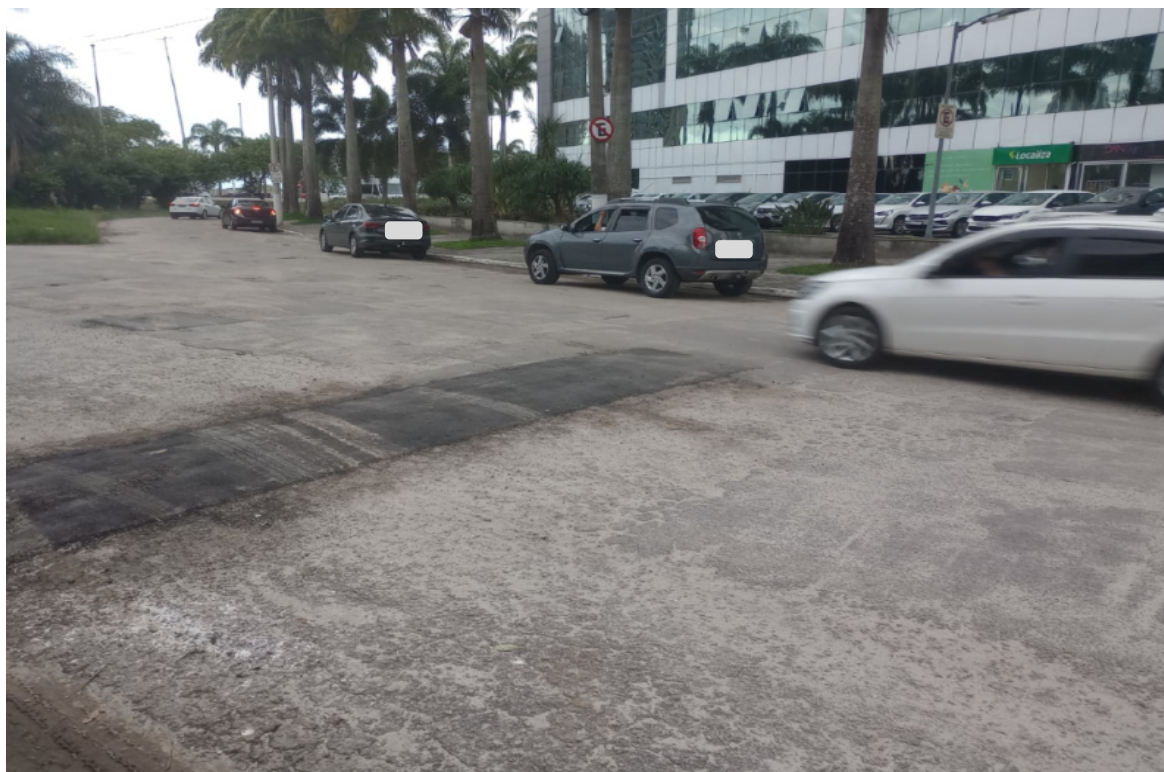
Foto 3: Cruzamento de pista (depois)
