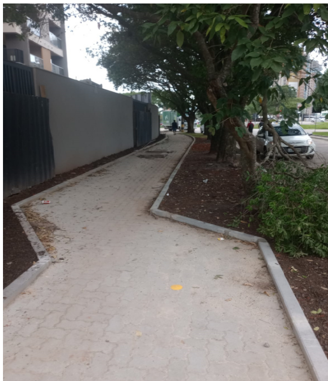
Foto 5: Marco plano instalado indicando presença de rede na calçada
