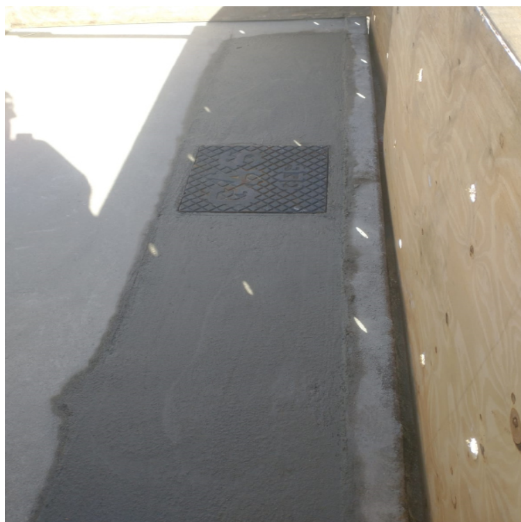
Foto 6: Afundamento de recomposição e caixa (depois)
