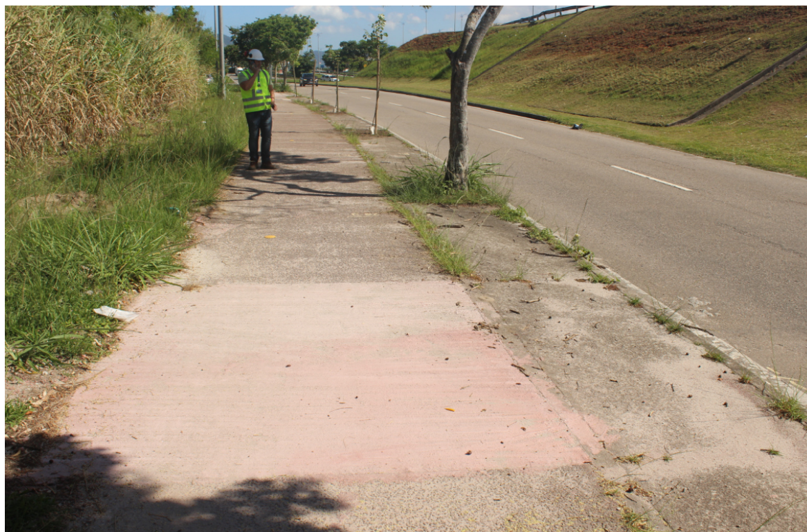
Foto 1: Ponto de partida do trecho executado
