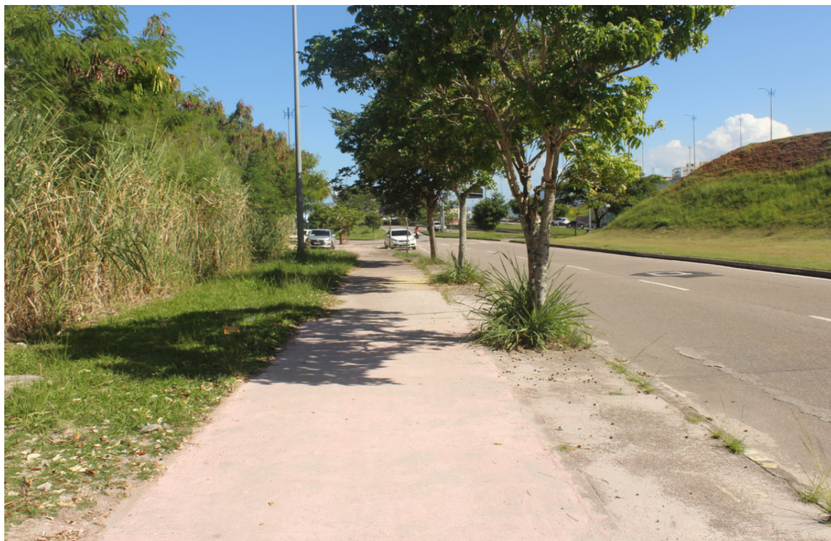
Foto 3: Continuidade da obra
