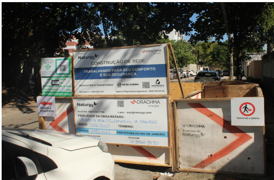
Foto 1: Identificação da obra, sinalização e isolamento
