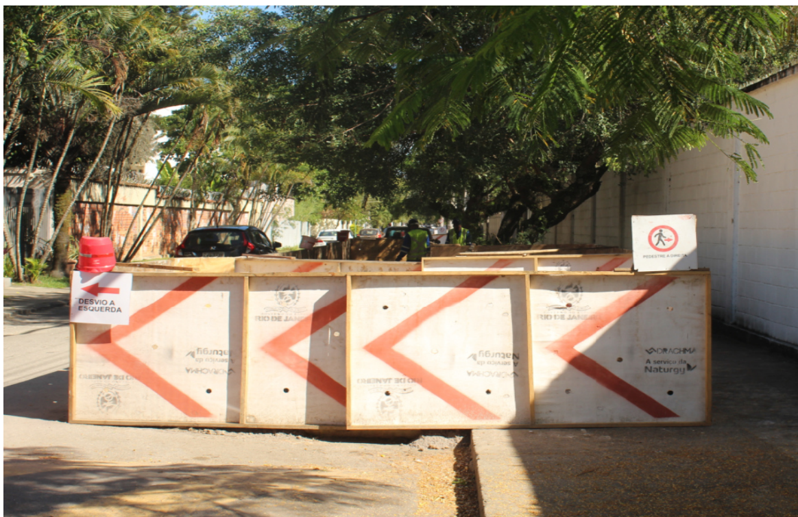
Foto 4: Isolamento e sinalização
