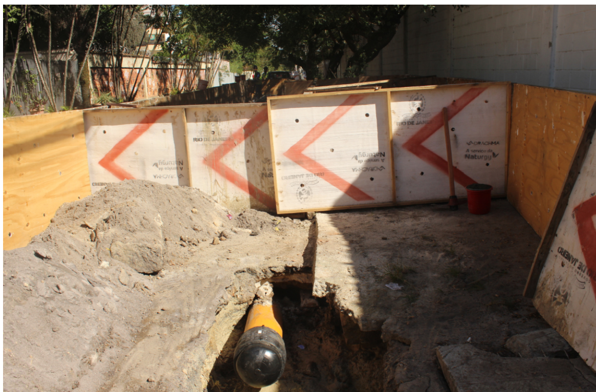
Foto 5: Ponta parada aguardando conexão em luva
