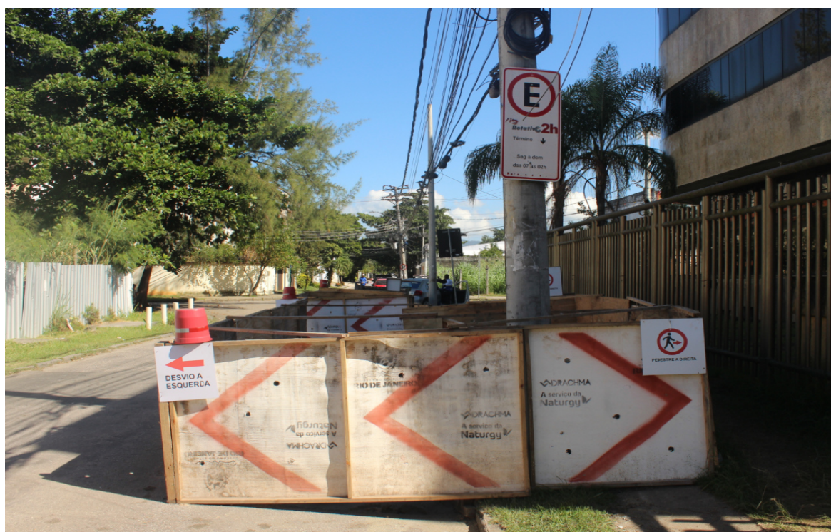
Foto 6: Armazenamento de material, isolamento e sinalização
